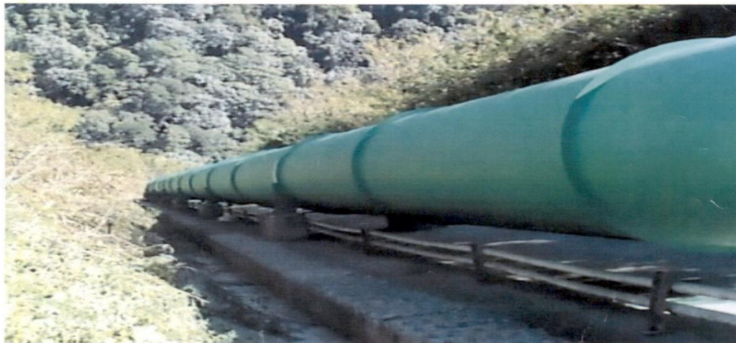
En la foto se muestra la tubería limpia y pintada
