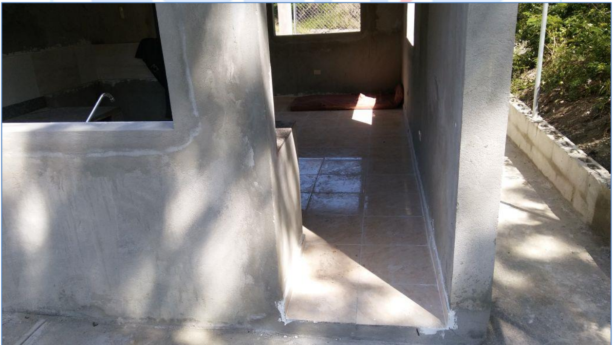
Pisos de cerámica colocados, Cuartel Militar Bao.
