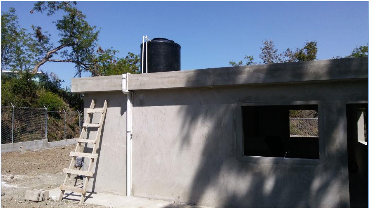
Instalación de tinaco, Cuartel Militar Bao.
