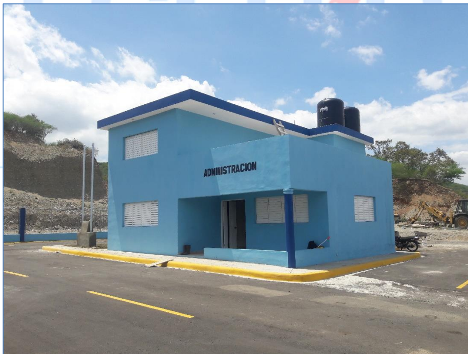
Vista general, Relleno Sanitario Bohechío.
