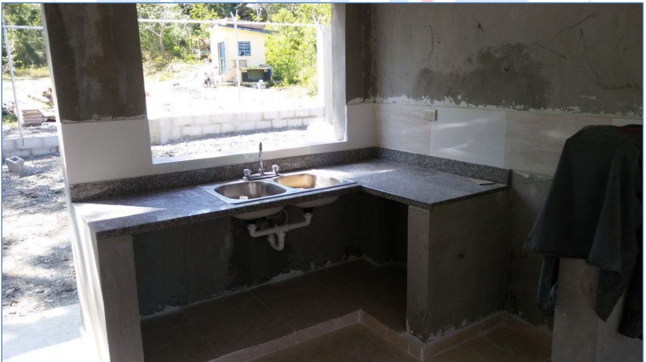
Colocación de meseta de cocina, Cuartel Militar Bao.
