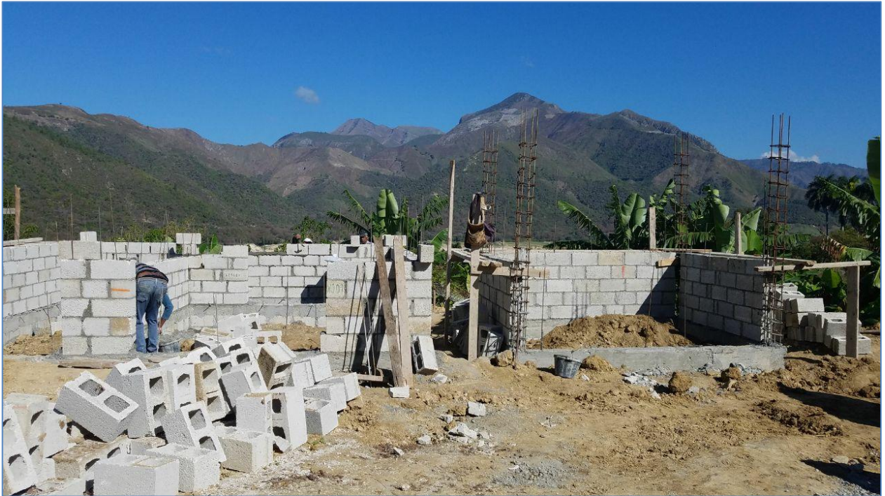
Colocación de bloques en casa de máquinas, Acueducto Sabaneta.
