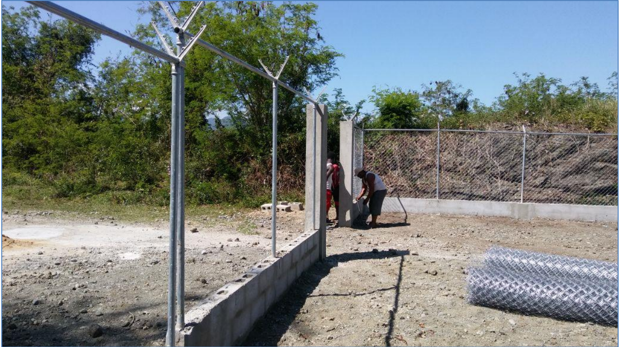
Colocación de malla en verja perimetral, Cuartel Militar Bao.
