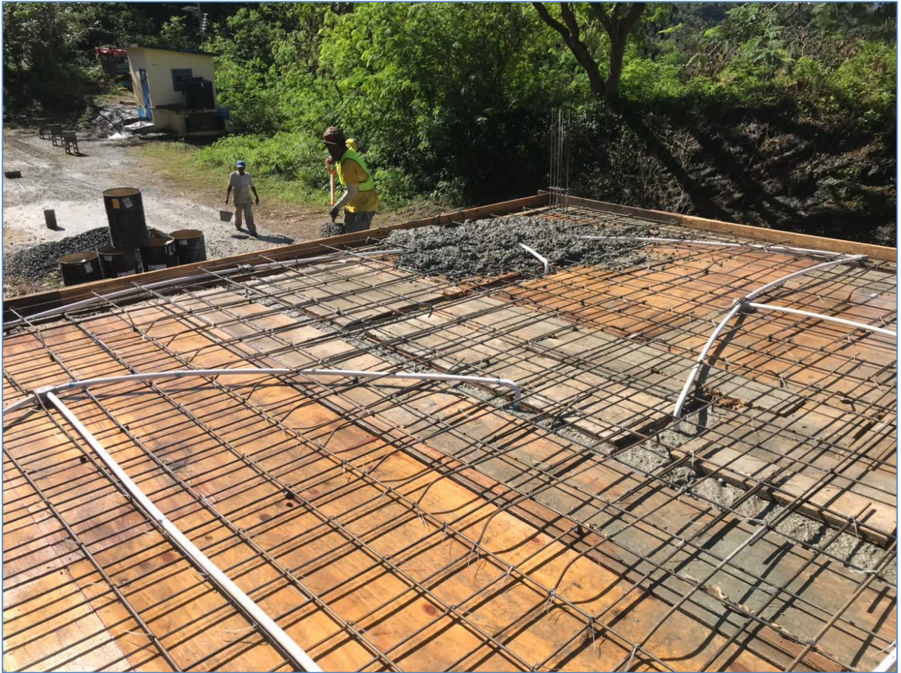
Losa armada e inicio de vaciado, Cuartel Militar Bao.
