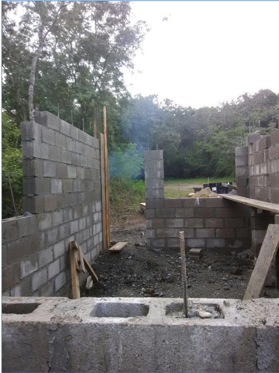
Colocación de muros de bloques, Cuartel Militar Bao.
