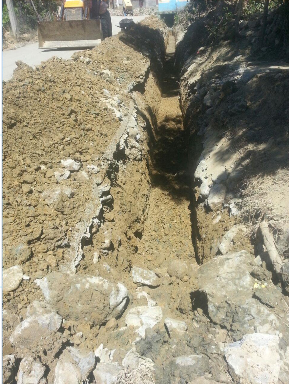
Excavación de zanja para colocación de tuberías, Acueducto Sabaneta
