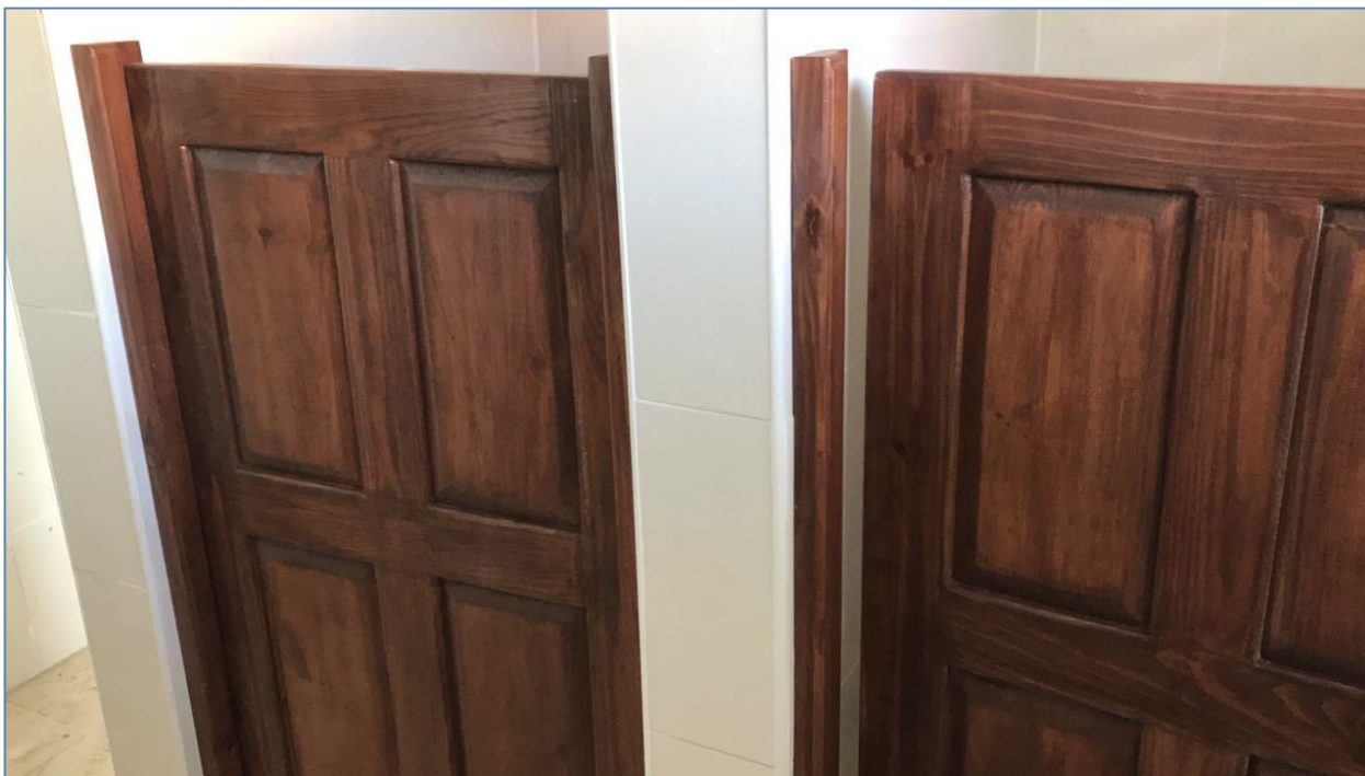
Colocación de puertas interiores, Relleno Sanitario Bohechío.
