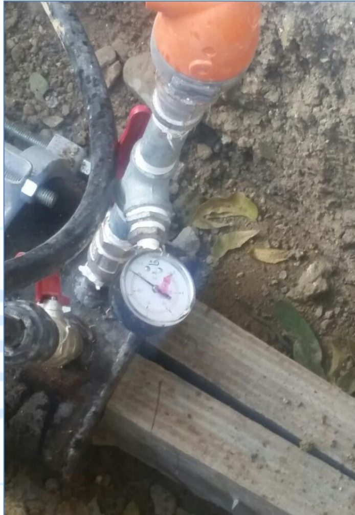
Instalación de bomba para pruebas de presión, Acueducto Sabaneta.
