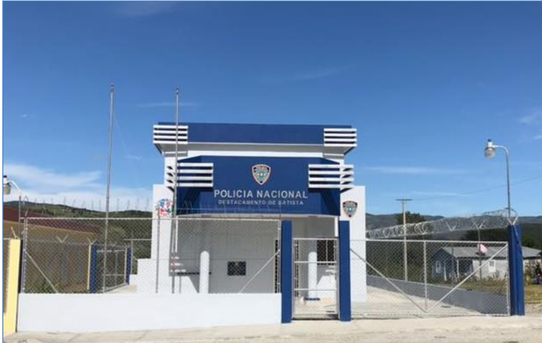
Vista general, Destacamento Batista
