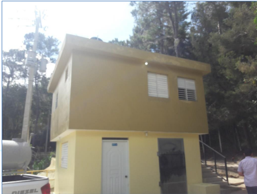
Vista general, Caseta de guardia en el Salto de Constanza.
