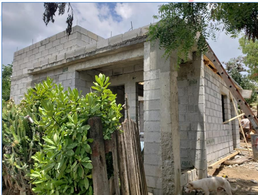
Colocación de zinc en techo, casa del Sr. Adriano Jiménez, Viviendas Económicas.
