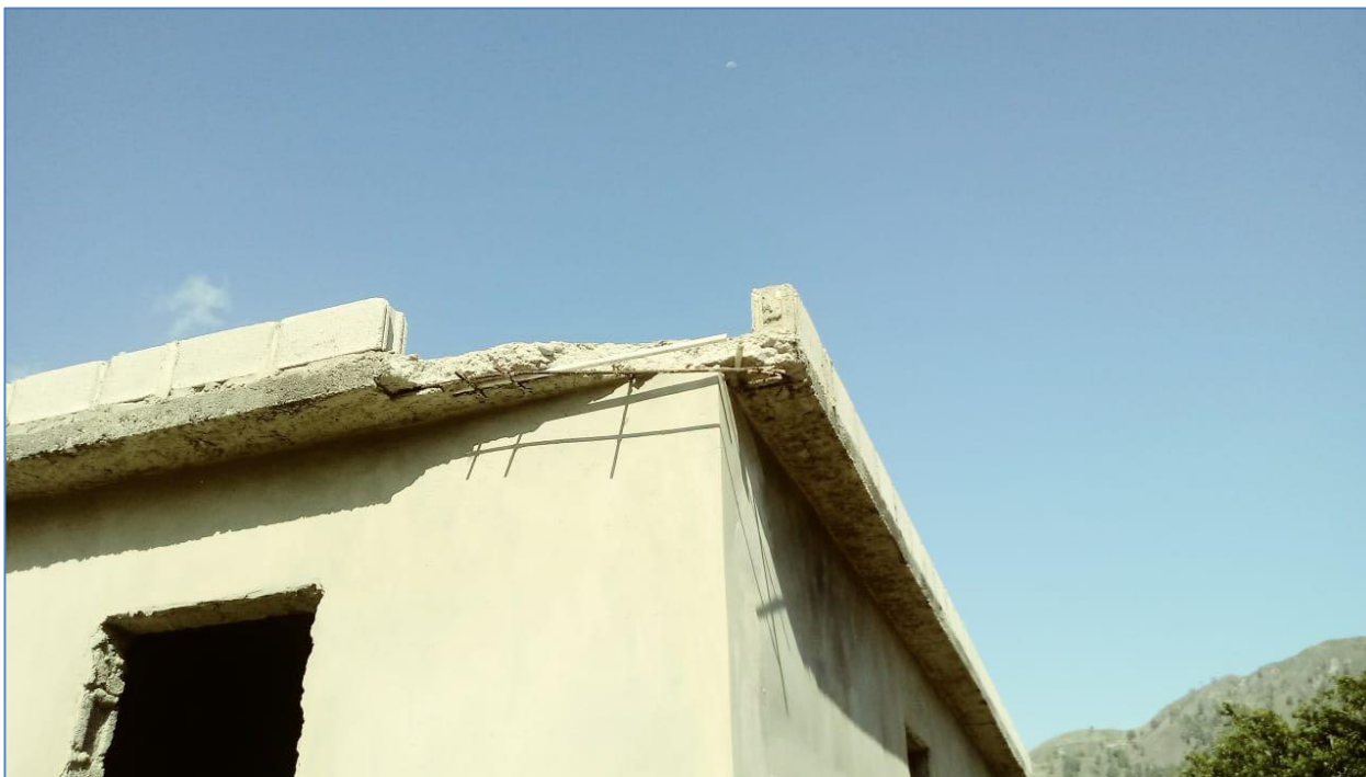
Colocación de bloques en antepecho, Centro de Atención Primaria, Vallejuelo.
