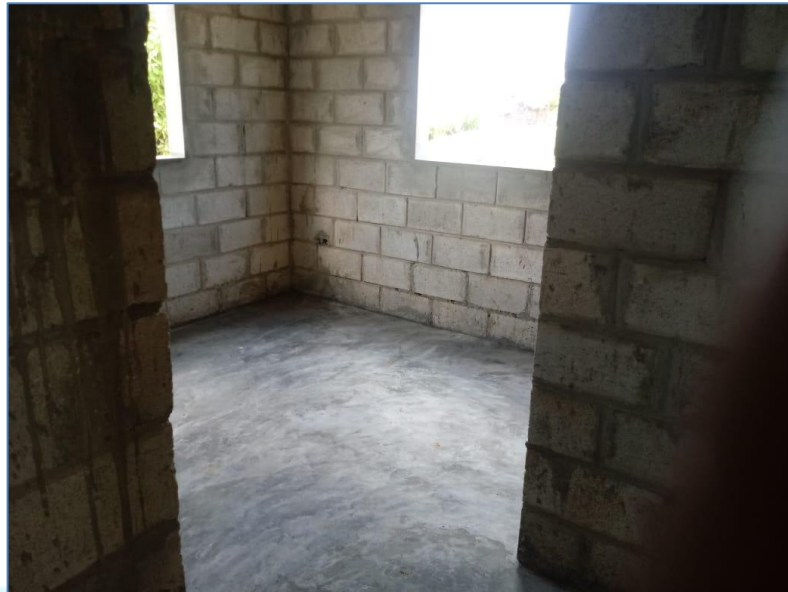
Hormigón en pisos, casa del Sr. Juan Suero de los santos, Viviendas Económicas.
