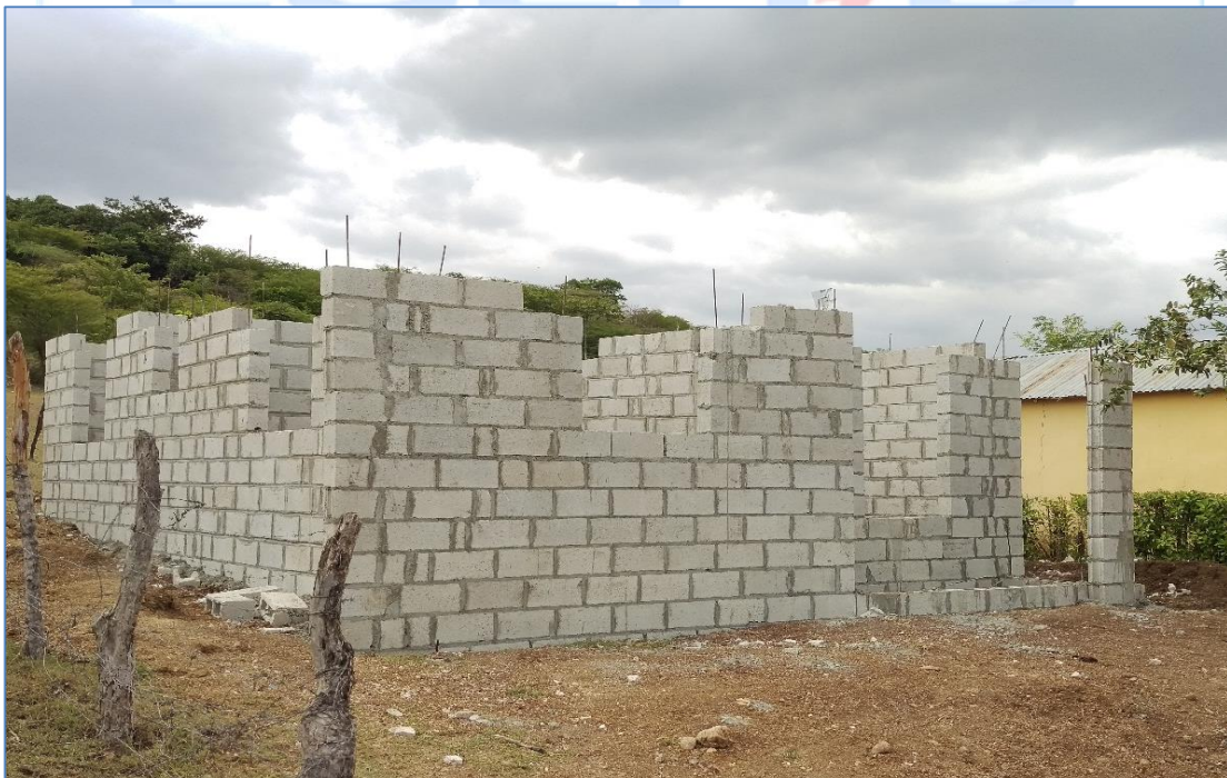
Colocación de bloques sobre nivel de piso, casa del Sr. Cesar Durán, Viviendas Económicas.
