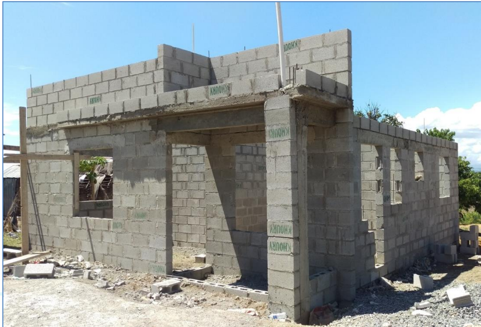
Colocación de bloques en antepecho, casa del Sr. Gustavo Perdomo, Viviendas Económicas.
