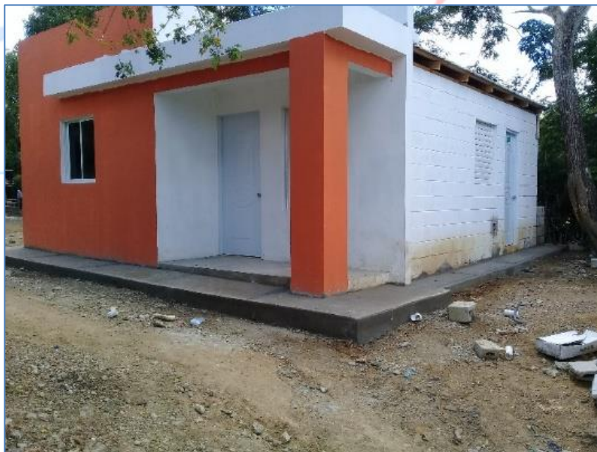
Aplicación de pintura, casa del Sr. Pedro Nolasco, Viviendas Económicas.
