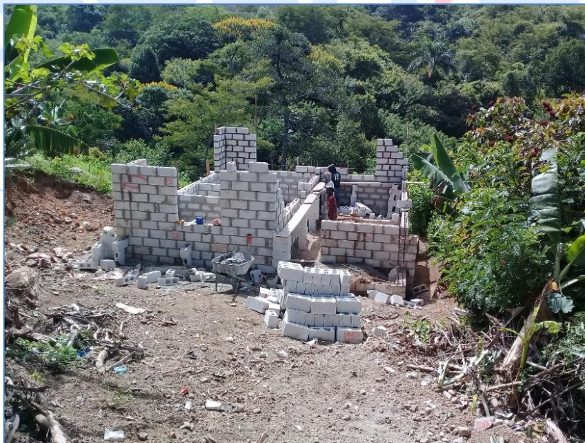
Bloques a nivel de dintel, casa de la Sra. Edilenia Ramírez, Viviendas Económicas.
