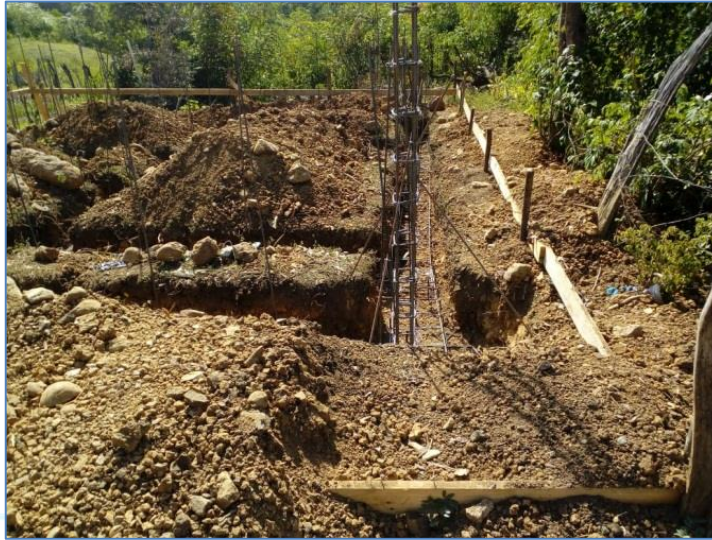
Excavación de zapatas, casa de la Sra. Isabel Jiménez, Viviendas Económicas.
