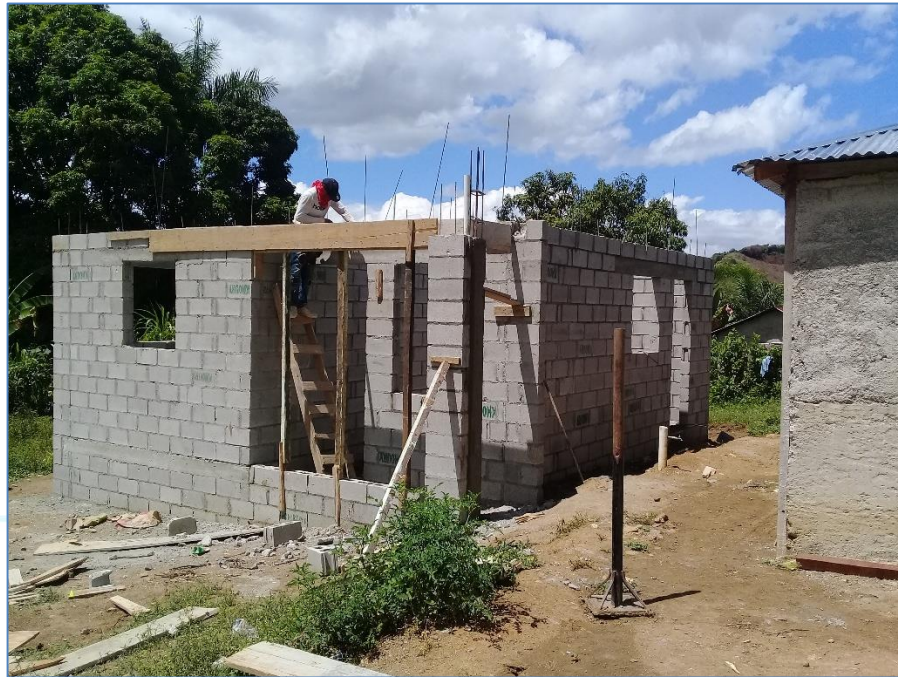
Vaciado de dinteles, casa de la Sra. Mary Leidy Ramírez, Viviendas Económicas.
