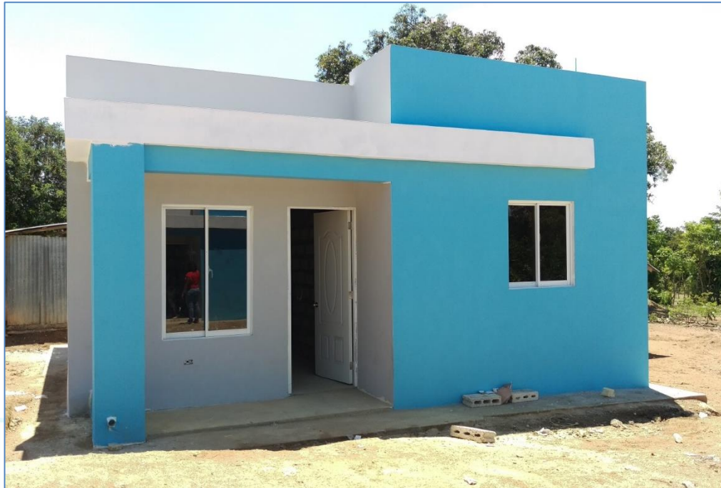
Pintura exterior, casa del Sr. José Jiménez, Viviendas Económicas.
