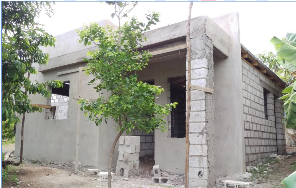
Colocación de zinc en techo, casa del Sr. Manuel Durán, Viviendas Económicas.
