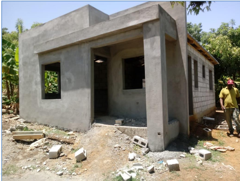
Colocación de pañete frontal, casa del Sra. Mercedes Suero, Viviendas Económicas.
