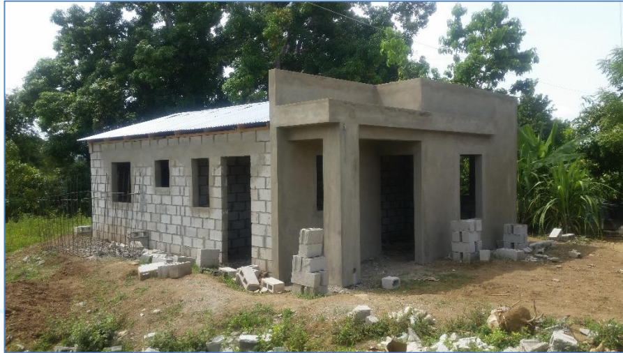
Colocación de pañete en fachada, casa del Sr. Pablo Mateo, Viviendas Económicas.
