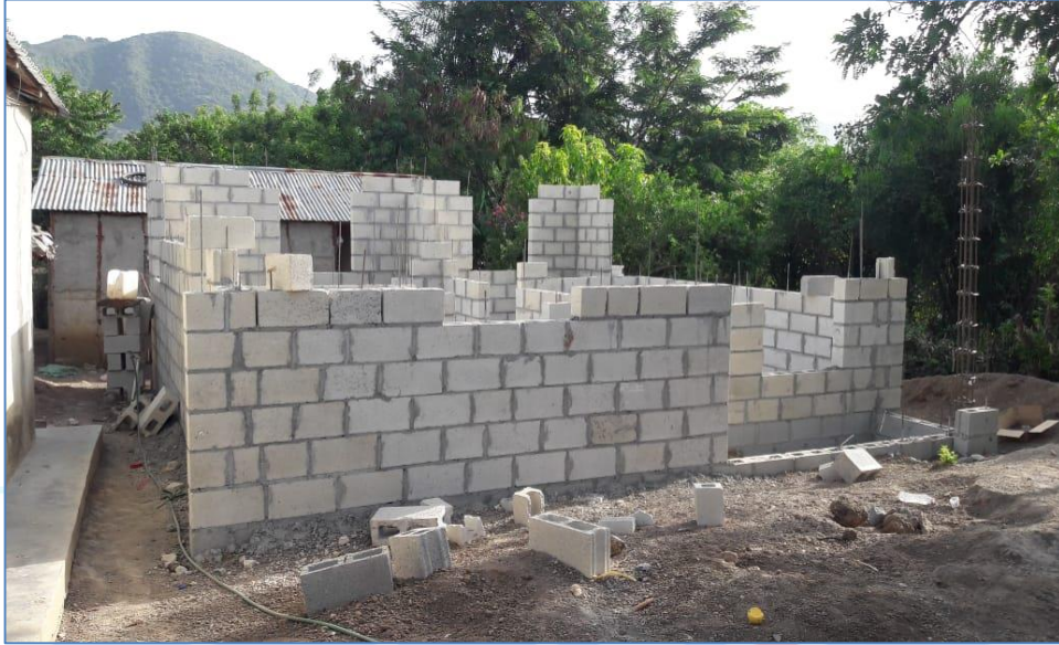
Colocación de bloques sobre nivel de piso, casa del Sr. Arateides Suero, Viviendas Económicas.
