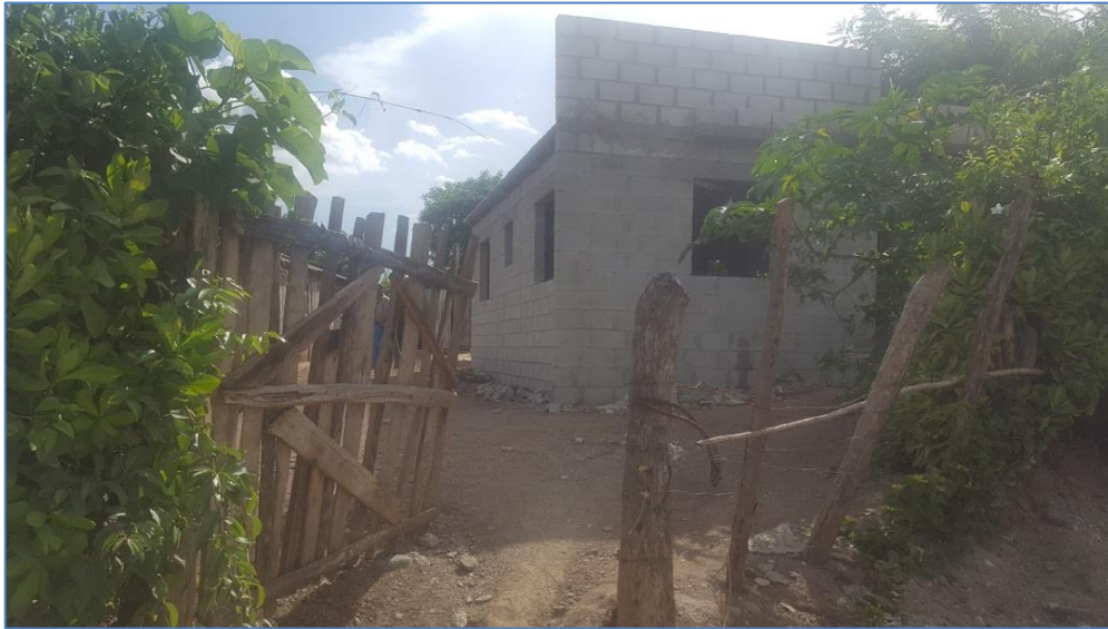
Colocación de zinc en techo, casa del Sr. Merido Mateo, Viviendas Económicas.
