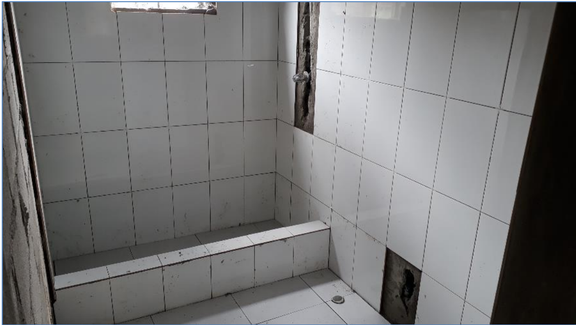
Revestimientos en baño, casa del Sr. Reinaldo del Carmen, Viviendas Económicas.
