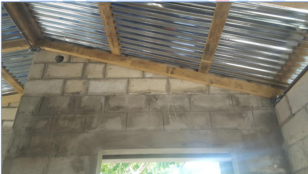
Instalaciones eléctricas, casa del Sra. Yolanda Ramírez, Viviendas Económicas.
