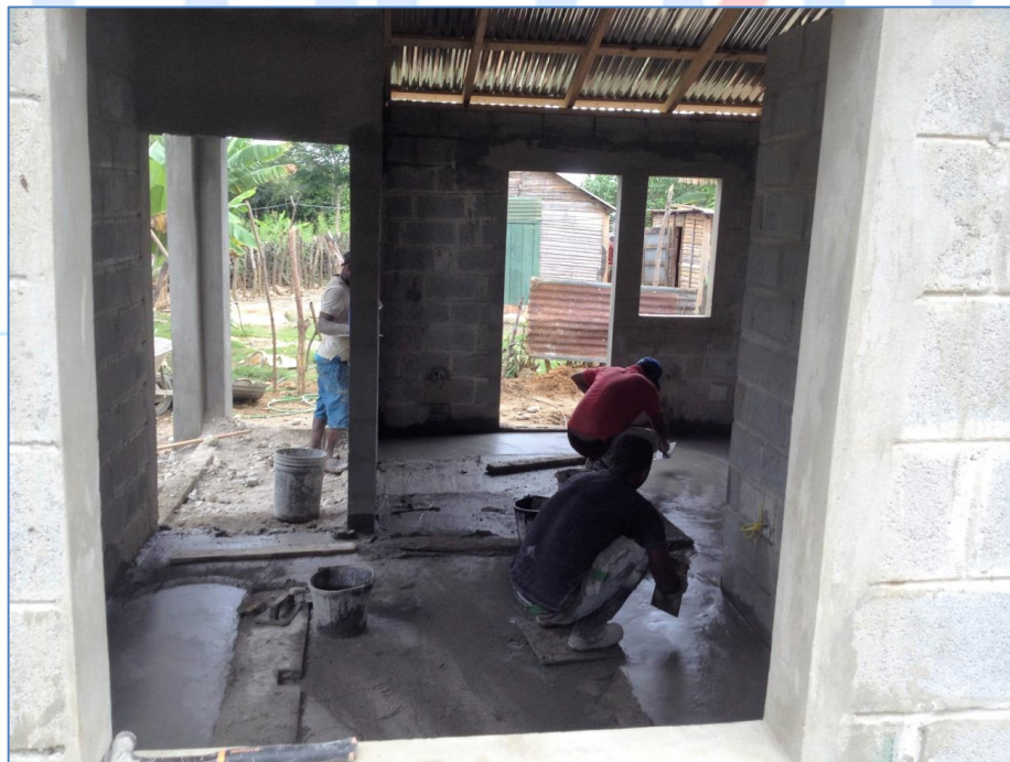
Vaciado y pulido de pisos, casa del Sr. Tulio Jiménez, Viviendas Económicas.
