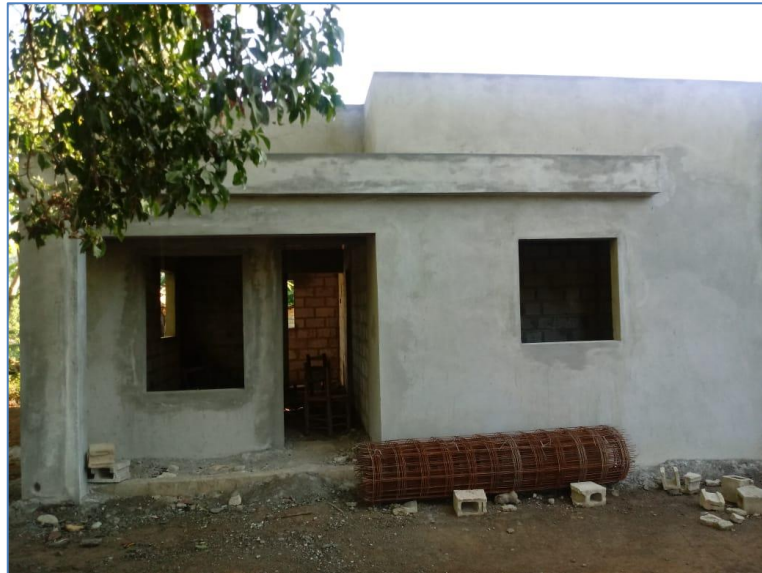
Terminación de mochetas, casa del sr. Aquilino Arno, Viviendas Económicas.
