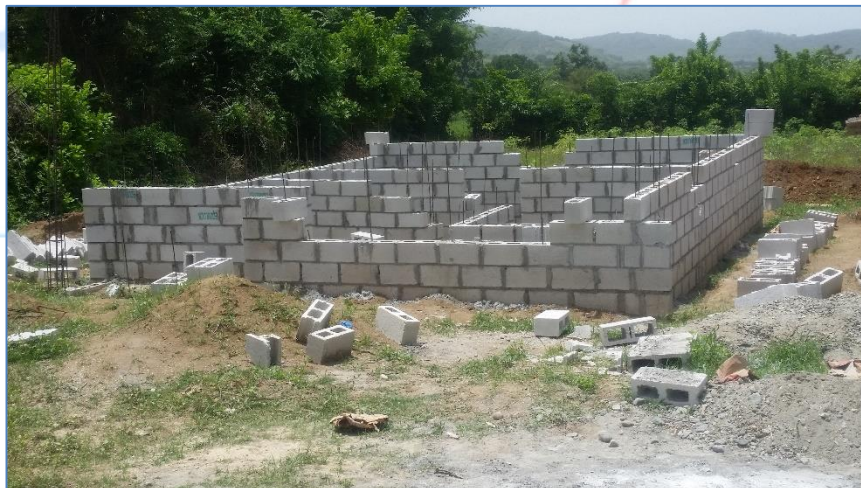
Colocación de bloques bajo nivel de piso, casa del Sra. Dileidy Mateo, Viviendas Económicas.
