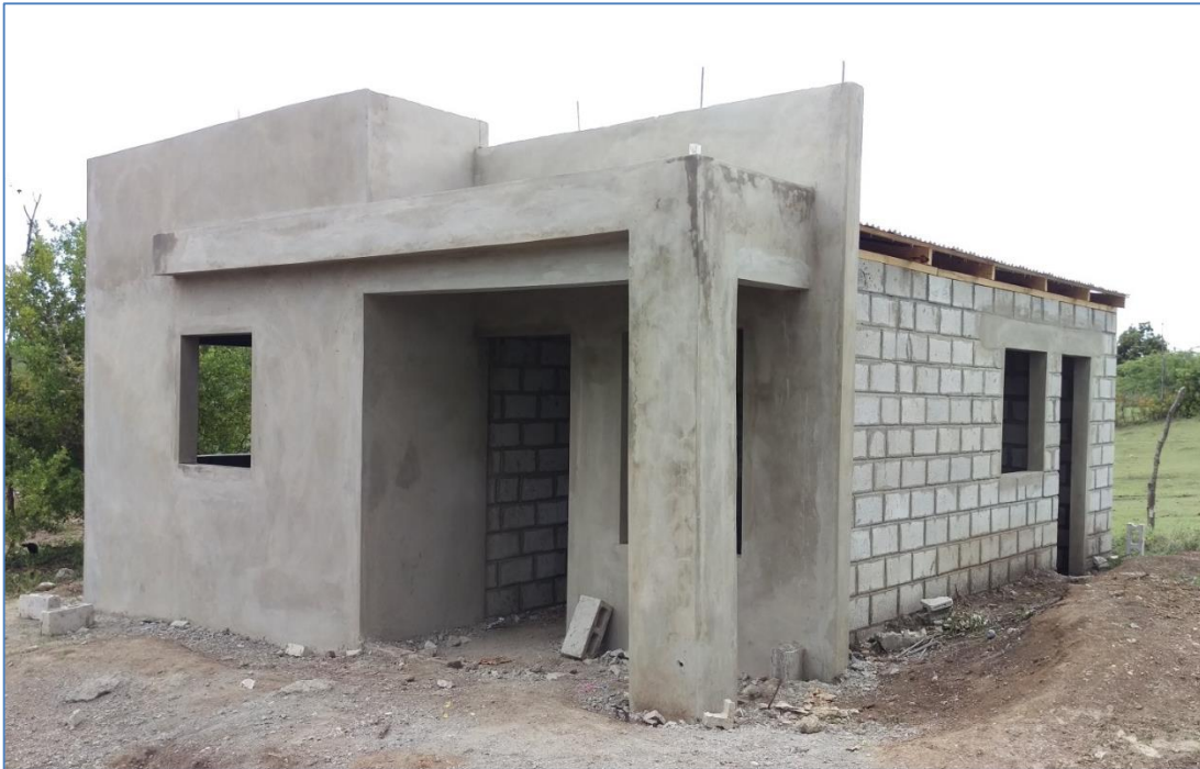
Colocación de zinc en techo, casa de la Sra. Elvira Solís, Viviendas Económicas.
