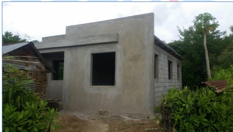
Pañete en fachada, casa del Sra. Ricura Jiménez, Viviendas Económicas.
