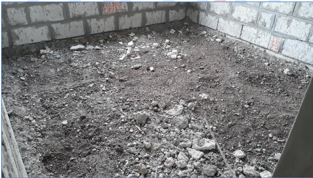
Colocación de relleno de piso, casa de la Sra. Aurora Suero, Viviendas Económicas.
