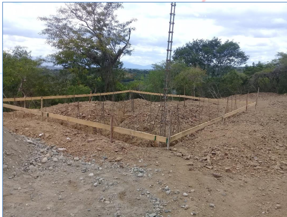
Colocación de acero de zapatas, casa del Sr. Ramón Ramírez, Viviendas Económicas.
