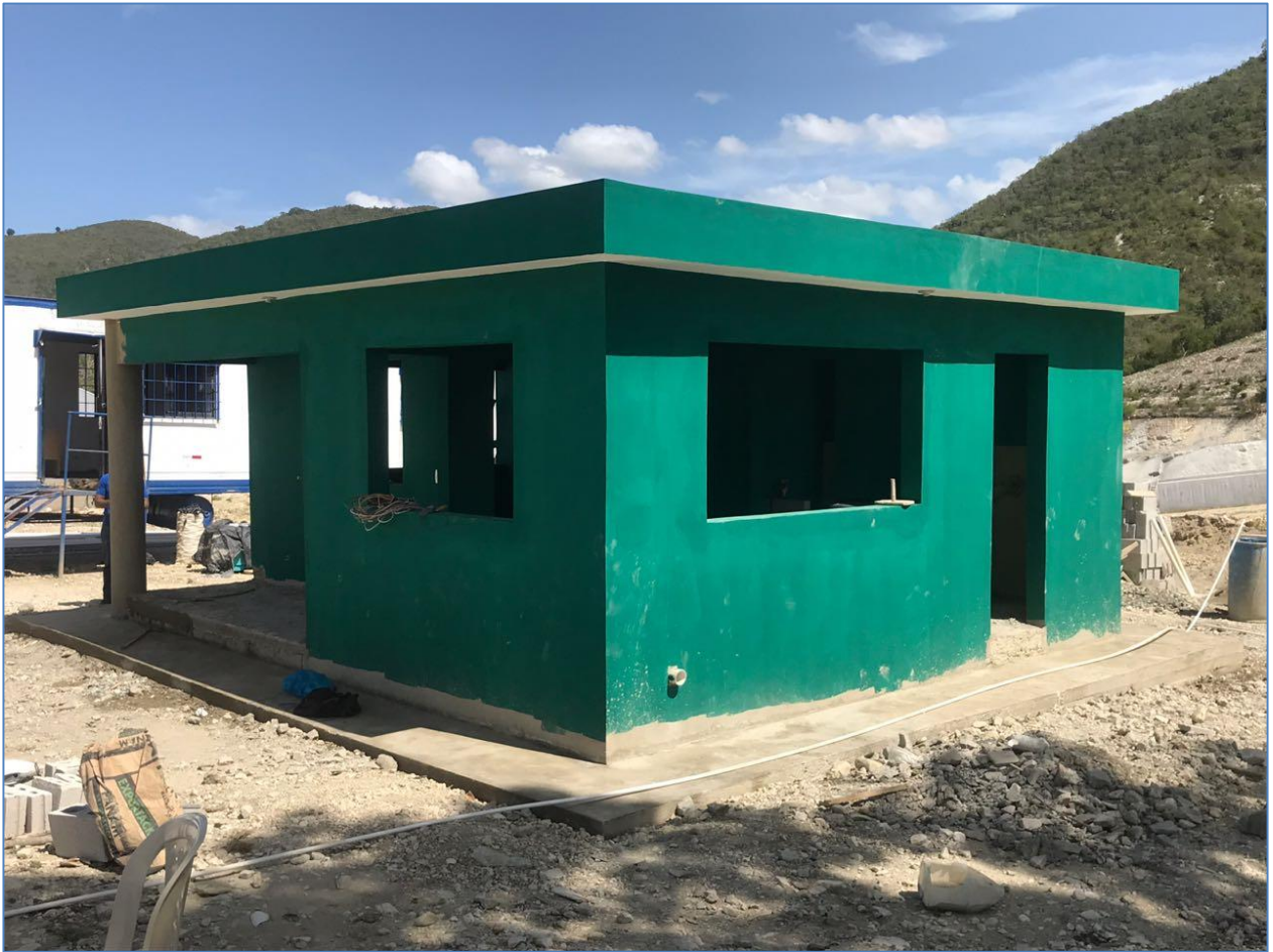
Aplicación de Pintura Exterior, Cuartel Militar Dos Bocas, San Juan de la Maguana.
