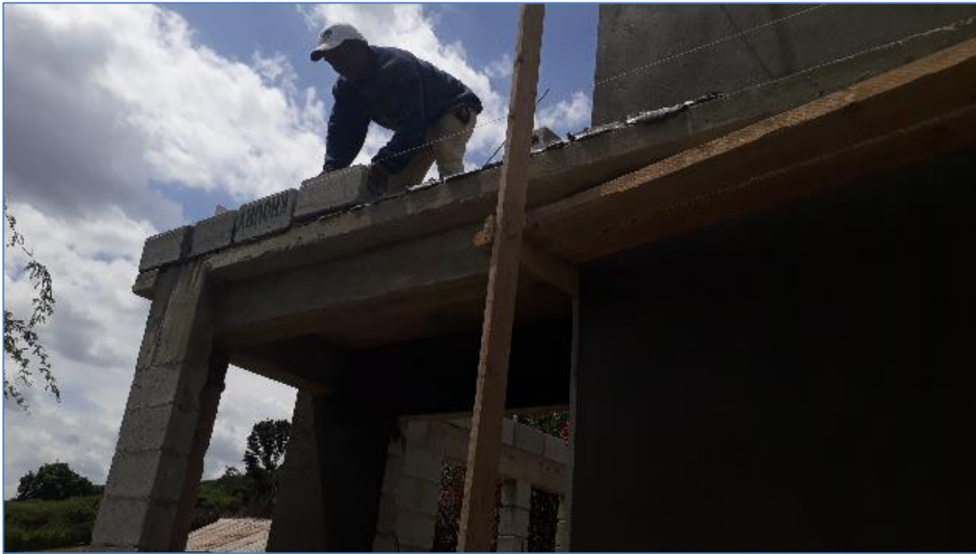
Colocación de bloques en antepecho, casa del Sra. Morena Suero, Viviendas Económicas.
