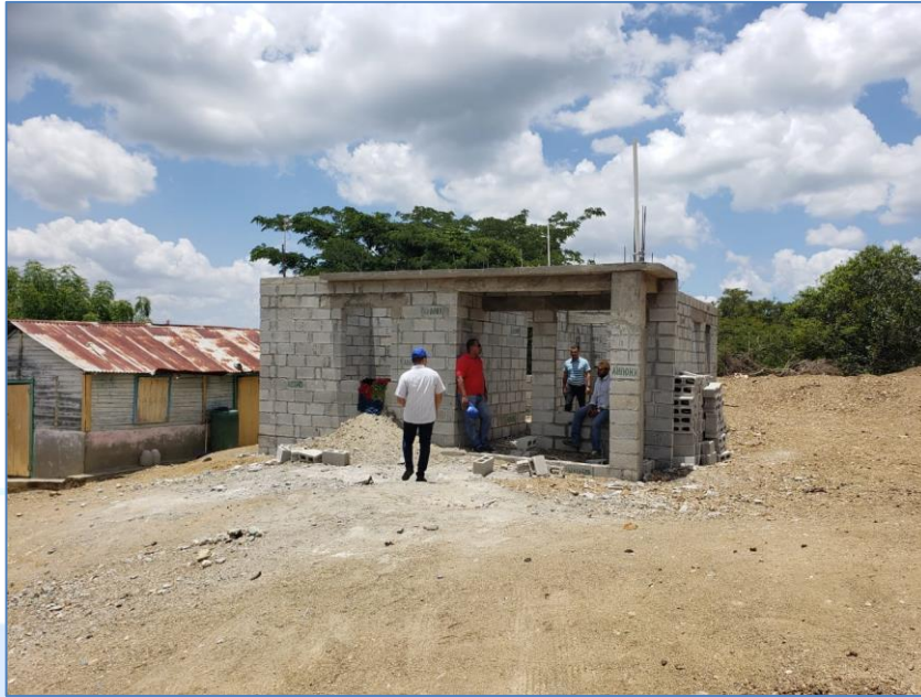
Vaciado de losa, casa del Sr. Wilkin Jiménez, Viviendas Económicas.
