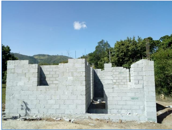
Colocación de bloques hasta nivel de dintel, casa del sr. Andric Lebrón, Viviendas Económicas.
