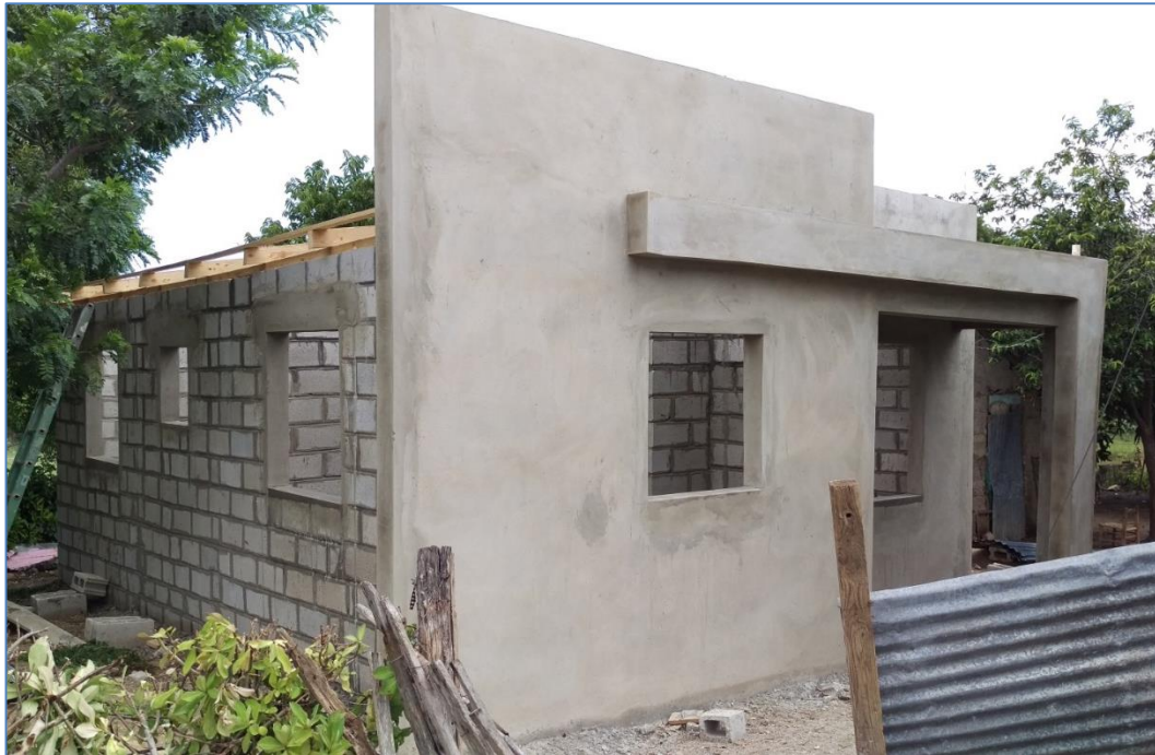
Colocación de pañete frontal, casa del Sr. Manuel Genao, Viviendas Económicas.
