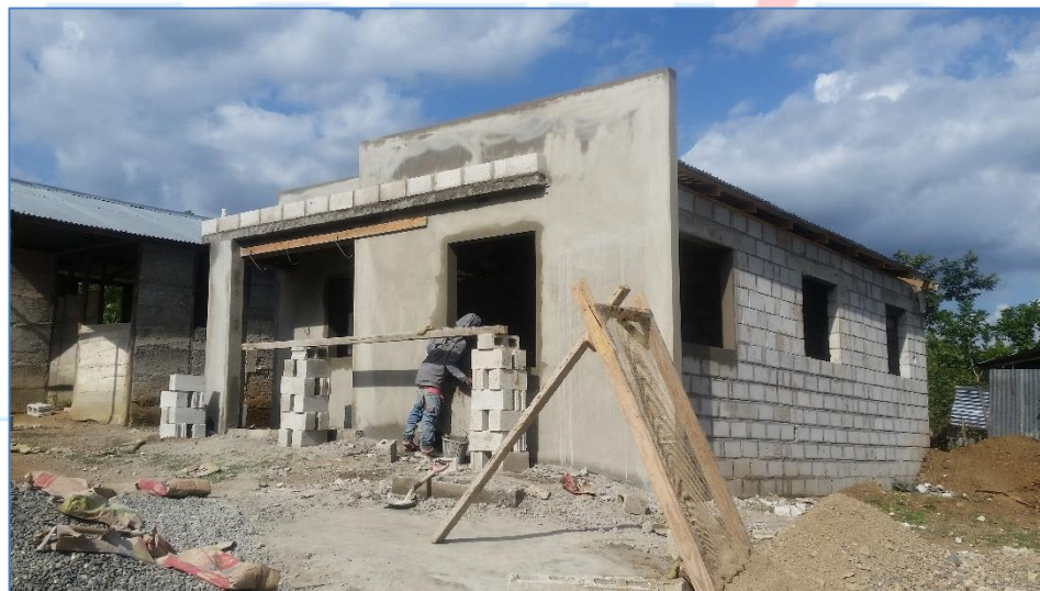
Pañete en fachada, casa del Sra. Oliva Valdez, Viviendas.
