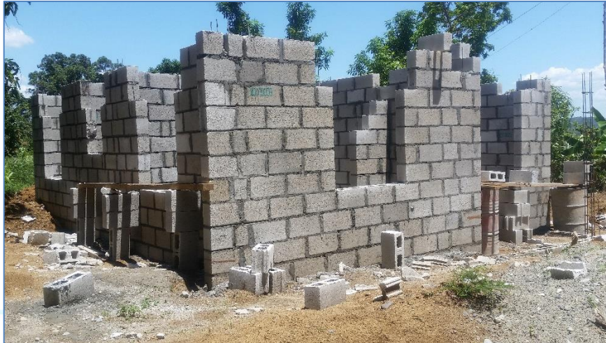
Colocación de bloques sobre nivel de piso, casa del Sr. Relle Arno Ramírez, Viviendas Económicas.
