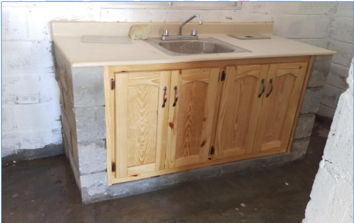
Colocación de tope de cocina, casa del Sr. Algenis Perdomo, Viviendas Económicas.
