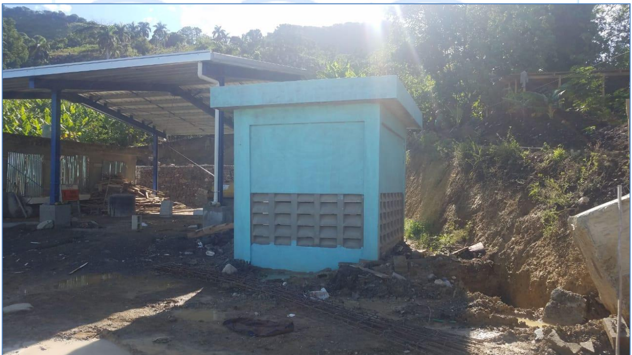
Aplicación de pintura exterior, Acueducto Sabaneta.
