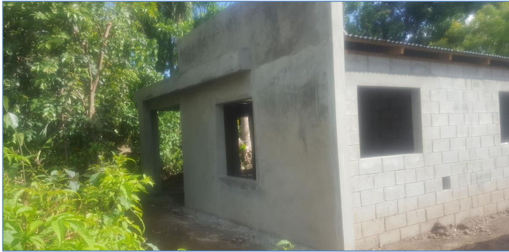
Colocación de zinc en techo, casa del Sra. Martina Arno, Viviendas Económicas.
