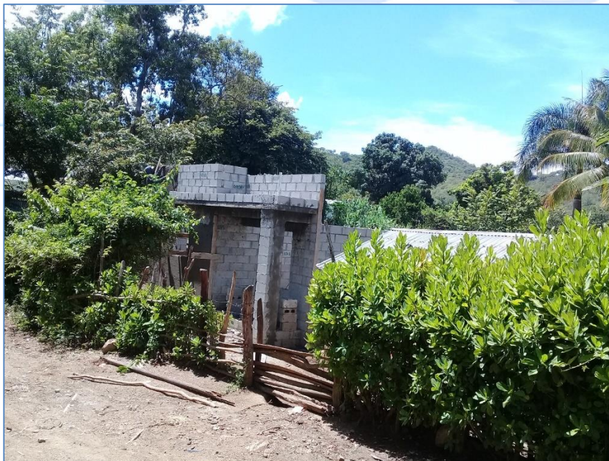
Pañete en fachada, casa de la Sra. Altagracia Ramírez, Viviendas Económicas.
