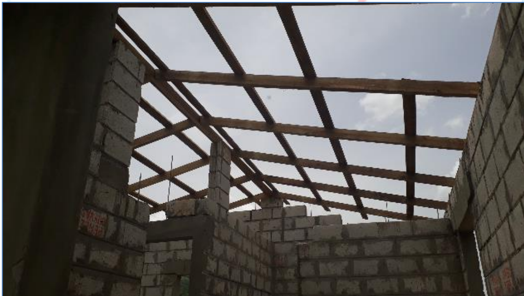
Colocación de estructura de madera en techo, casa del Sr. Juan Alcántara, Viviendas Económicas.
