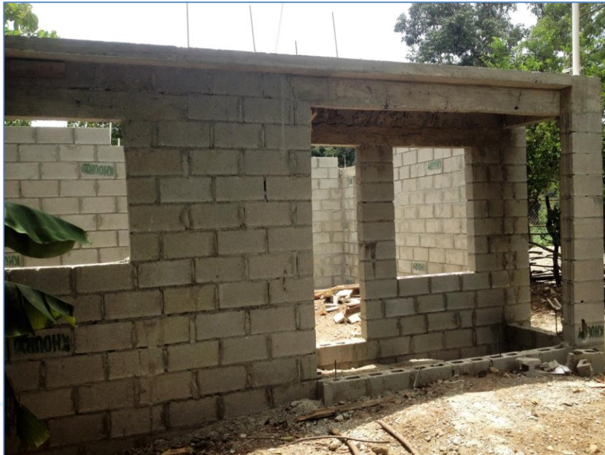
Vaciado de losa y columna, casa del Sr. Marcelino Ramírez, Viviendas Económicas.
