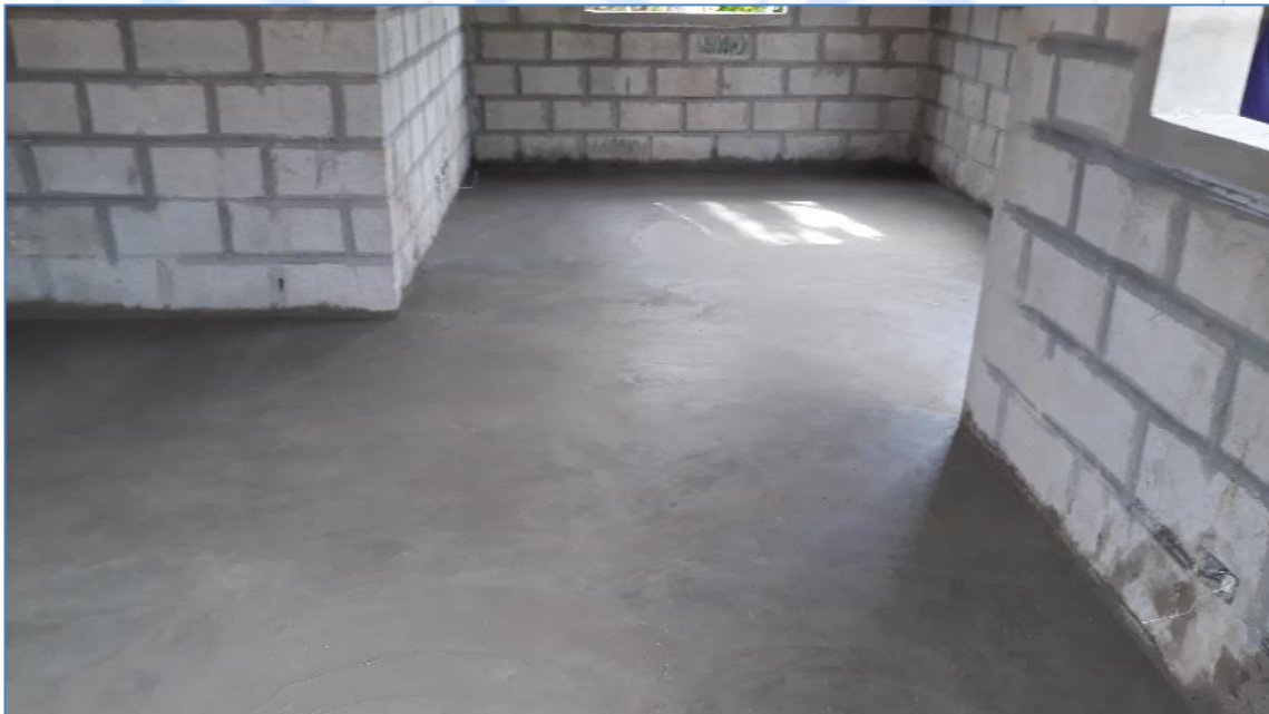
Vaciado de pisos de hormigón, casa del Sr. José Cabral, Viviendas Económicas.
