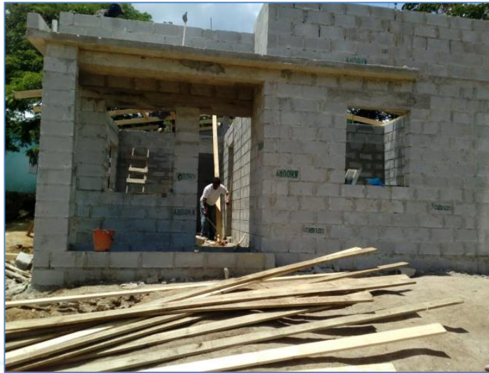
Colocación de bloques en antepecho, casa del sr. Andrés del Carmen, Viviendas Económicas.
