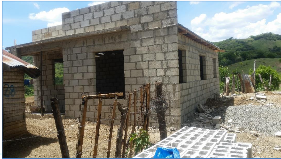
Colocación de bloques en antepecho, casa del Sra. Amantina Rosario, Viviendas Económicas.
