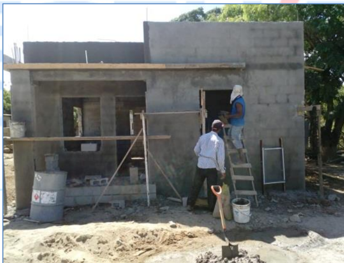
Pañete en fachada, casa del sr. Eduardo de la cruz Beltré, Viviendas Económicas.
