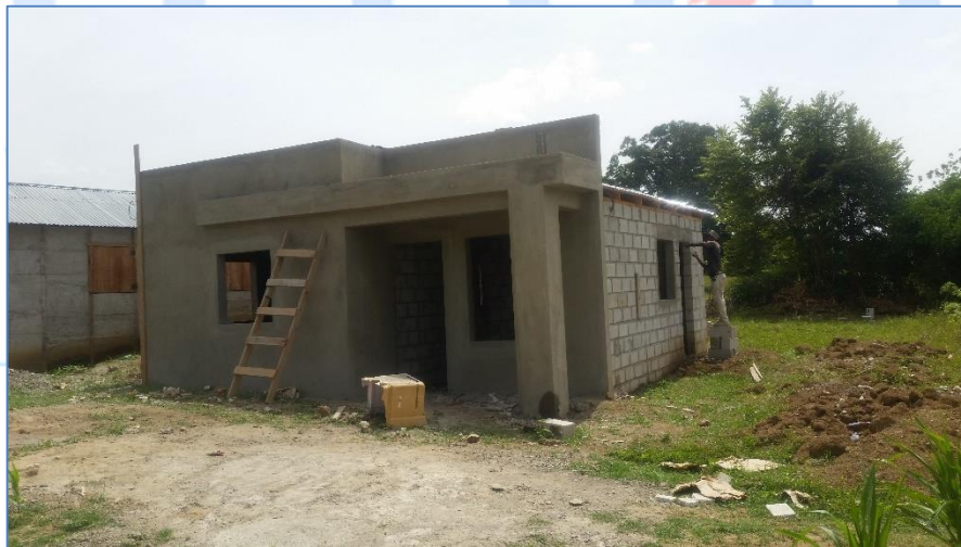
Colocación de pañete en fachada, casa del Sr. Pichardo Mateo, Viviendas Económicas.
