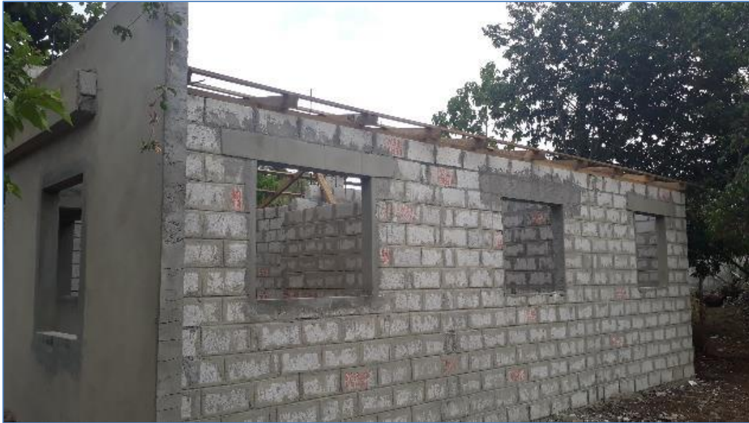
Colocación de estructura de madera en techo, casa de la Sra. Catalina Arnaut, Viviendas Económicas.
