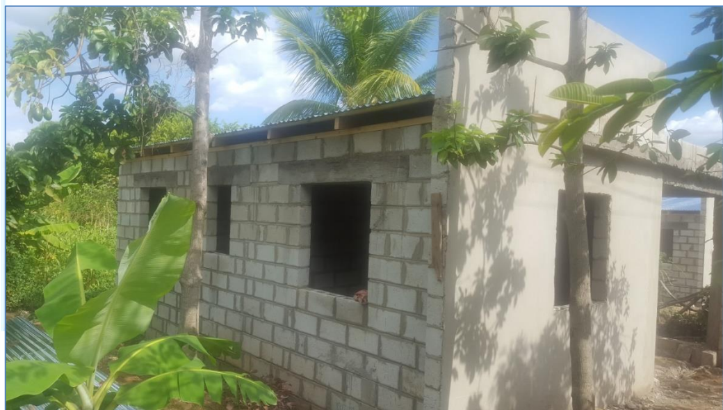
Colocación de zinc en techo, casa del Sra. Marcia Mateo, Viviendas Económicas.
