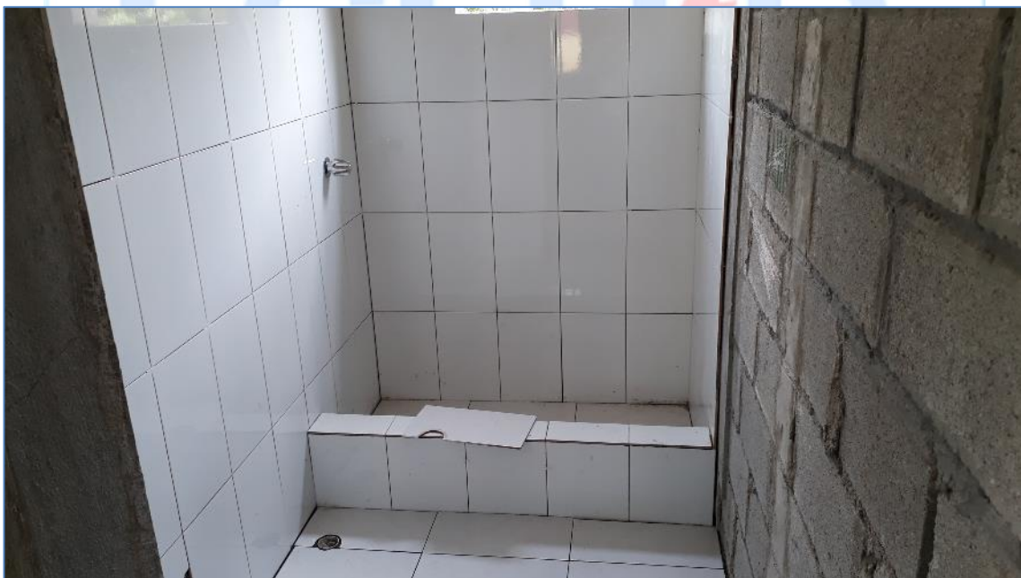
Revestimientos en baño, casa del Sr. Pascual del Carmen, Viviendas Económicas.
