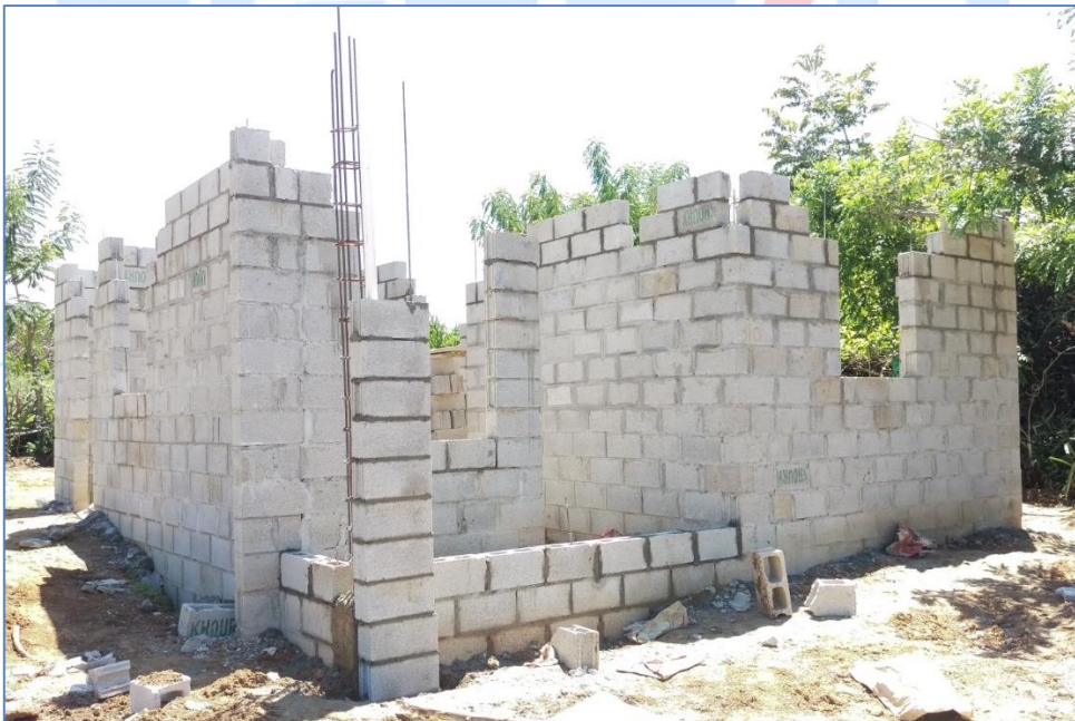
Colocación de bloques a nivel de dintel, casa del Sr. Arcenio Ramírez, Viviendas Económicas.
