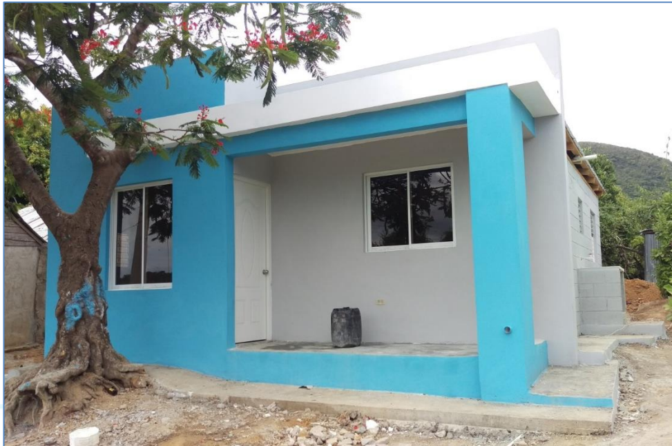
Colocación de puertas y ventanas, casa del Sr. Heriberto Jiménez, Viviendas Económicas.
