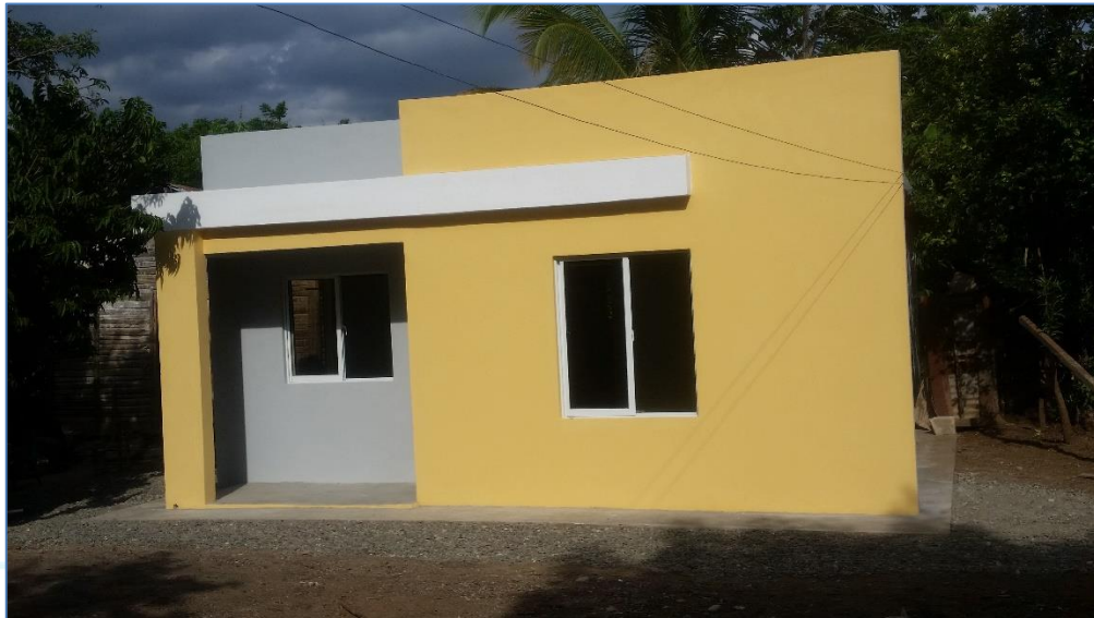
Pintura Exterior, casa del Sra. Clara Ramírez, Viviendas Económicas.
