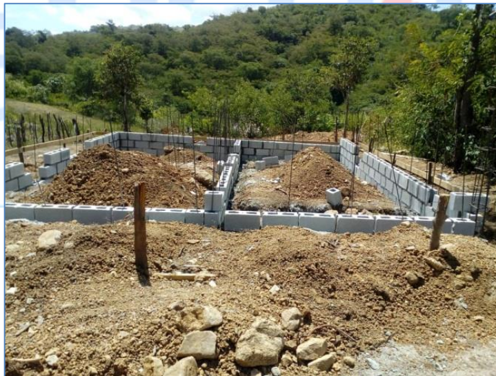
Colocación de bloques bajo nivel de piso, casa de la Sra. Petronila Ramírez, Viviendas Económicas.
