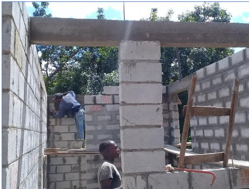
Vaciado de dinteles, casa del Sr. Manuel Ramírez, Viviendas Económicas.
