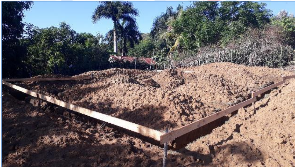
Construcción de charrancho para el replanteo, casa del Sr. Paulino Cabral, Viviendas Económicas.
