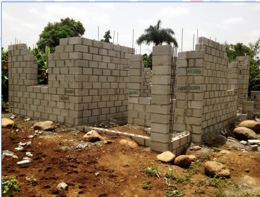
Colocación de bloques hasta nivel de dintel, casa de la Sra. Cruz Suero, Viviendas Económicas.
