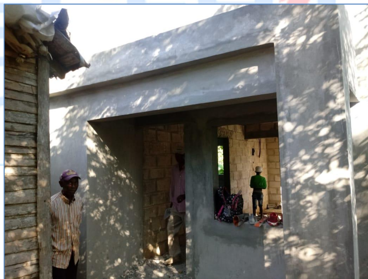
Terminación de mochetas, casa del sr. Fausto Encarnación, Viviendas Económicas.
