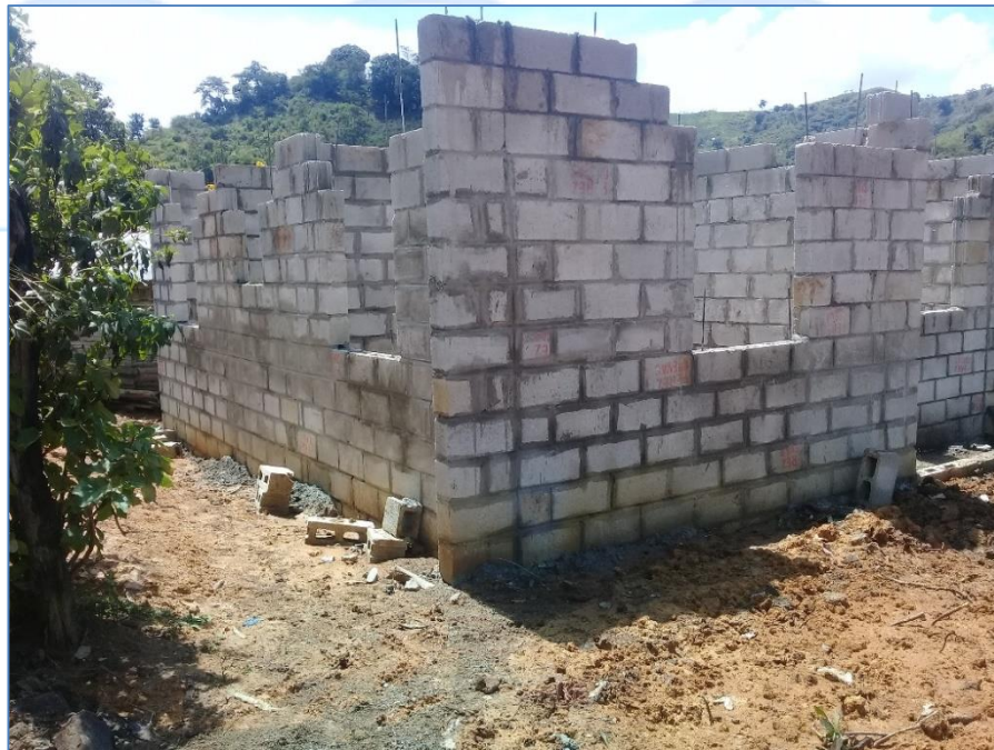
Bloques a nivel de dintel, casa del Sr. Percido Ramírez, Viviendas Económicas.
