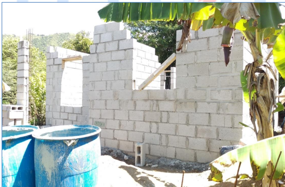
Encofrado de dinteles, casa del Sr. Eridanio Ramírez, Viviendas Económicas.
