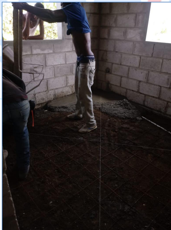
Colocación de malla electrosoldada en pisos, casa del Sr. Narciso Suero de los santos, Viviendas Económicas.
