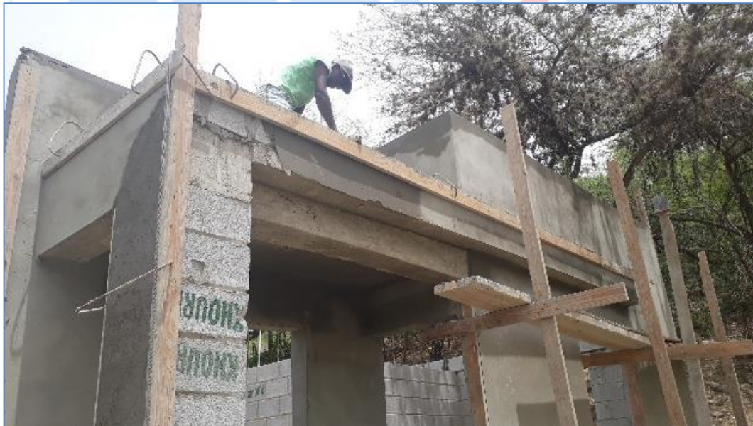
Colocación de pañete, casa del Sr. Elis Arno, Viviendas Económicas.
