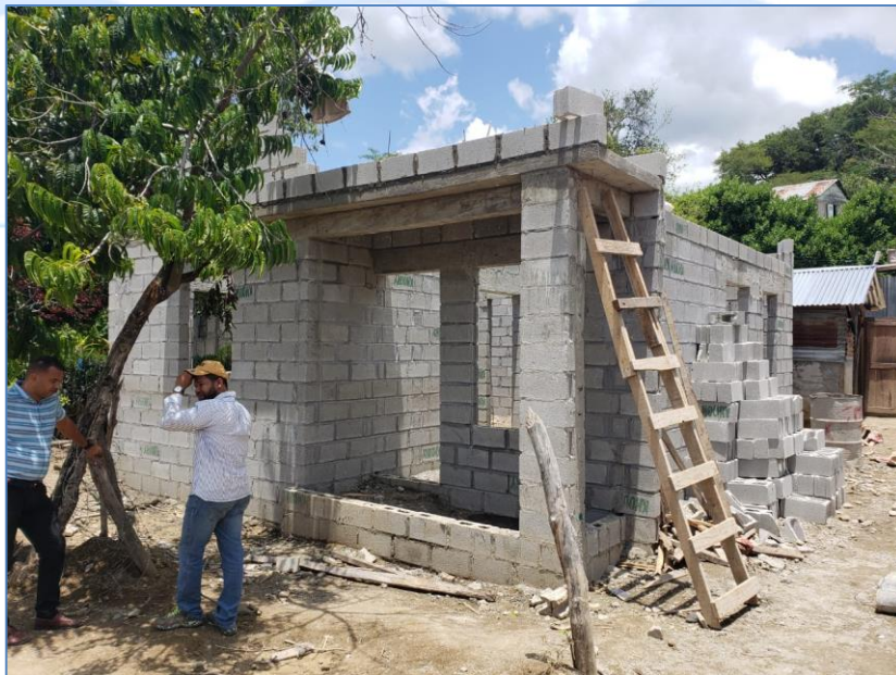
Vaciado de losa, casa de la Sra. Modestina Ramírez, Viviendas Económicas.
