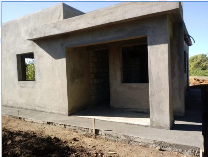
Terminación de acera perimetral, casa del sr. Miguel Arno, Viviendas Económicas.
