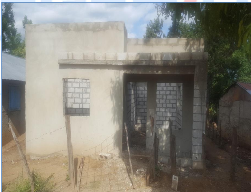
Colocación de pañete frontal, casa de la Sra. Anita Solís, Viviendas Económicas.
