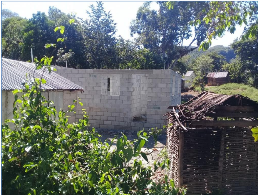
Vaciado de dinteles, casa del Sr. Gerineldo Arno, Viviendas Económicas.
