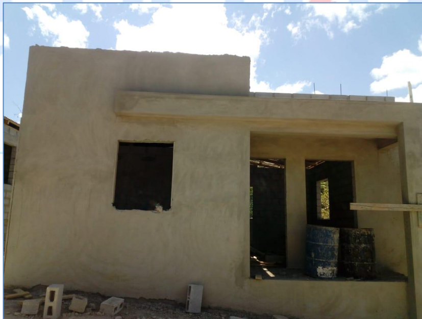
Pañete de fachada, casa del Sr. Milciades Ramírez, Viviendas Económicas.
