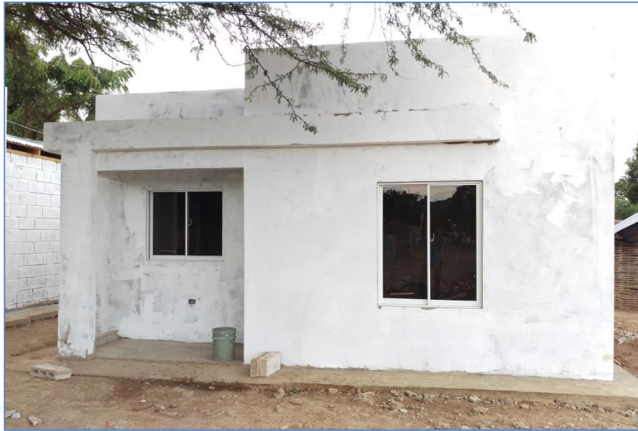
Aplicación de pintura en exterior, casa del Sra. Martina Hernández, Viviendas Económicas.
