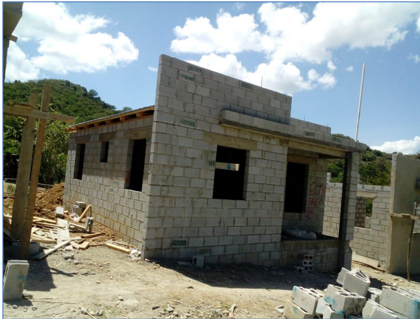
Bloques en antepecho, casa de la Sra. Carmela Ramírez, Viviendas Económicas.
