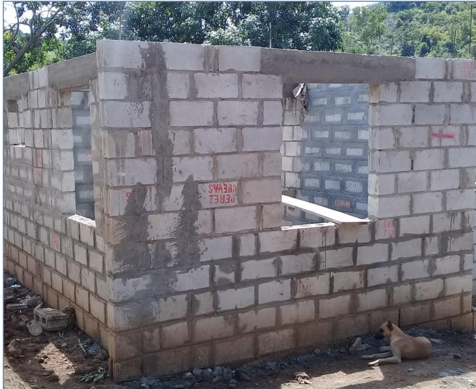
Vaciado de dinteles, casa del Sr. Freddy Ramírez, Viviendas Económicas.
