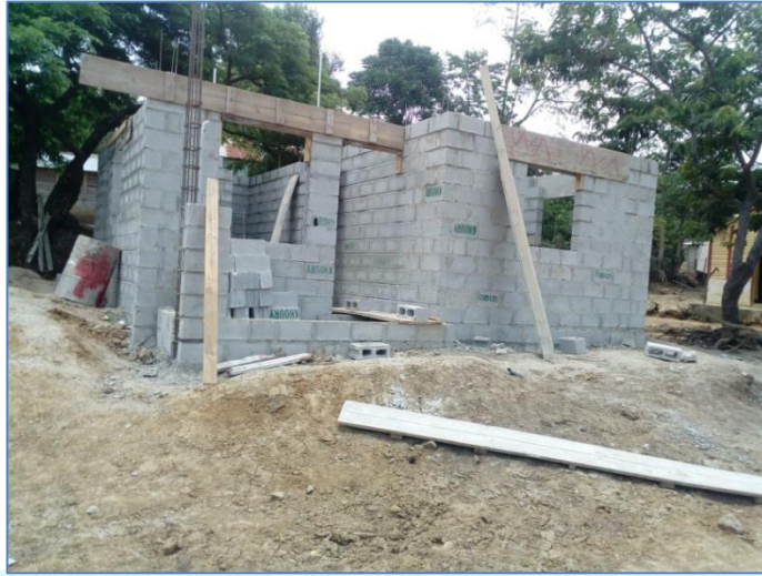
Colocación de bloques a nivel de dintel, casa del sr. Víctor Beltré, Viviendas Económicas.
