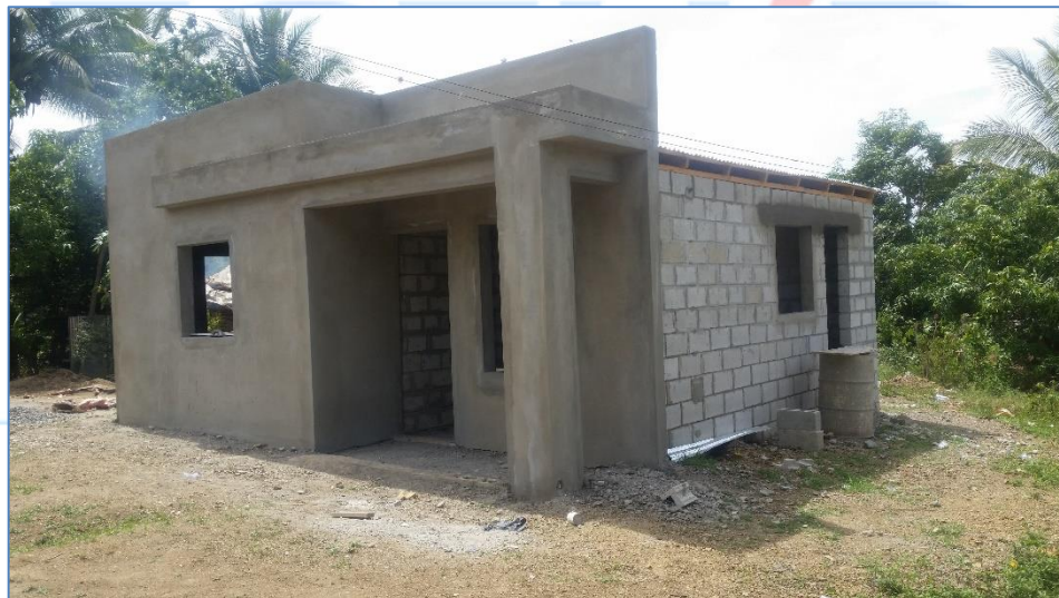
Colocación de pañete en fachada, casa del Sr. Ramón Arno, Viviendas Económicas.
