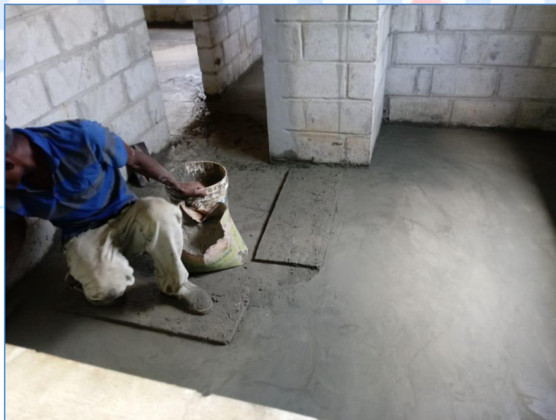
Terminación de piso de hormigón, casa del Sra. Guillermina de los Santos, Viviendas Económicas.
