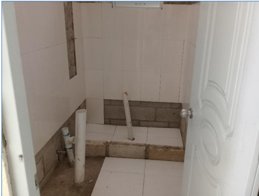
Revestimientos en cerámica de baño, casa del Sr. Anulfo Valdez, Viviendas Económicas.
