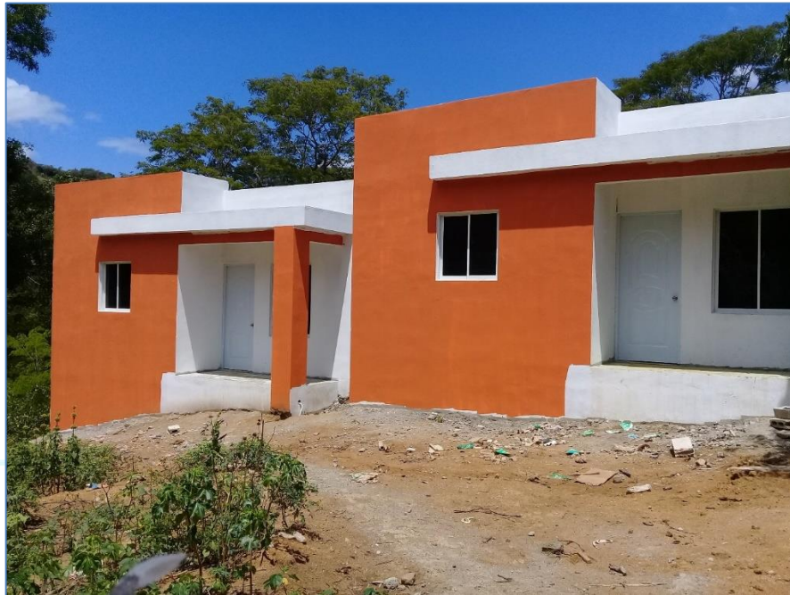
Aplicación de pintura, casa del Sr. Rafael Ramírez, Viviendas Económicas.
