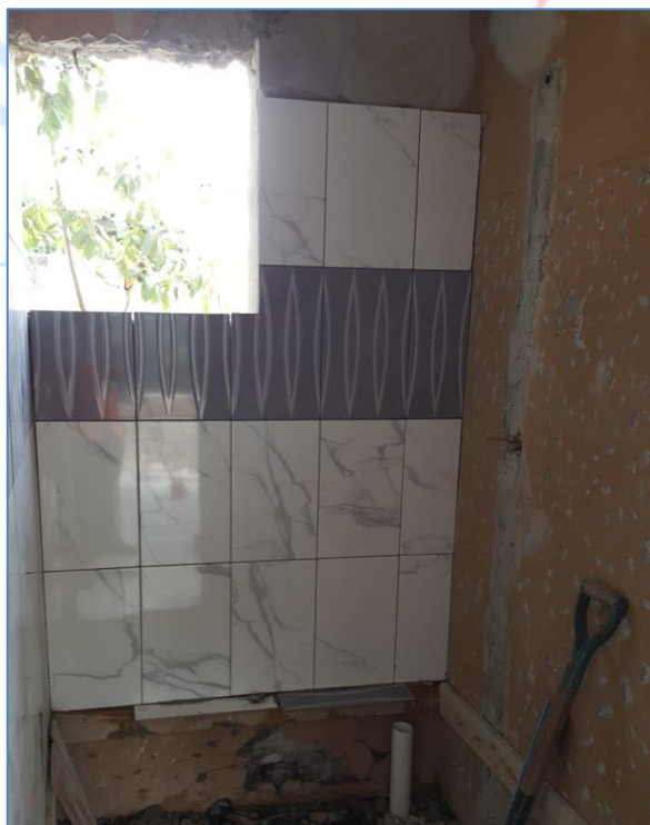
Colocación de cerámica en baños, Vocacional FF.AA., Vallejuelo.
