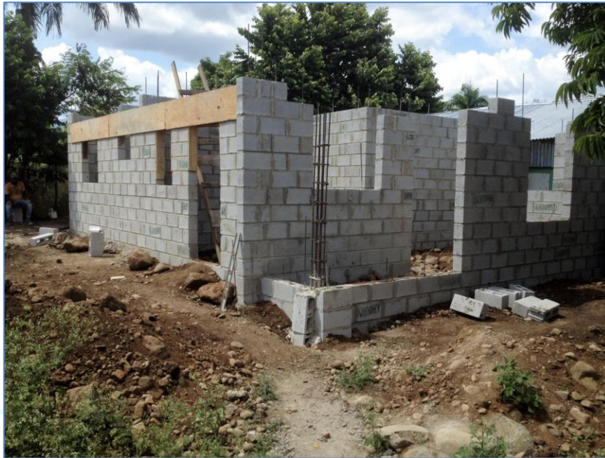
Encofrado y armado de dintel, casa de la Sra. Lorenza Langomás, Viviendas Económicas.
