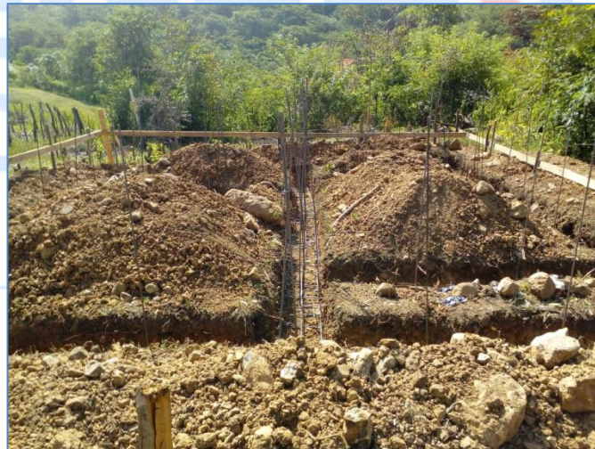
Excavación de zapatas, casa del sr. Emerio del Carmen, Viviendas Económicas.
