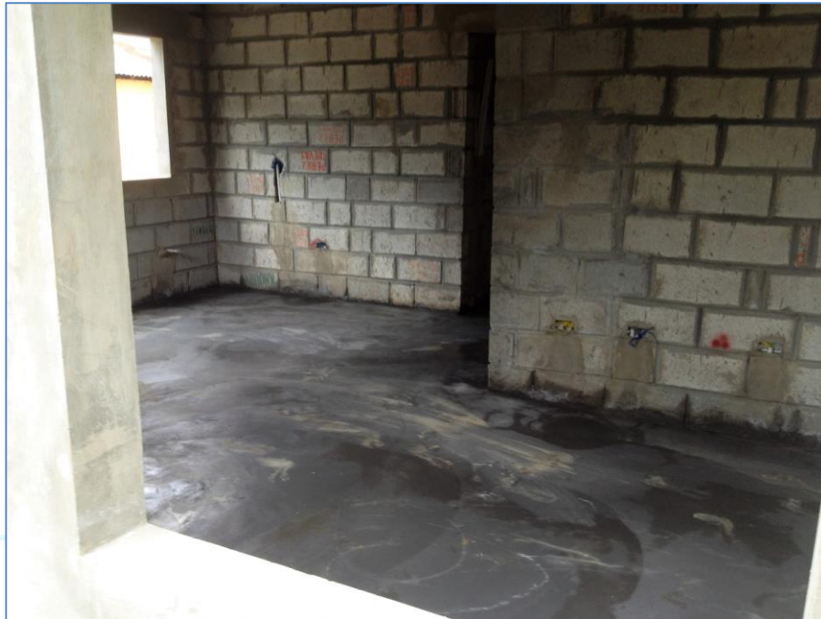
Vaciado de pulido de pisos, casa de la Sra. Ana Rita Ramón, Viviendas Económicas.
