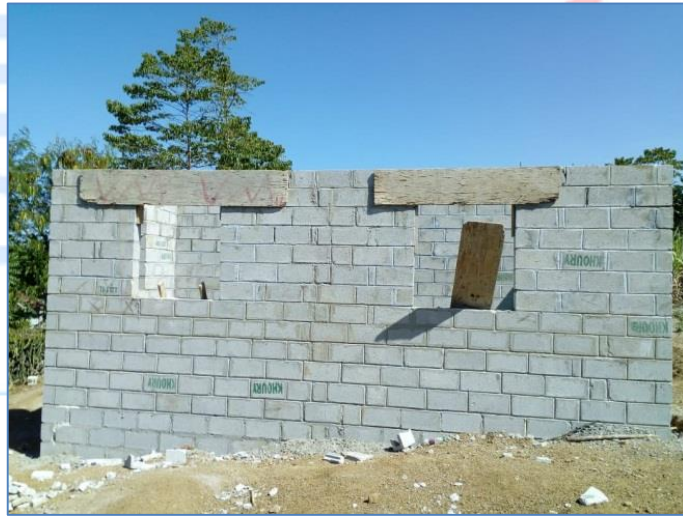
Encofrado de dinteles, casa de la sra. Julissa Suero, Viviendas Económicas.
