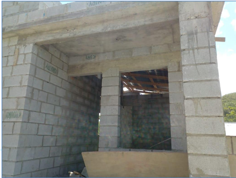
Vaciado de losa, casa de la Sra. Susana Ramírez, Viviendas Económicas.
