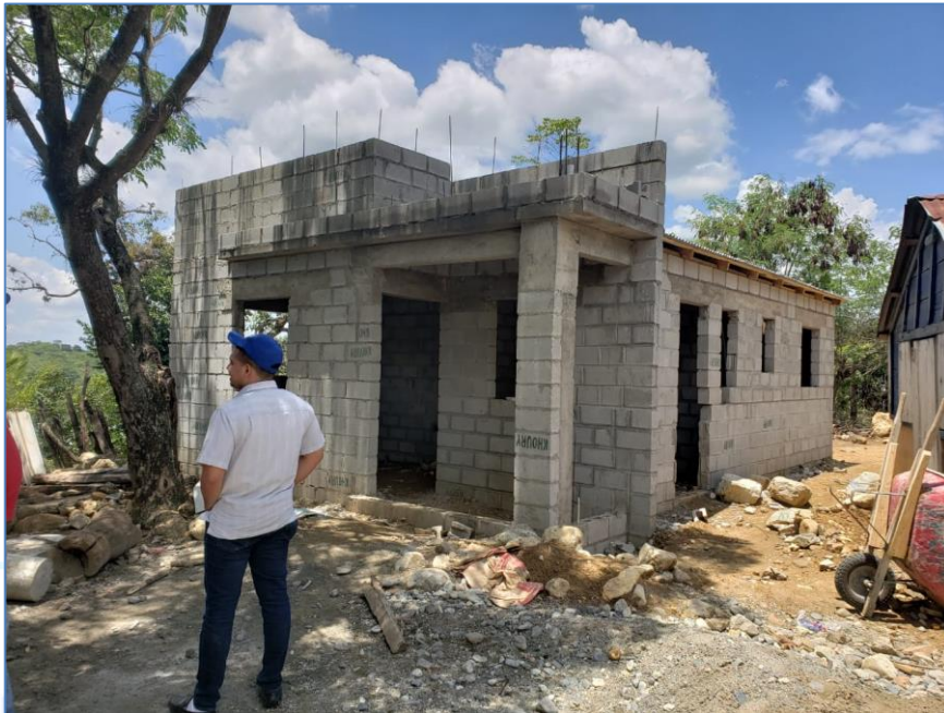
Techo de zinc colocado, casa del Sra. Vírgenes Suero, Viviendas Económicas.
