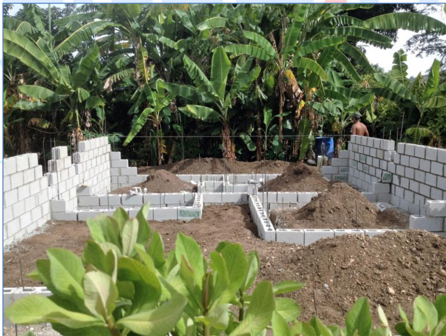
Colocación de bloques sobre nivel de piso, casa de la Sra. Aquilina del Carmen, Viviendas Económicas.
