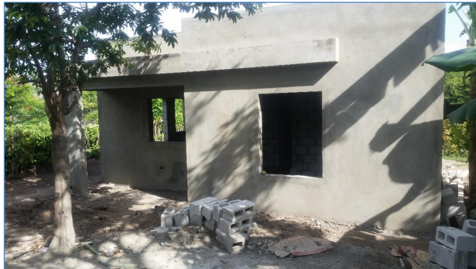
Colocación de pañete en fachada, casa del Sr. Fernando Arno, Viviendas Económicas.
