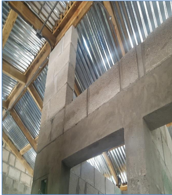
Instalaciones eléctricas, casa del Sra. Heroína Ramírez, Viviendas Económicas.
