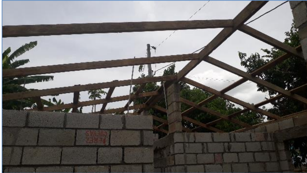
Colocación de bloques en antepecho, casa del Sr. Paulino Cabral, Viviendas Económicas.
