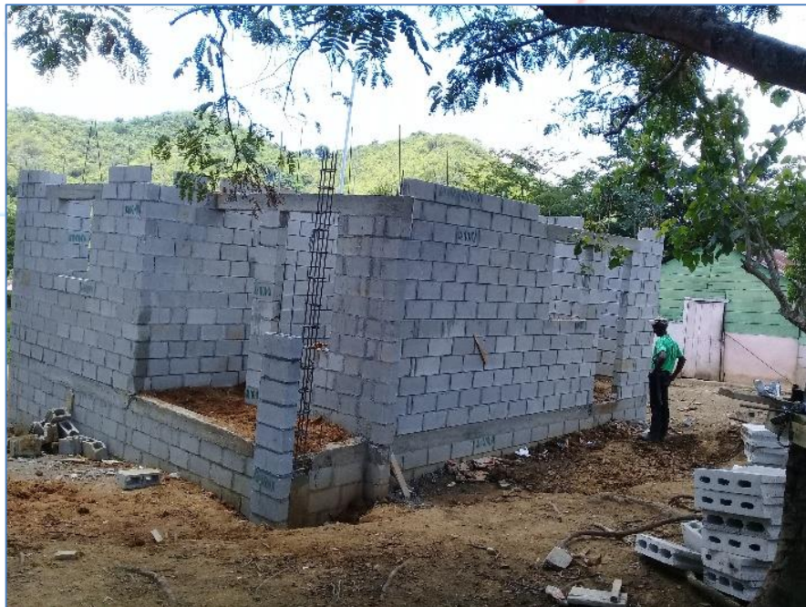
Vaciado de dinteles, casa del Sr. Ramiro Reyes, Viviendas Económicas.
