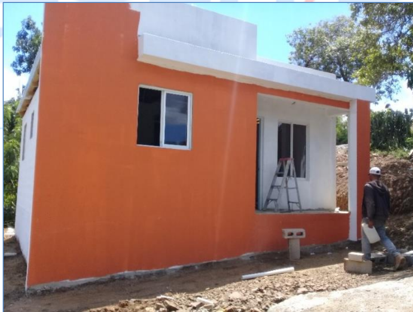
Aplicación de pintura, casa de la Sra. Luz María de la Cruz, Viviendas Económicas.
