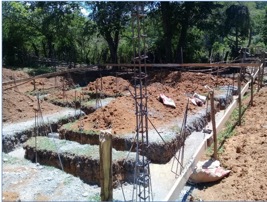
Vaciado de zapatas, casa del Sr. Chijo Jiménez, Viviendas Económicas.
