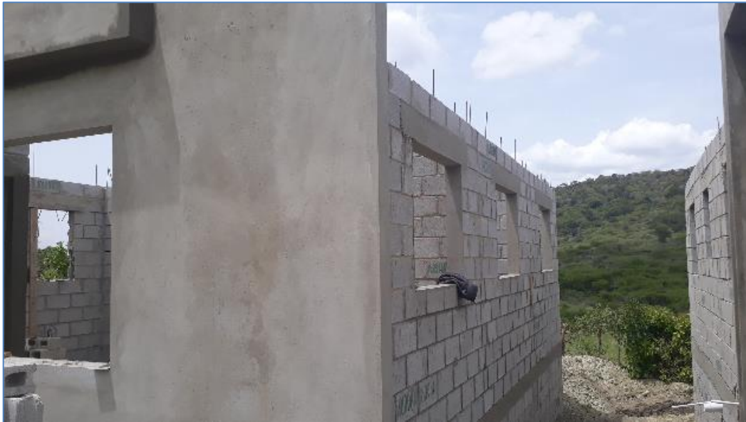
Colocación de pañete, casa del Sr. Limardo Suero, Viviendas Económicas.
