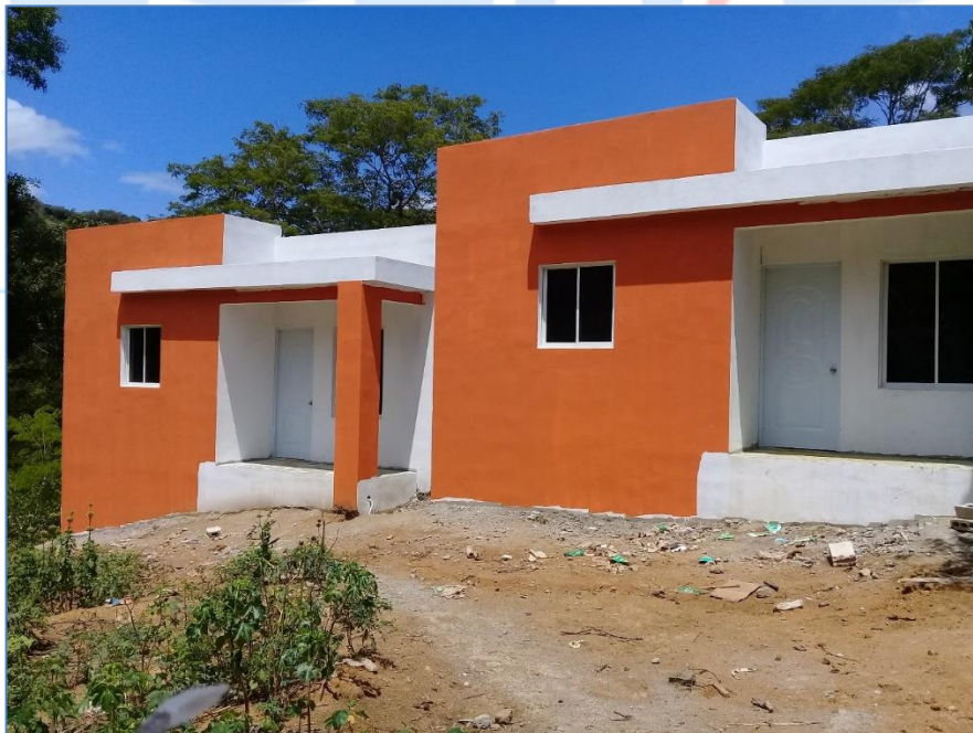
Aplicación de pintura, casa de la Sra. Modestina Ramírez, Viviendas Económicas.
