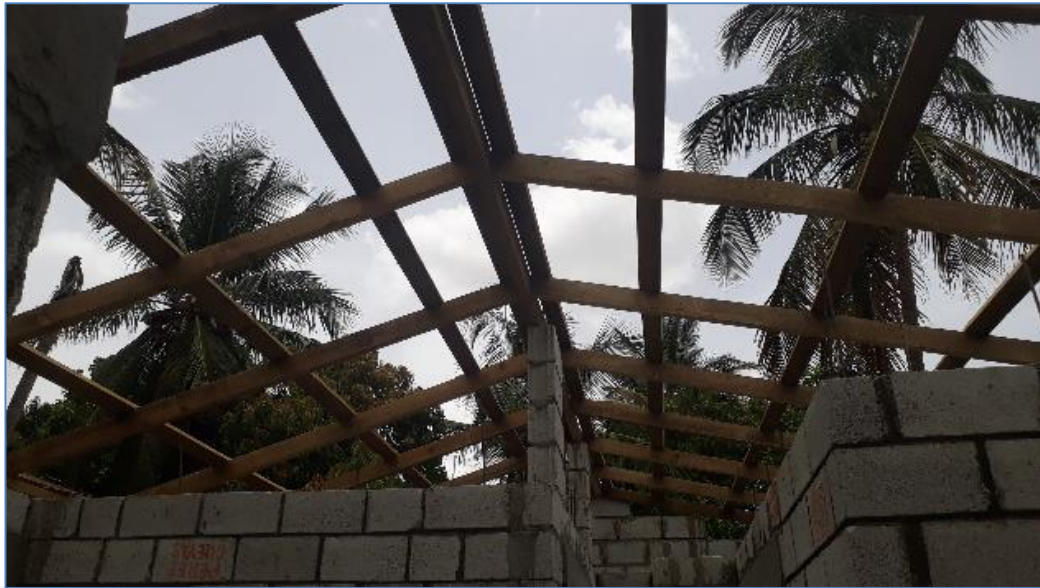
Colocación de estructura de madera para techo, casa del Sr. Juan Ramírez, Viviendas Económicas.
