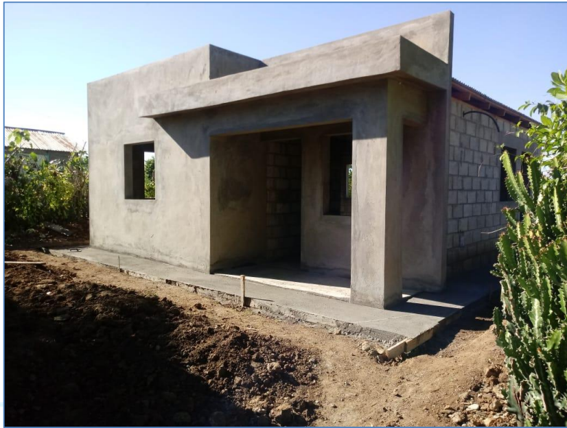
Terminación de acera perimetral, casa del sr. Adilanio Jiménez, Viviendas Económicas.
