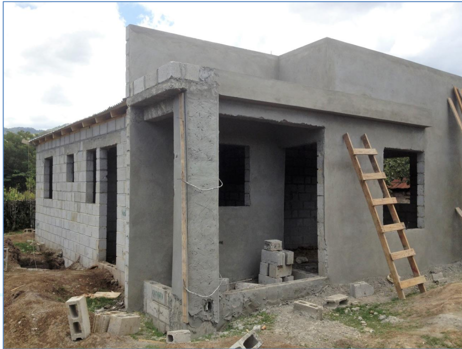
Colocación de zinc en techo, casa de la Sra. Daysi Suero, Viviendas Económicas.
