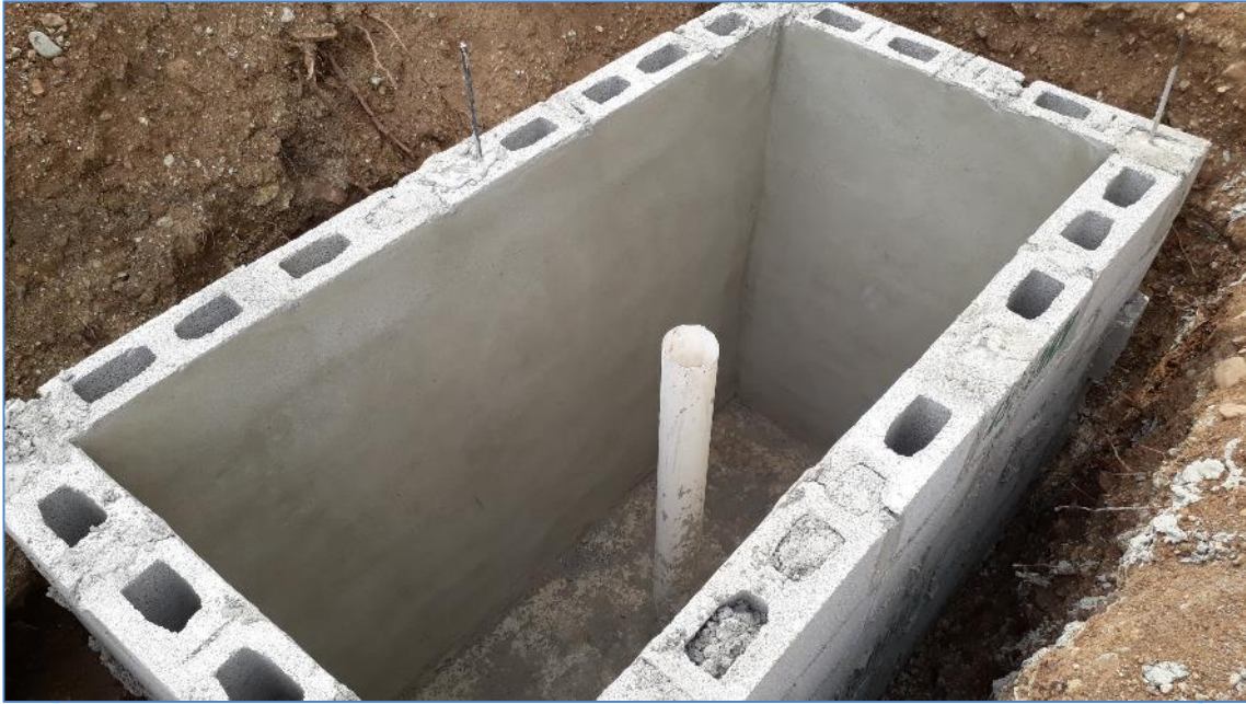
Colocación de pañete, casa de la Sra. Mercedes del Carmen, Viviendas Económicas.
