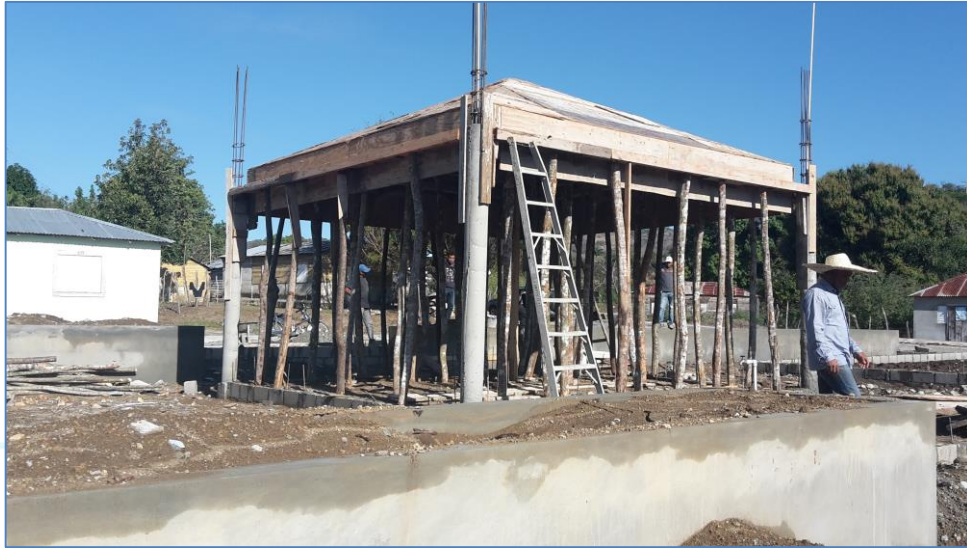
Construcción de la glorieta, Parque Los Cocos.
