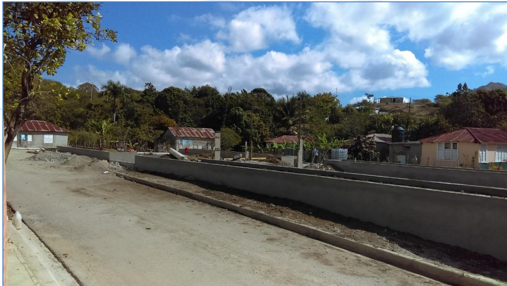
Muro de bloques de las jardineras, Parque Los Cocos.
