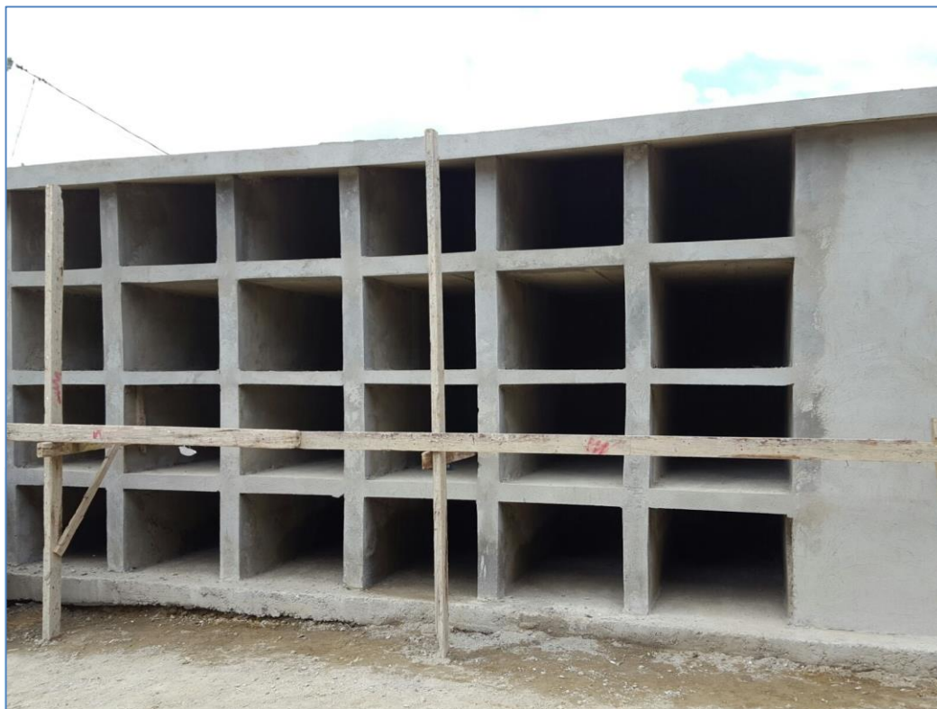
Losas de techo de nichos vaciadas, Cementerio de Baitoa.
