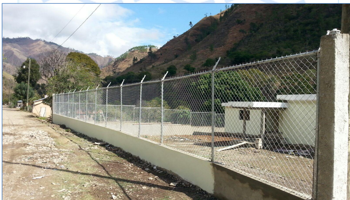
Verja perimetral, Policlínica Ingenito.
