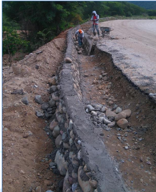
Construcción de canaleta, Relleno Sanitario Bohechio.
