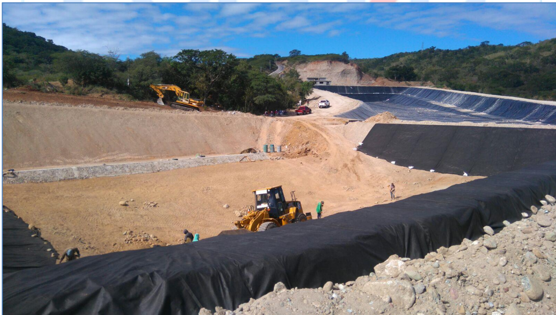
Colocación de Geotextil y Geomembrana, Relleno Sanitario Bohechío.
