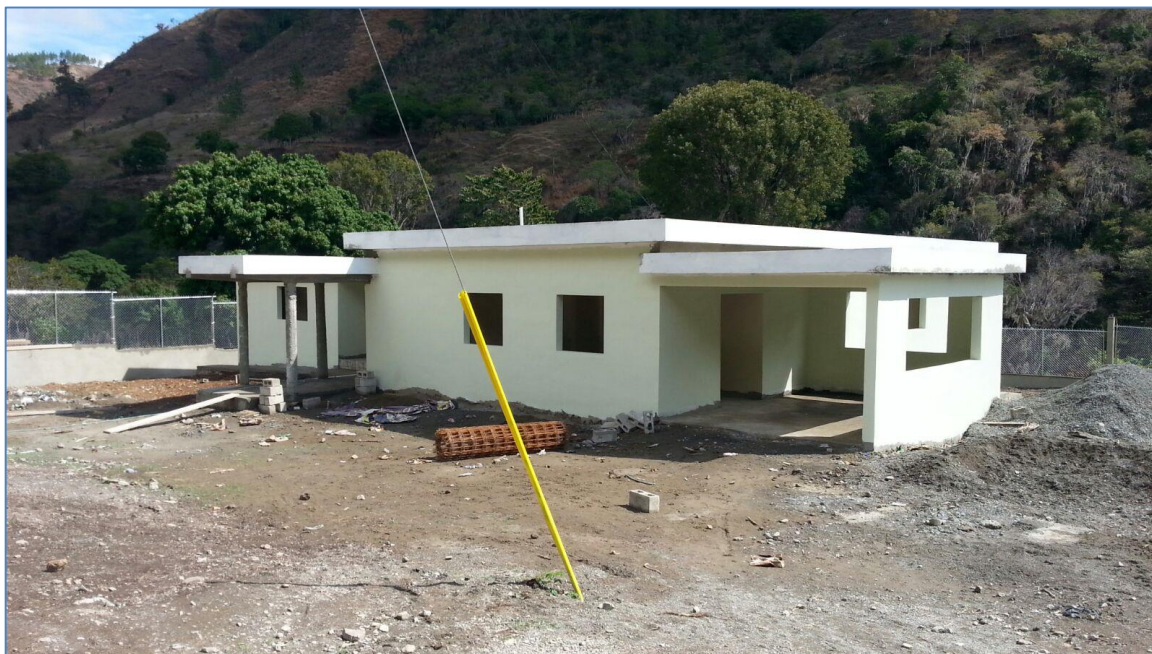
Pintura exterior, Policlínica Ingenito.
