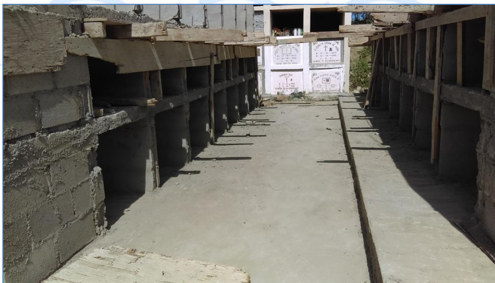
Construcción aceras, Cementerio Baitoa.
