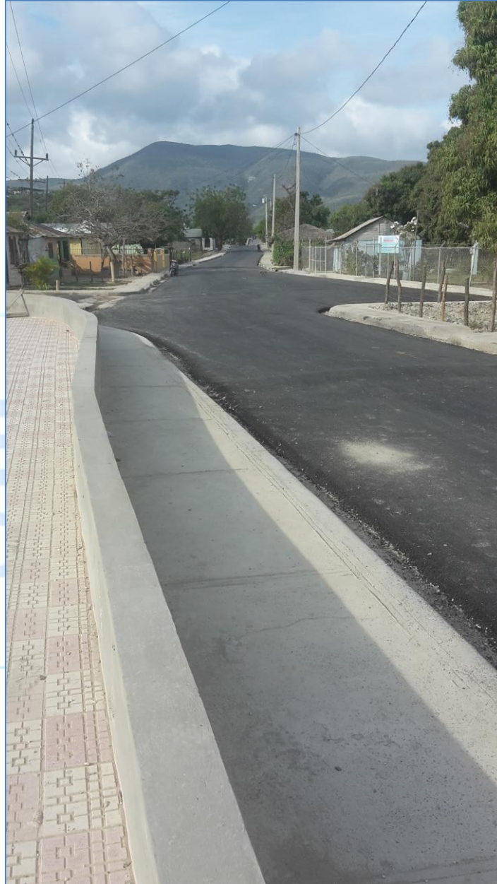
Asfalto colocado, Parque Los Bancos.
