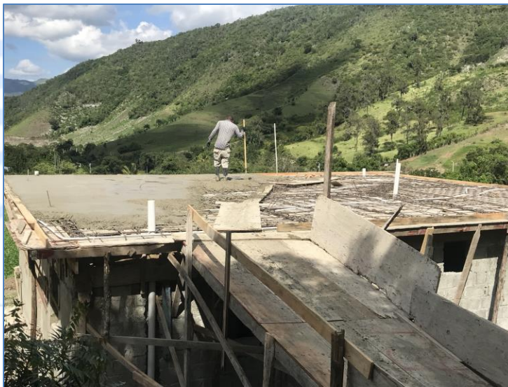
Vaciado de hormigón losa de techo, Centro de Atención Primaria, Vallejuelo
