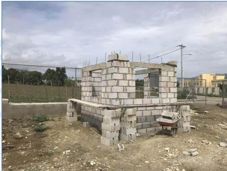
Colocación de bloques hasta nivel de dintel, Cafetería, Vocacional FF.AA., Vallejuelo.
