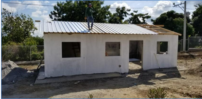
Colocación de zinc acanalado en techo, Taller de Ebanistería, Vocacional FF.AA., Vallejuelo.
