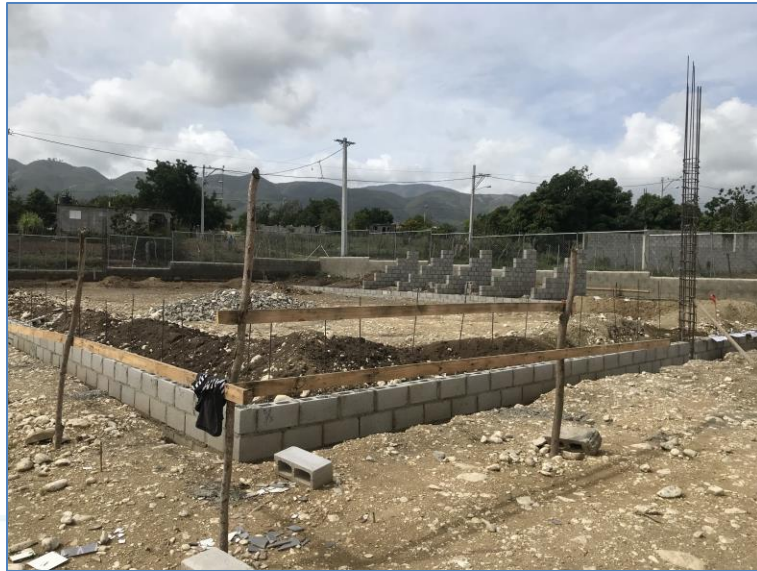
Colocación de bloques, Cancha, Vocacional FF.AA., Vallejuelo.
