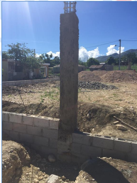
Vaciado de columnas, Cancha, Vocacional FF.AA., Vallejuelo.
