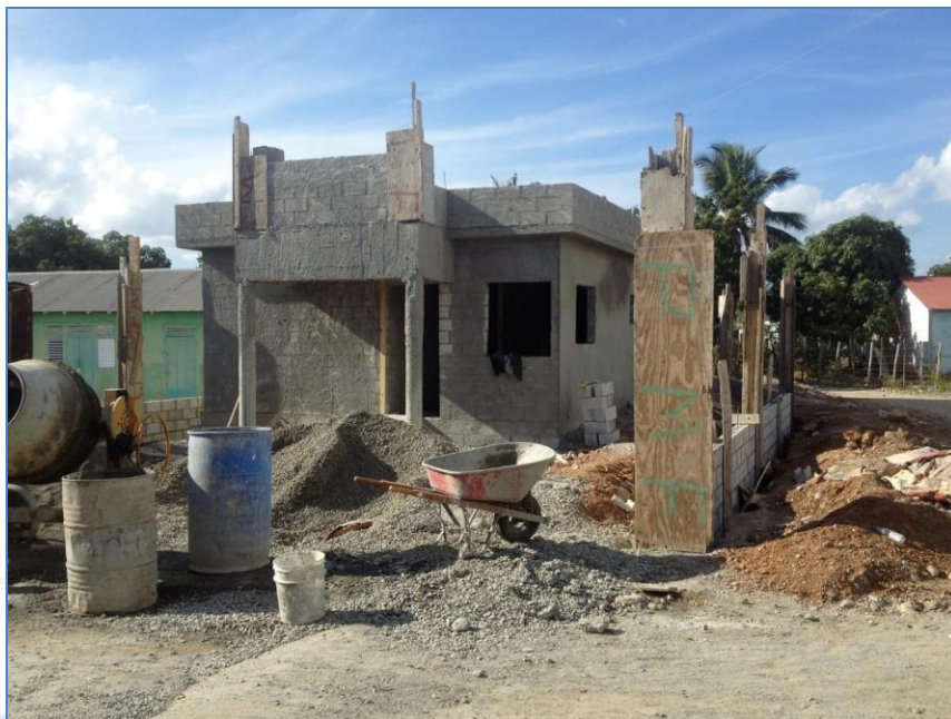
Colocación de fraguache en fachada, vigas y losas, Cuartel Policial Las Zanjas.
