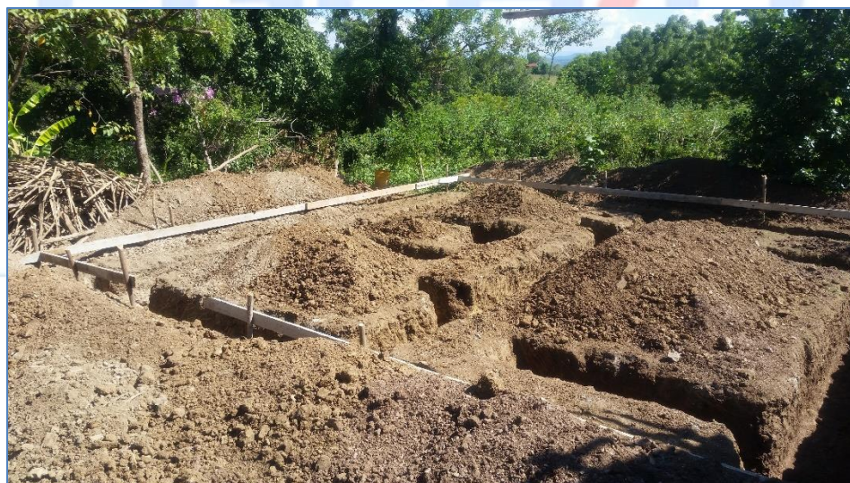
Excavación de zapatas, casa de la Sra Evangelista Ramírez, Viviendas.
