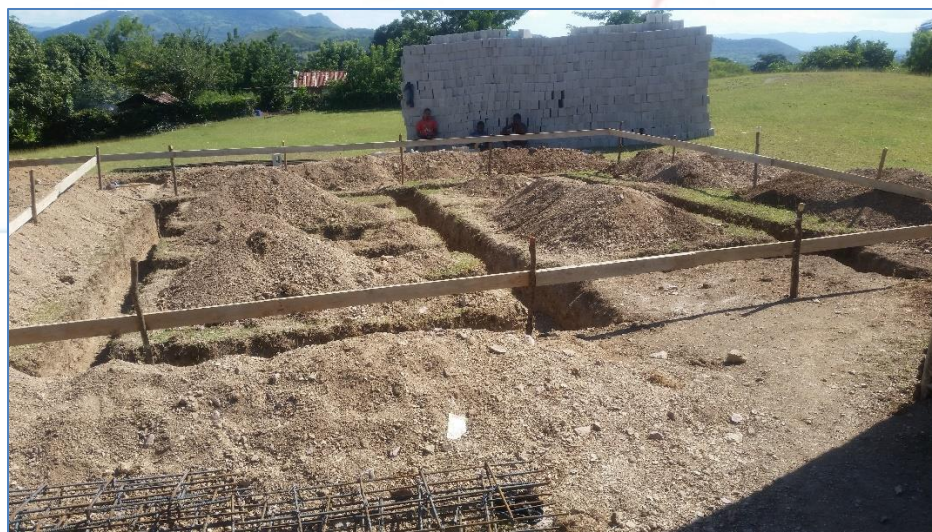
Excavación de zapatas, casa de la Sra. Enercida Suero, Viviendas.
