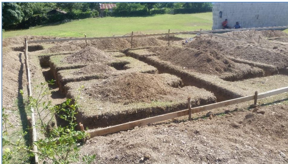
Excavación de zapatas, casa del Sr. Juvenal Ramírez, Viviendas.
