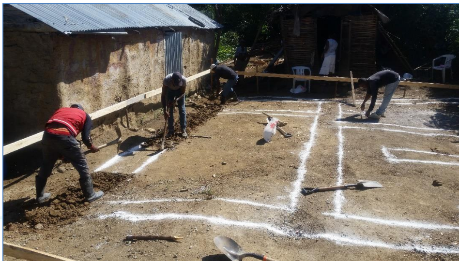
Excavación de zapatas, casa de la Sra. Celenia Suero, Viviendas.
