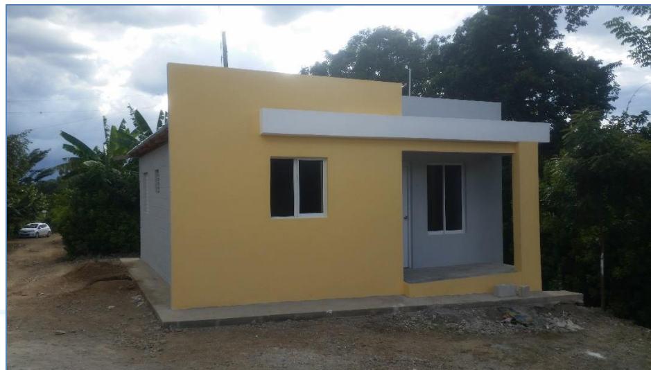
Pintura exterior lista, casa del Sr. Aristeo Jiménez, Viviendas Económicas.
