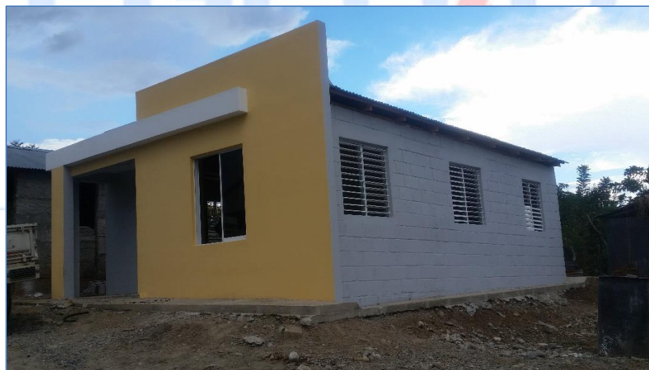
Pintura exterior lista, casa de la Sra. Oliva Valdez, Viviendas.
