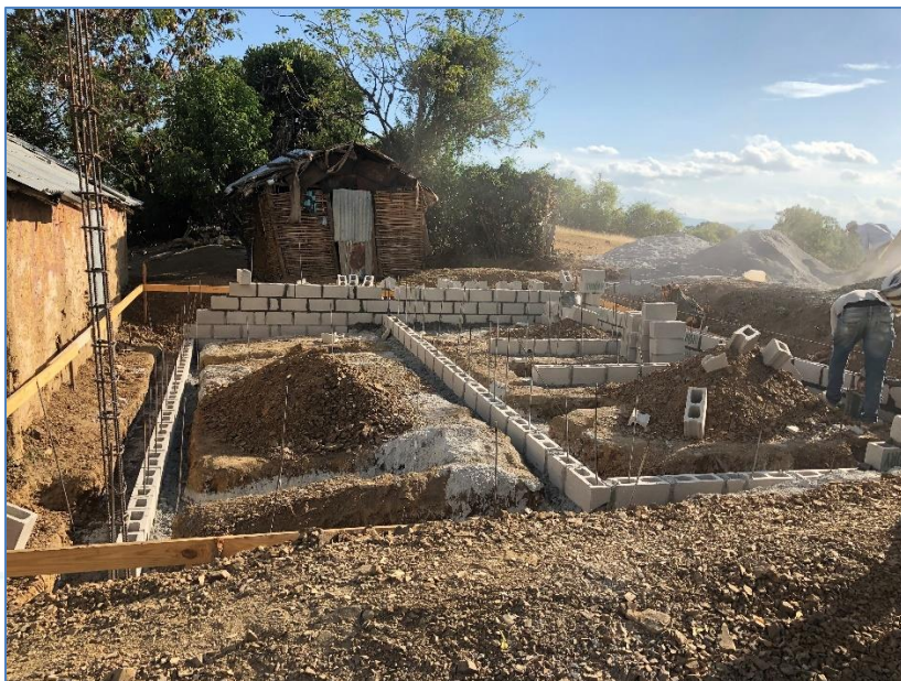
Colocación de bloques bajo nivel de piso, casa de la Sra. Celenia Suero, Viviendas.
