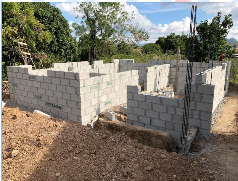
Colocación de bloques hasta nivel de ventanas, casa de la Sra Evangelista Ramírez, Viviendas.
