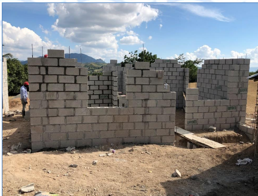
Colocación de bloques a nivel de dintel, casa de la Sra. Enercida Suero, Viviendas.
