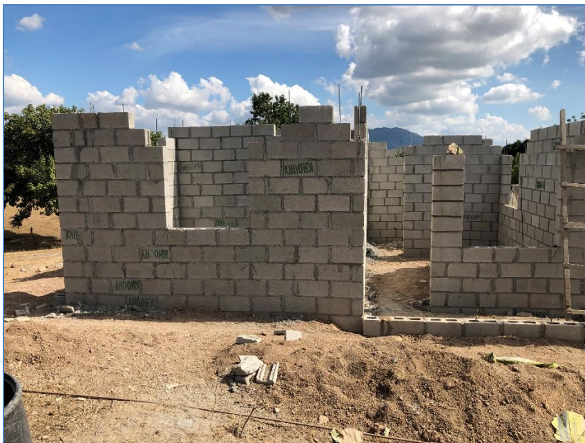
Colocación de bloques a nivel de dintel, casa del Sr. Juvenal Ramírez, Viviendas.
