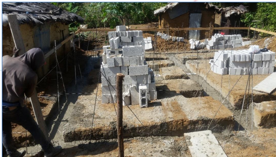
Vaciado de de zapatas, casa de la Sra. María del Pilar Arno, Viviendas Económicas.
