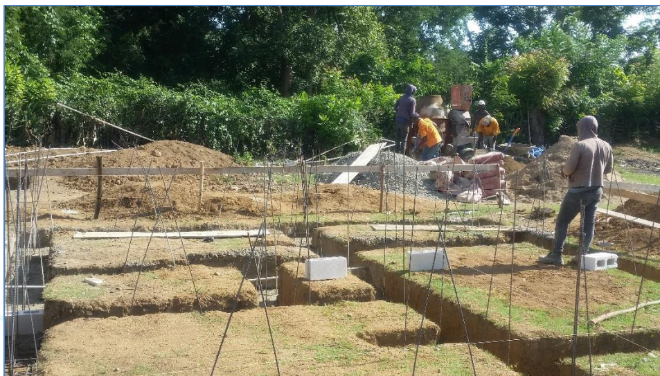
Excavación de zapatas, casa de la Sra. Mirtha de los Santos, Viviendas Económicas.
