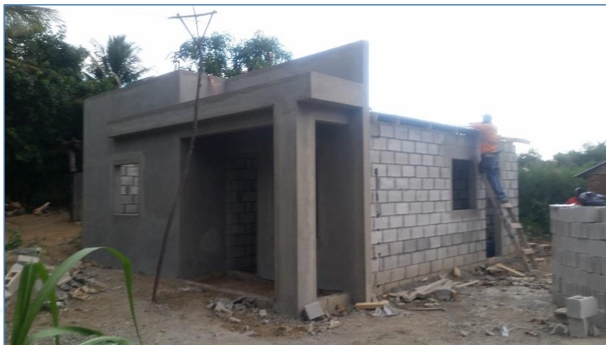
Colocación de zinc acanalado en techo, casa del Sr. Relle Arno Ramírez, Viviendas Económicas.
