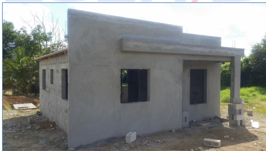
Zinc acanalado en techo colocado, casa del Sr. Guarionex Valdez, Viviendas Económicas.
