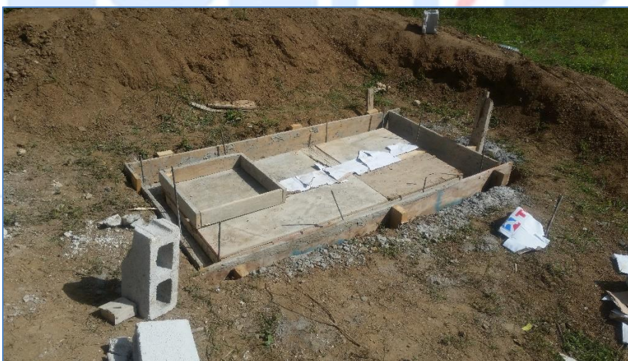
Vaciado de losa en fosa séptica, casa del Sra. Dileidy Mateo, Viviendas Económicas.
