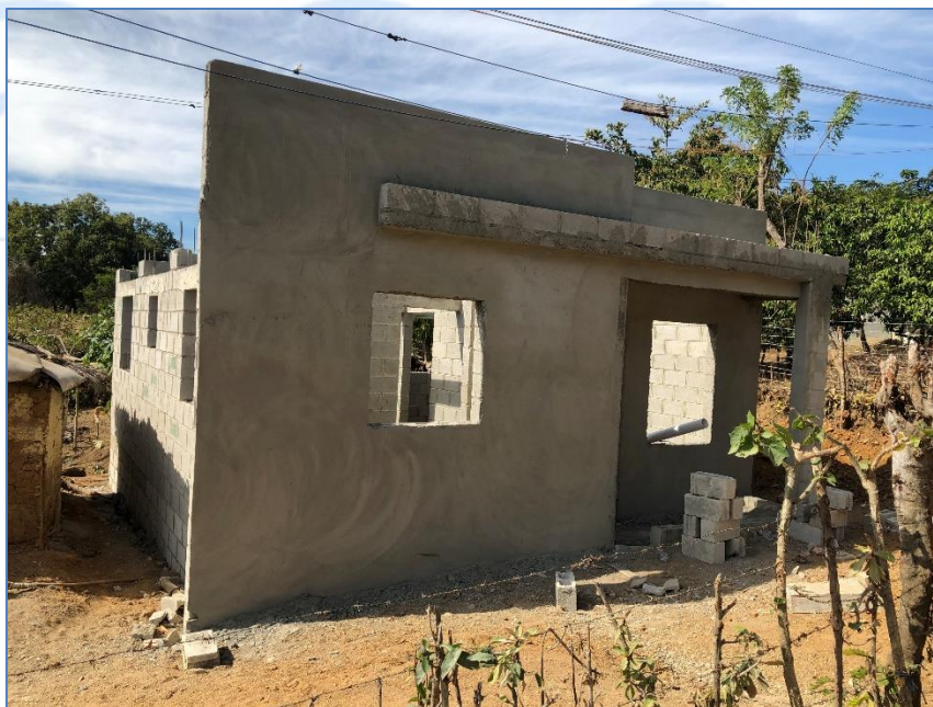
Pañete en fachada, casa de la Sra. María del Pilar Arno, Viviendas Económicas.
