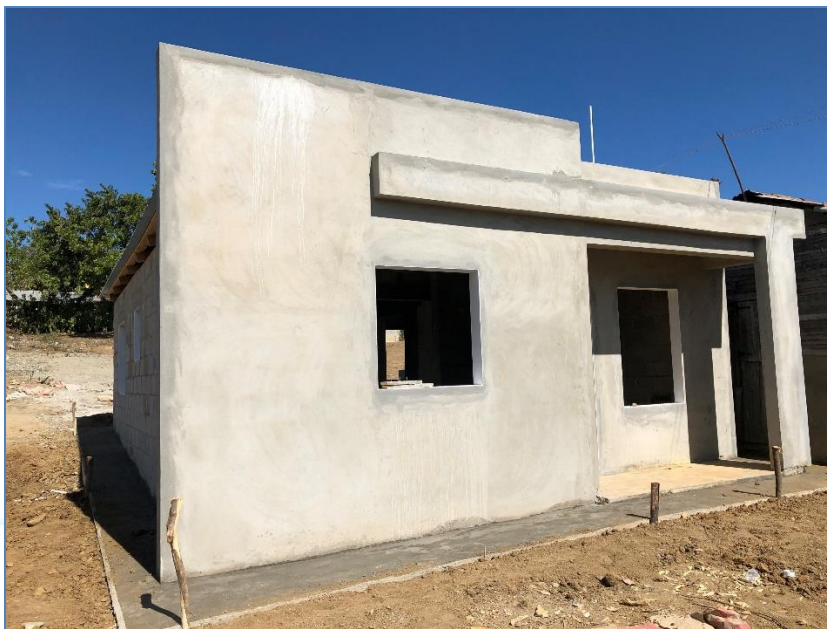
Construcción de acera perimetral, casa del Sr. Isidoro Solis, Viviendas Económicas.
