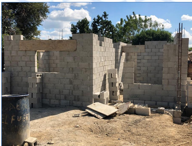
Vaciado de Dinteles, casa del Sr. Manuel Víctor Mateo, Viviendas Económicas.
