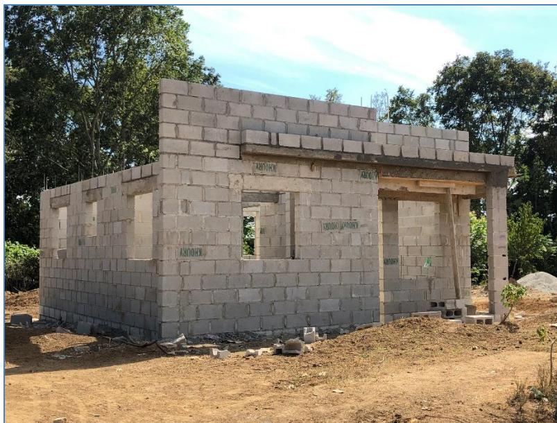
Colocación de bloques en antepecho, casa de la Sra. Mirtha de los Santos, Viviendas Económicas.
