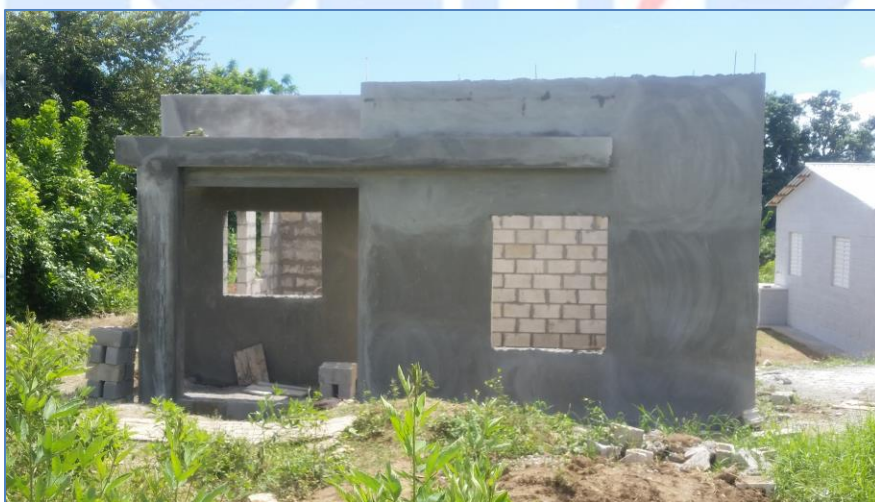
Pañete en fachada, casa del Sra. Dileidy Mateo, Viviendas Económicas.
