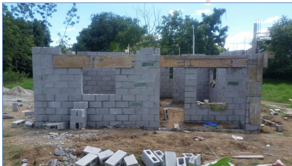
Encofrado de dinteles, casa del Sr. Guarionex Valdez, Viviendas Económicas.
