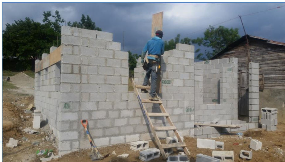
Encofrado de dinteles, casa del Sr. Isidoro Solis, Viviendas Económicas.
