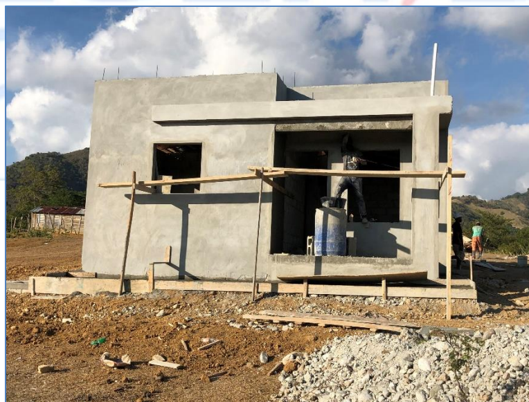
Pañete en fachada, casa del Sr. Orfelio María Arnó, Viviendas Económicas.
