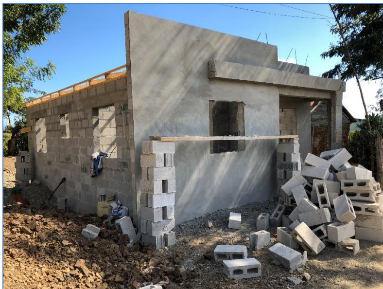
Pañete en fachada, casa del Sr. Miguel Ángel Arno, Viviendas Económicas.
