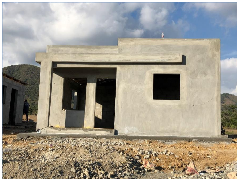
Pañete en fachada, casa de la Sra. Beysy Arnaud, Viviendas Económicas.
