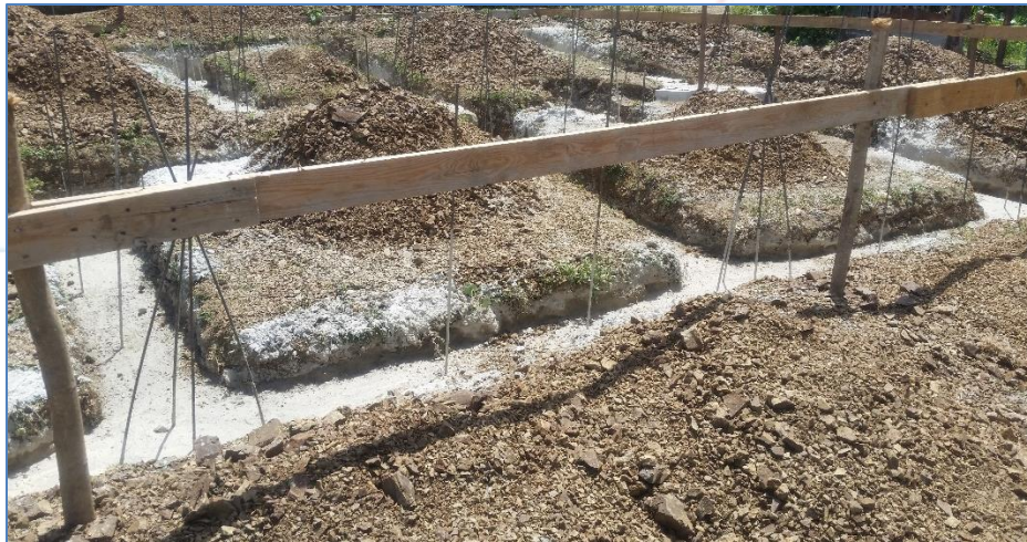
Vaciado de zapatas, casa del Sr. Pedro Aníbal Ramirez Soler, Viviendas Económicas.
