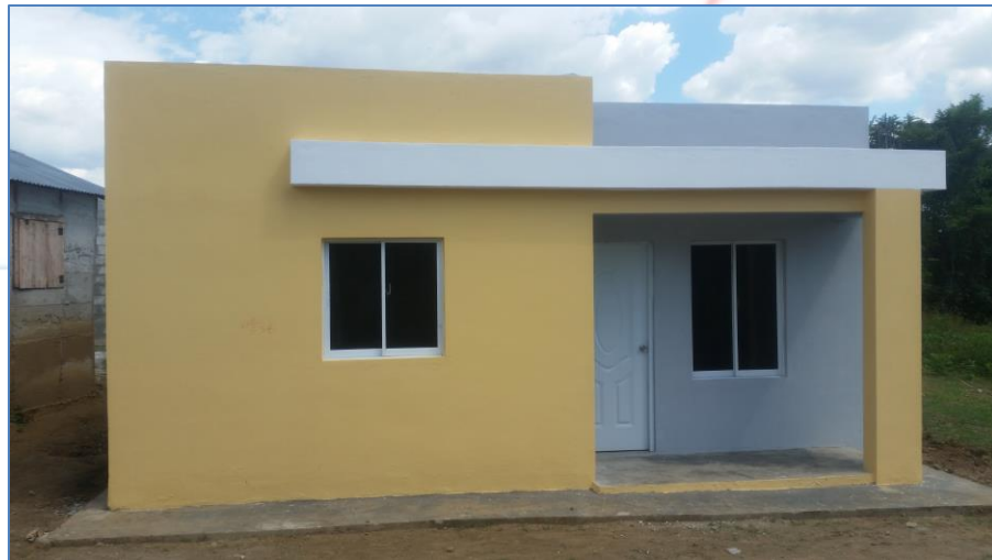
Vivienda terminada, casa del Sr. Pichardo Mateo, Viviendas Económicas.
