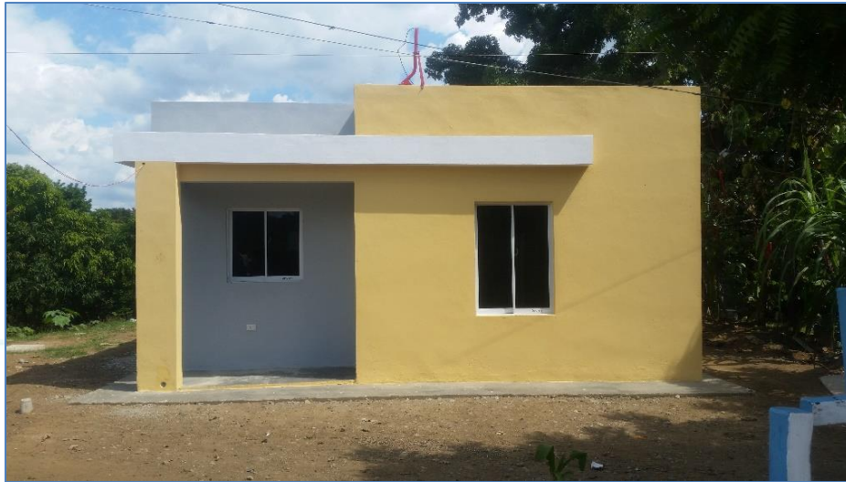
Vivienda terminada, casa del Sr. Pablo Mateo, Viviendas Económicas.
