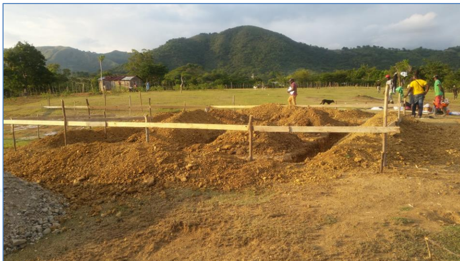
Excavación de zapatas, casa de la Sra. Beysy Arnaud, Viviendas Económicas.
