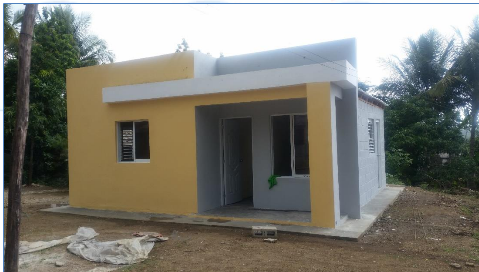
Vivienda terminada, casa del Sr. Ramón Arno, Viviendas Económicas.
