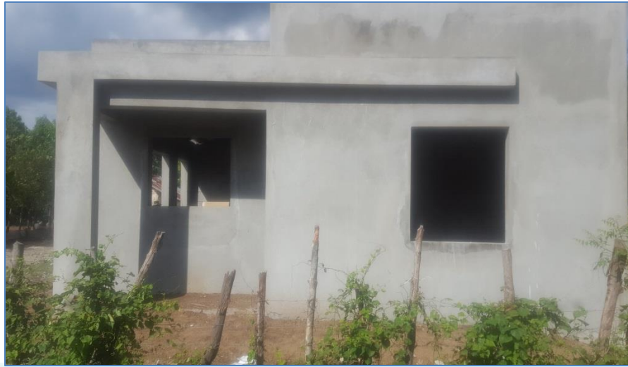
Colocación de pañete frontal, casa del Sr. Ignacio Perdomo, Viviendas Económicas.
