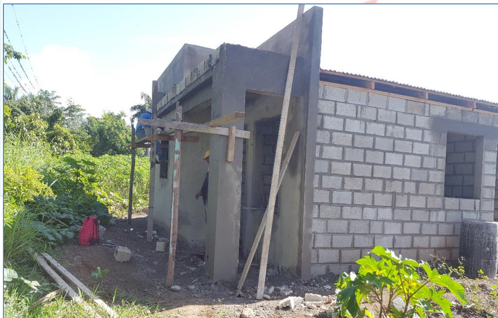
Terminación de pañete, casa del Sra. Marcia Mateo, Viviendas Económicas.
