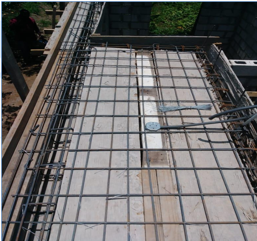
Colocación de acero en losas, casa de la Sra. Miladys Ramírez, Viviendas Económicas.
