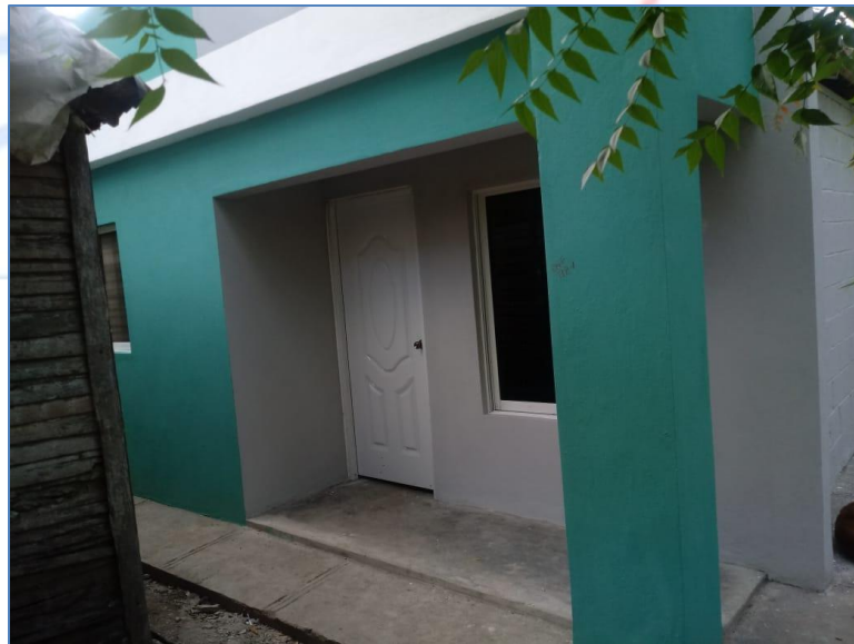
Vivienda terminada, casa del sr. Fausto Encarnación, Viviendas Económicas.
