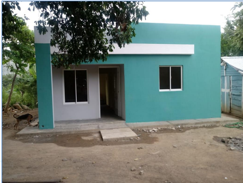
Vivienda terminada, casa del sr. Aquilino Arno, Viviendas Económicas.
