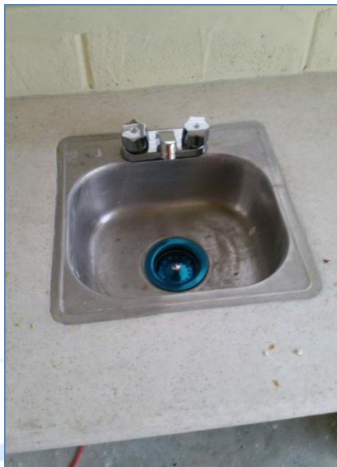
Instalación de fregadero, casa del sr. Adilanio Jiménez, Viviendas Económicas.
