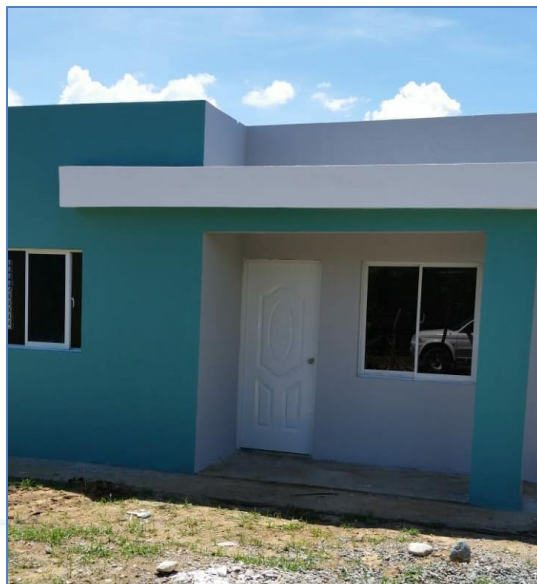
Pintura exterior, casa del Sr. Juan Suero de los santos, Viviendas Económicas.
