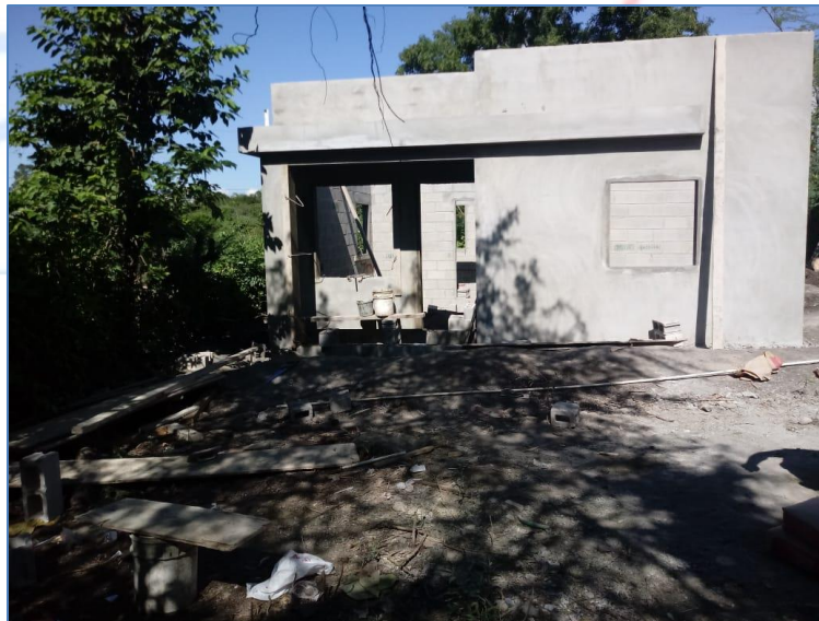
Pañete en fachada, casa del Sr. Desiderio Ramírez, Viviendas Económicas.
