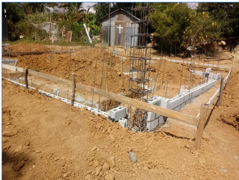
Colocación de bloques, casa de la Sra. Danirda Arno Alcántara, Viviendas Económicas.
