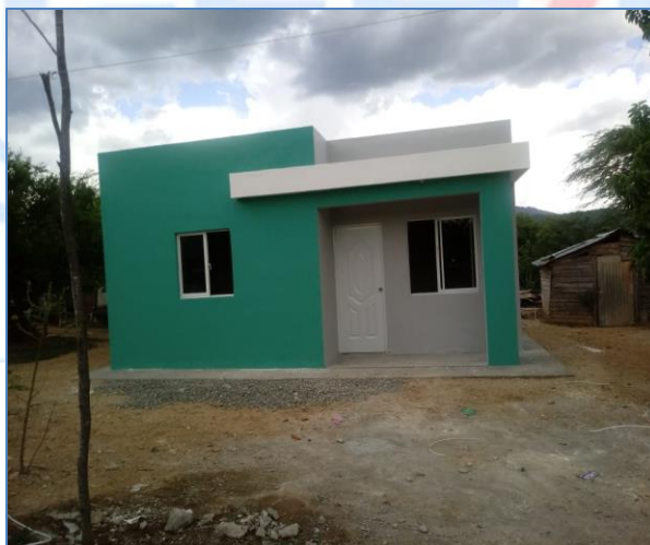
Pintura exterior, casa del Sr. Narciso Suero de los santos, Viviendas Económicas.
