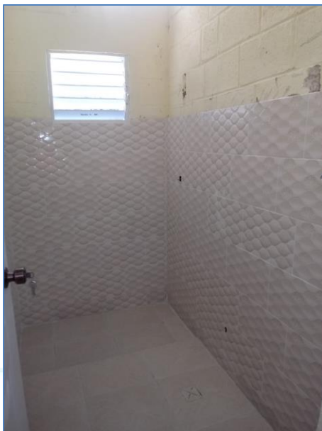
Colocación de cerámica en baño, casa del sr. Aquilino Arno, Viviendas Económicas.
