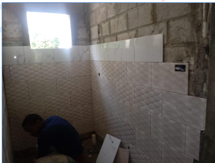
Colocación de cerámica en baño, casa del sr. Fausto Encarnación, Viviendas Económicas.
