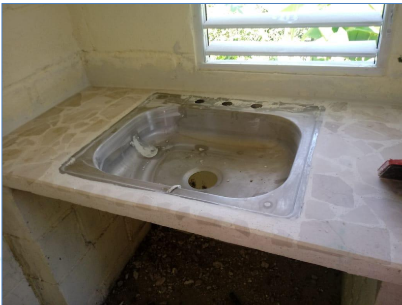
Instalación de fregadero en cocina, casa del Sra. Mercedes Suero, Viviendas Económicas.
