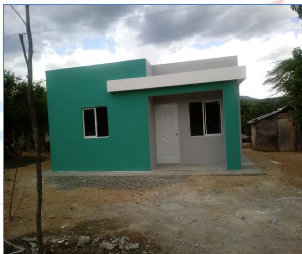
Pintura exterior, casa del Sr. Narciso Suero de los santos, Viviendas Económicas.
