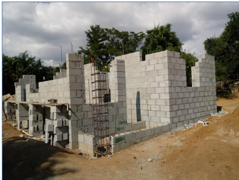
Colocación de bloques hasta nivel de dintel, casa de la Sra. Danirda Arno Alcántara, Viviendas Económicas.
