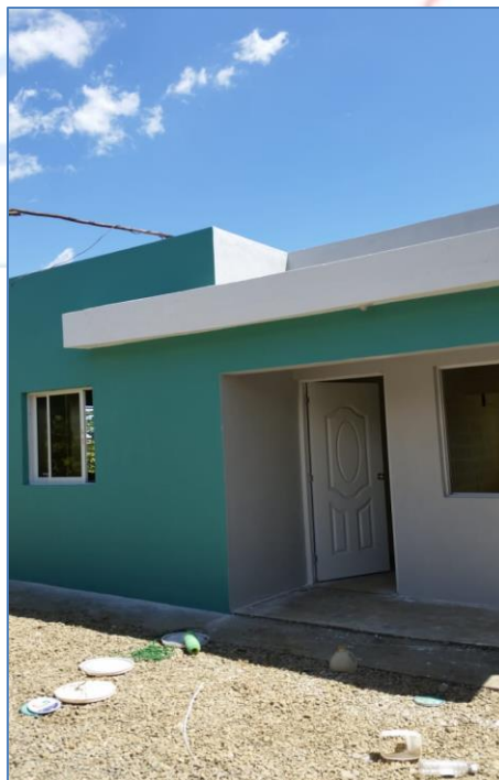
Puertas y ventanas colocadas, casa del sr. Miguel Arno, Viviendas Económicas.
