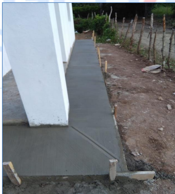
Construcción de acera perimetral, casa de la Sra. Reyita Solís, Viviendas Económicas.
