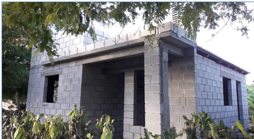
Techo de Zinc Instalado, casa del Sr. Maximiliano Jiménez, Viviendas Económicas.
