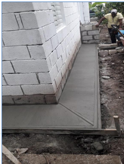
Construcción acera perimetral, casa del Sra. Heroína Ramírez, Viviendas Económicas.
