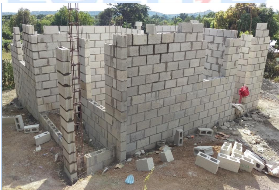
Colocación de bloques hasta nivel de dintel, casa de la Sra. Autria Arno, Viviendas Económicas.
