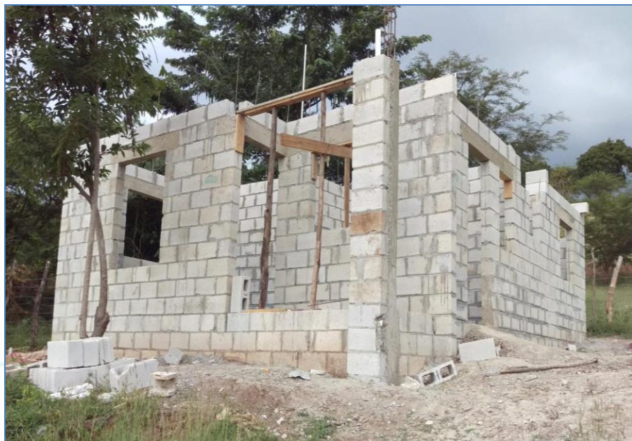
Vaciado de dinteles, casa de la Sra. Felicia Suero, Viviendas Económicas.
