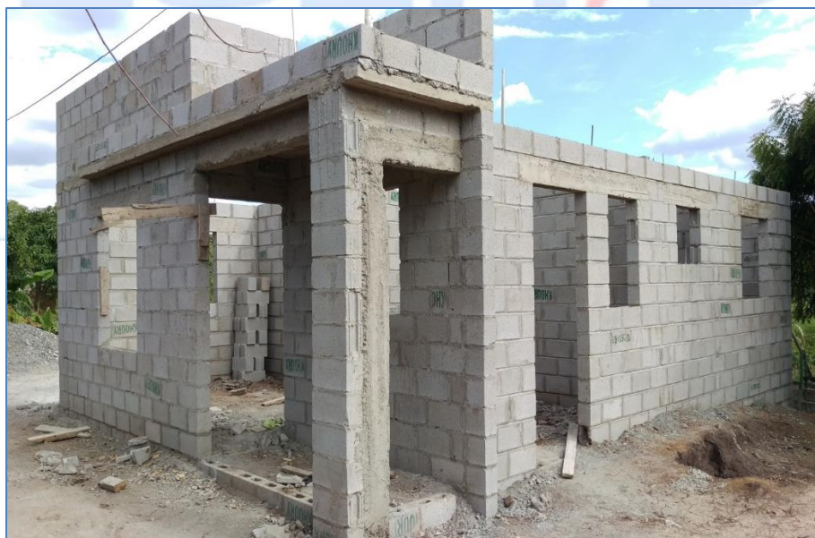
Vaciado de dinteles y losa, casa del Sr. Talin Valdez, Viviendas Económicas.
