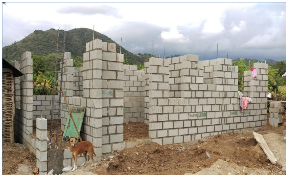
Colocación de bloques hasta nivel de dintel, casa del Sr. Félix Suero, Viviendas Económicas.
