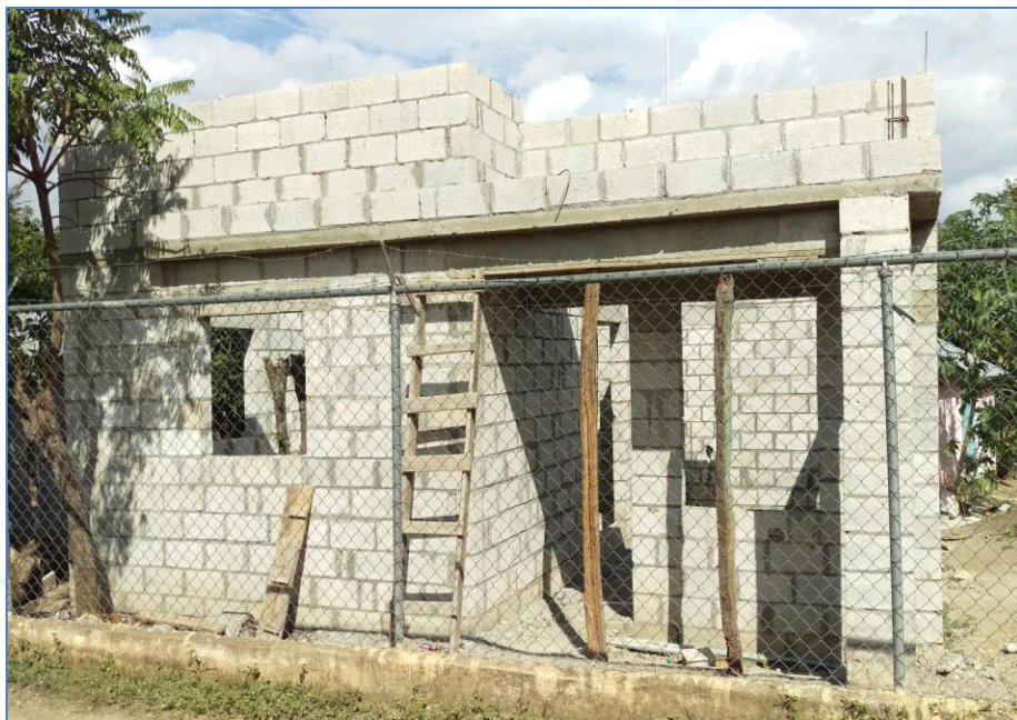
Losas y Dinteles vaciados, casa de la Sra Ovidia Solis, Viviendas Económicas.
