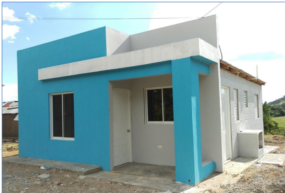
Aplicación de pintura exterior, casa del Sr. Gustavo Perdomo, Viviendas Económicas.
