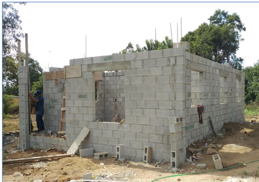
Encofrado de dinteles y columnas, casa del Sr. Anatalio Solís, Viviendas Económicas.
