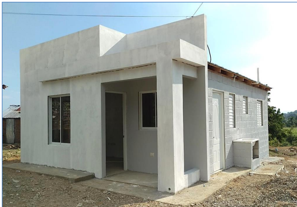
Aplicación de pintura exterior e interior, casa del Sr. Gustavo Perdomo, Viviendas Económicas.
