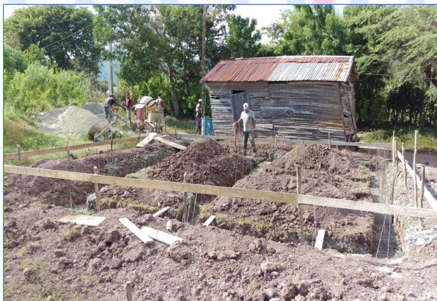
Excavación de zapatas, casa del Sr. Martín Valdez, Viviendas Económicas
