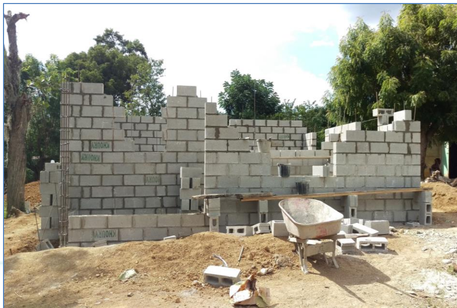
Colocación de bloques sobre nivel de piso, casa del Sr. Anatalio Solís, Viviendas Económicas.
