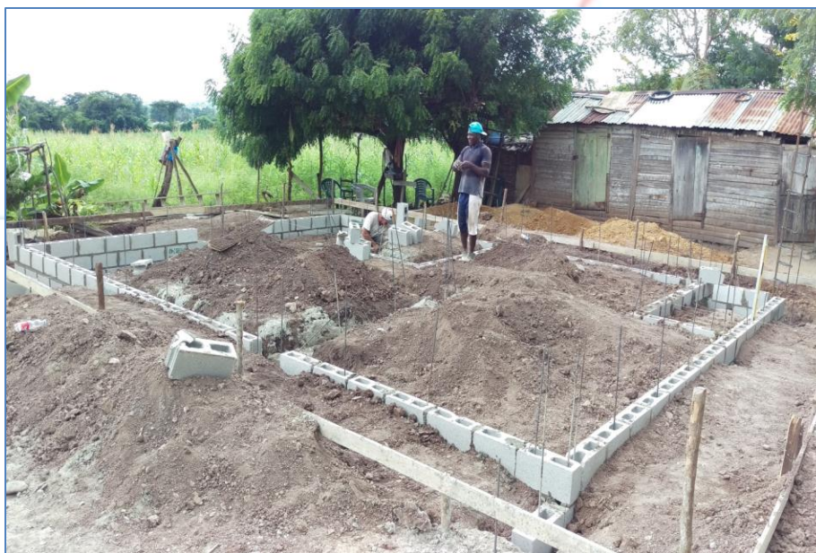
Colocación de bloques bajo nivel de piso, casa del Sr. Talin Valdez, Viviendas Económicas.
