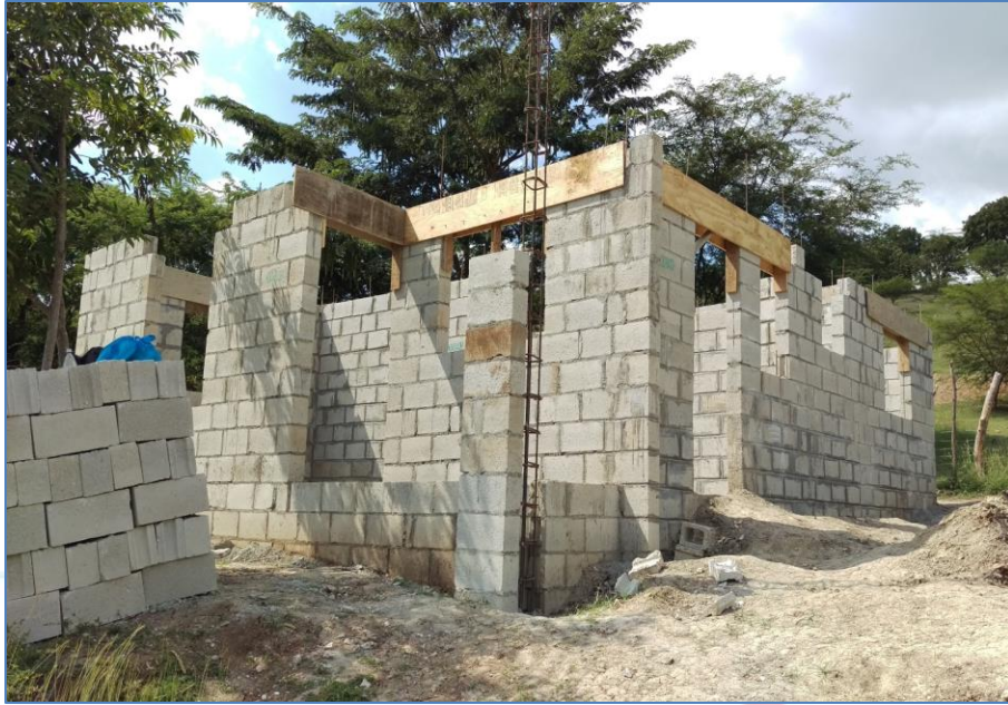
Encofrado de dinteles, casa de la Sra. Felicia Suero, Viviendas Económicas.
