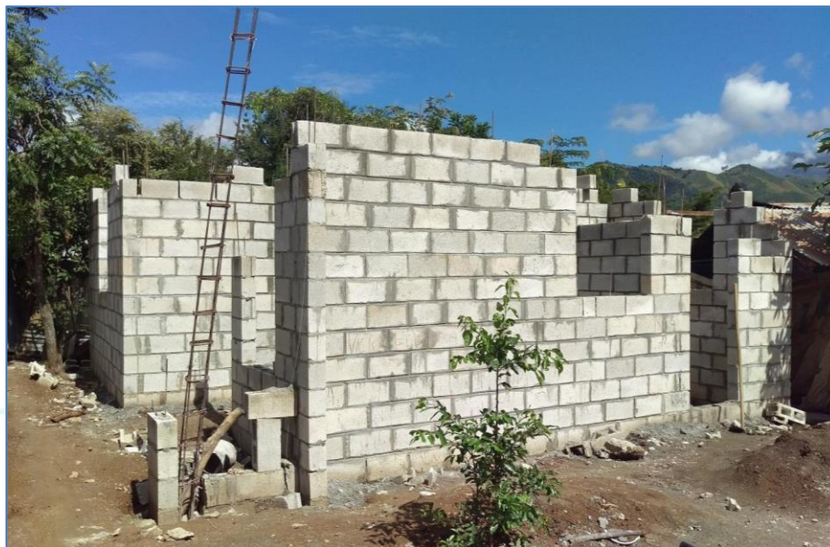
Colocación de bloques hasta nivel de dintel, casa de la Sra Ovidia Solis, Viviendas Económicas.
