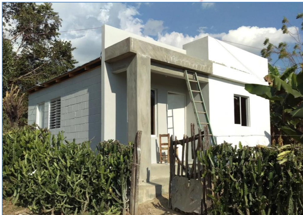
Aplicación de pintura exterior e interior, casa del Sr. Eridanio Ramírez, Viviendas Económicas.
