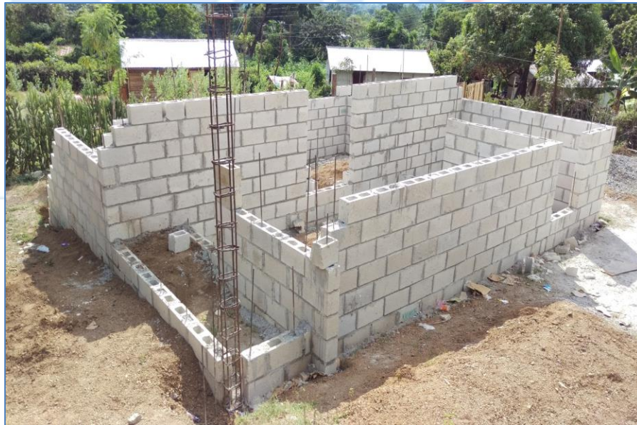
Colocación de bloques sobre nivel de piso, casa de la Sra. Autria Arno, Viviendas Económicas.
