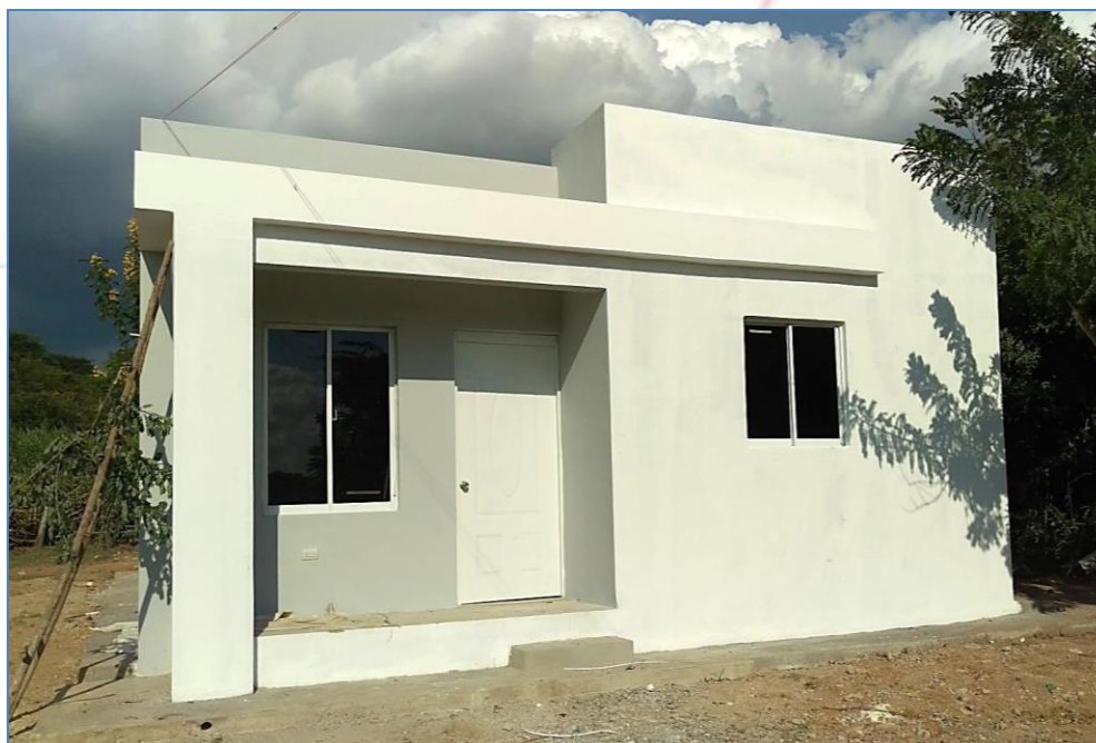
Aplicación de pintura exterior e interior, casa del Sr. Arcenio Ramírez, Viviendas Económicas.
