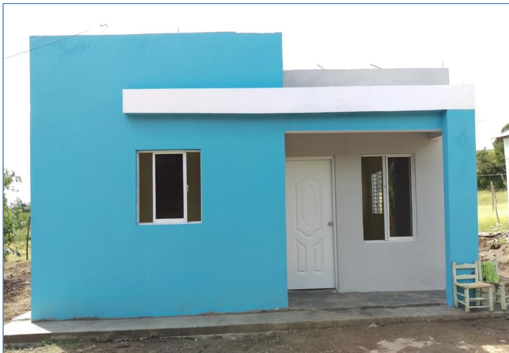
Aplicación de pintura en fachada, casa de la Sra. Elvira Solís, Viviendas Económicas.
