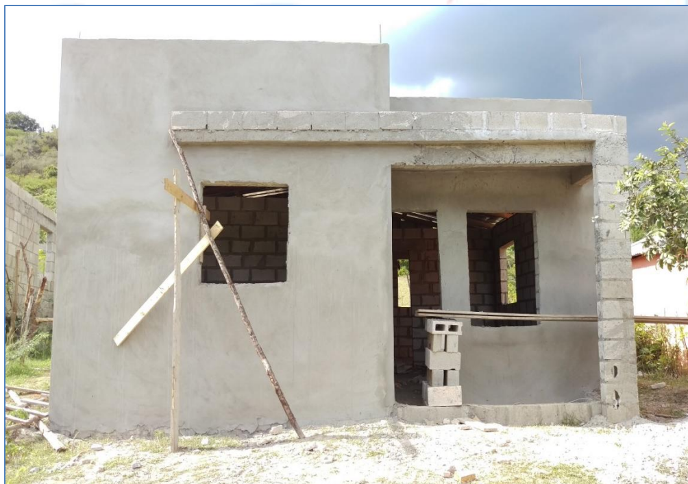
Pañete en fachada, casa del Sr. Cesar Durán, Viviendas Económicas.
