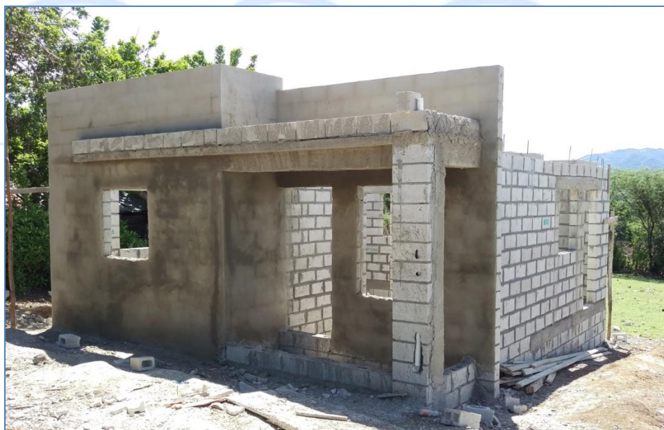
Colocación de pañete Frontal, casa del Sr. Vitalio Durán, Viviendas Económicas.
