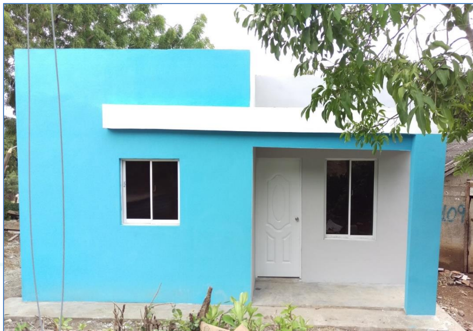
Aplicación de pintura en fachada, casa del Sr. Manuel Genao, Viviendas Económicas.
