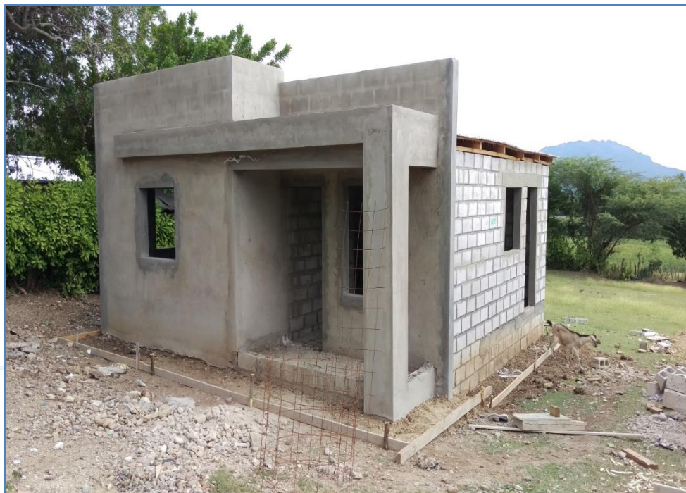
Colocación de zinc acanalado, casa del Sr. Vitalio Durán, Viviendas Económicas.
