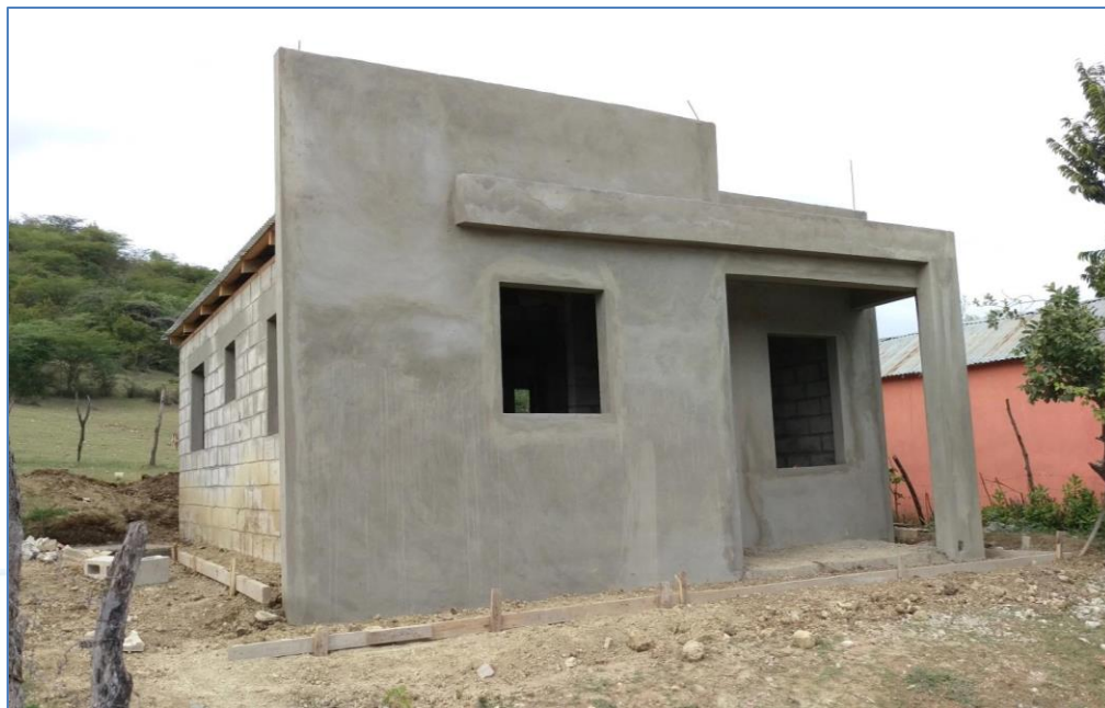
Colocación de zinc acanalado, casa del Sr. Cesar Durán, Viviendas Económicas.
