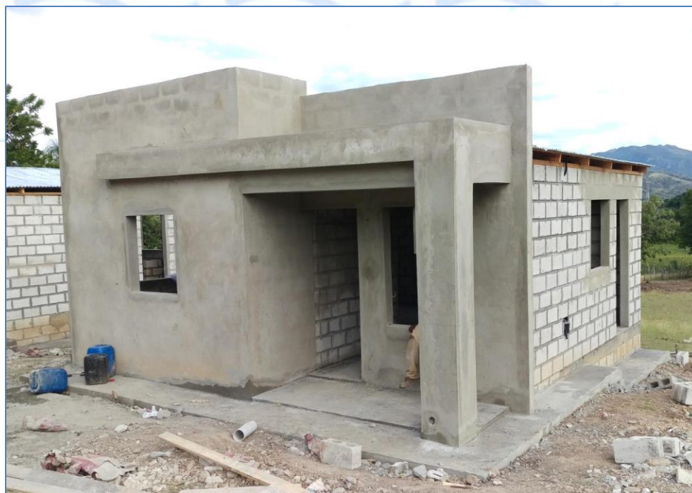
Vaciado de acera perimetral, casa del Sr. Antonio Suero, Viviendas Económicas.
