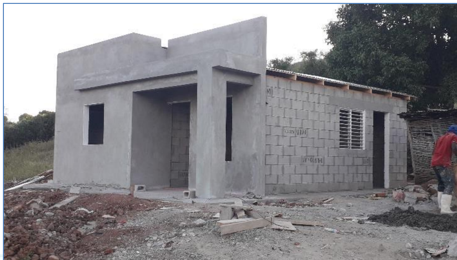
Pañete exterior, casa del Sr. Alcenio Matos, Viviendas Económicas.
