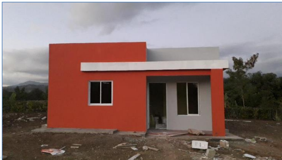
Aplicación de pintura exterior, casa del Sr. Leónidas Valdez, Viviendas Económicas.
