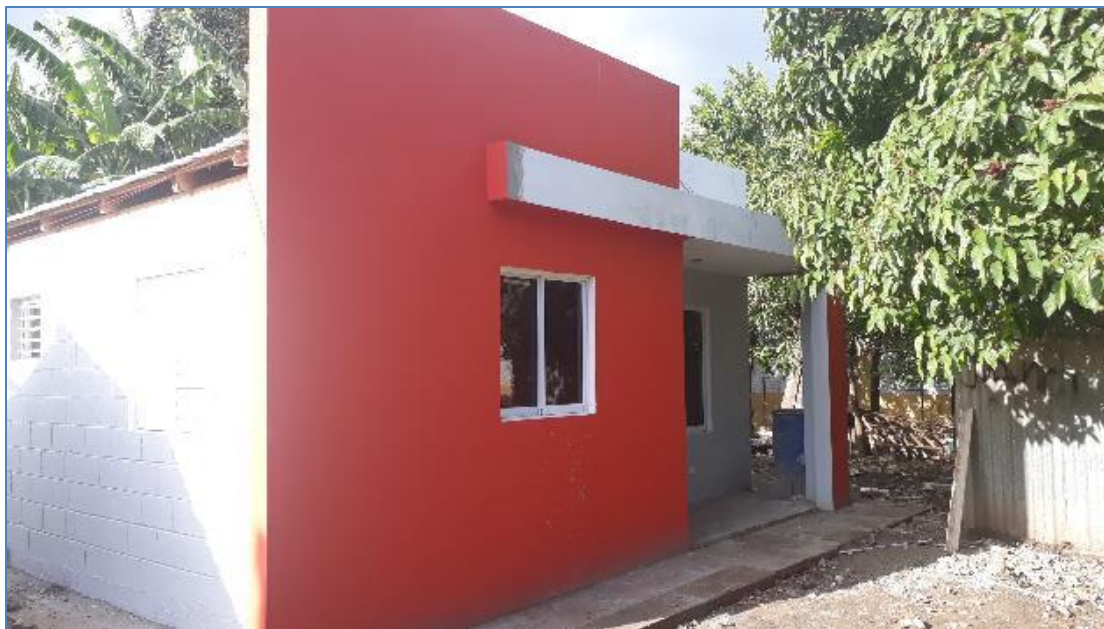
Pintura Exterior, casa del Sr. Reinaldo del Carmen, Viviendas Económicas.
