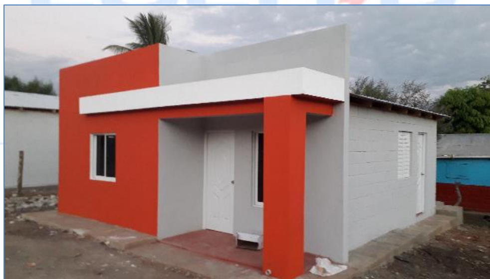
Aplicación de pintura exterior, casa de la Sra. Rosa Matos, Viviendas Económicas.
