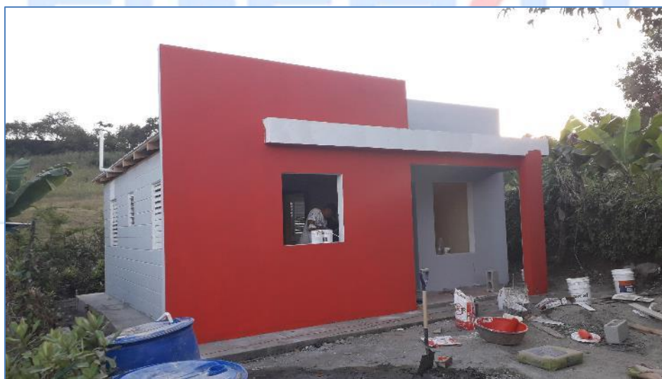
Aplicación de pintura exterior, casa de la Sra. Josefina Beltré, Viviendas Económicas.
