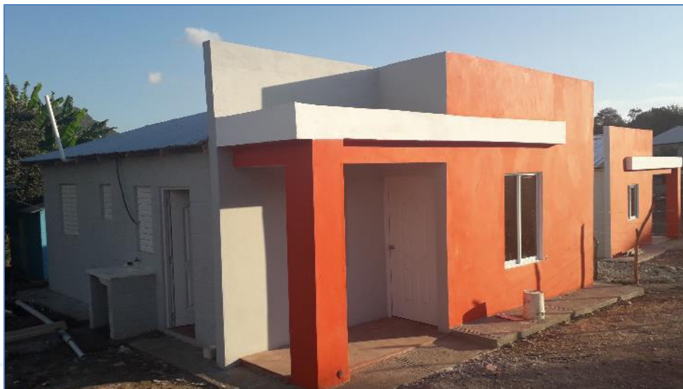
Aplicación de pintura exterior, casa del Sr. Prajido Mesa, Viviendas Económicas.
