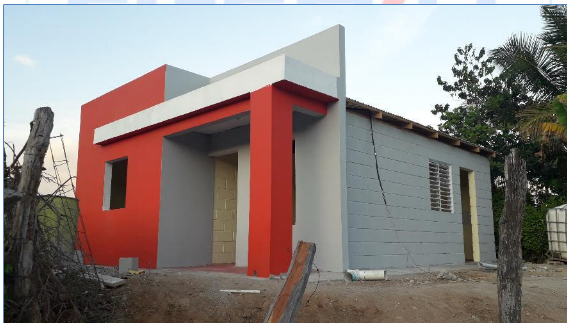
Aplicación de pintura exterior, casa del Sr. Bienvenido del Carmen, Viviendas Económicas
