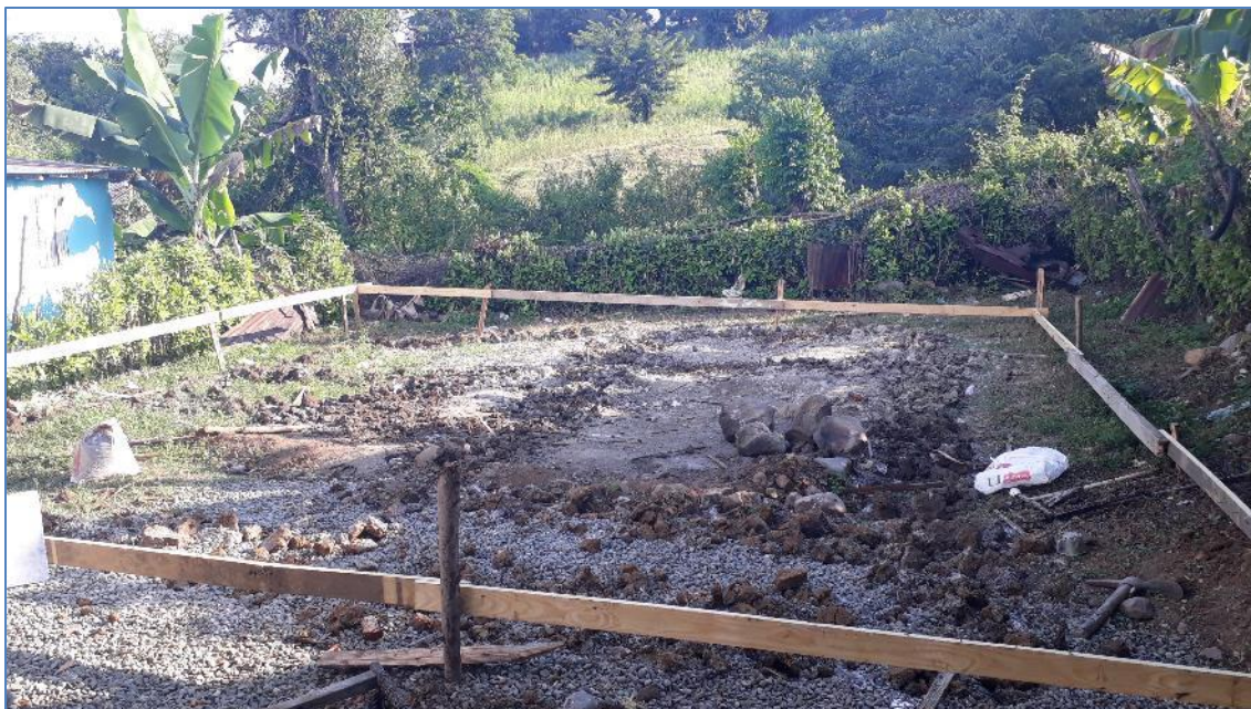
Excavación de zapatas, casa del Sr. Alcenio Matos, Viviendas Económicas.
