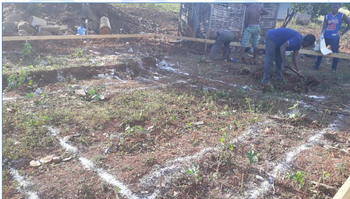
Excavación de zapatas, casa de la Sra. Josefina Beltré, Viviendas Económicas.
