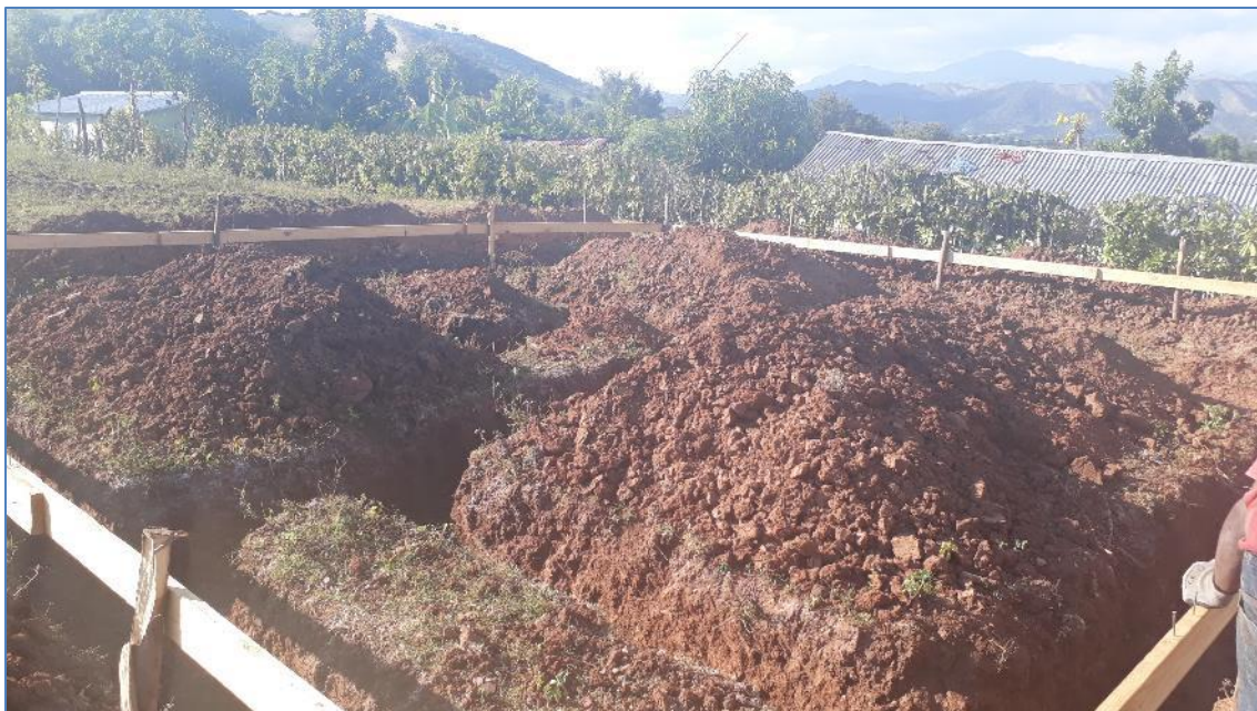
Excavación de zapatas, casa del Sr. Leónidas Valdez, Viviendas Económicas.
