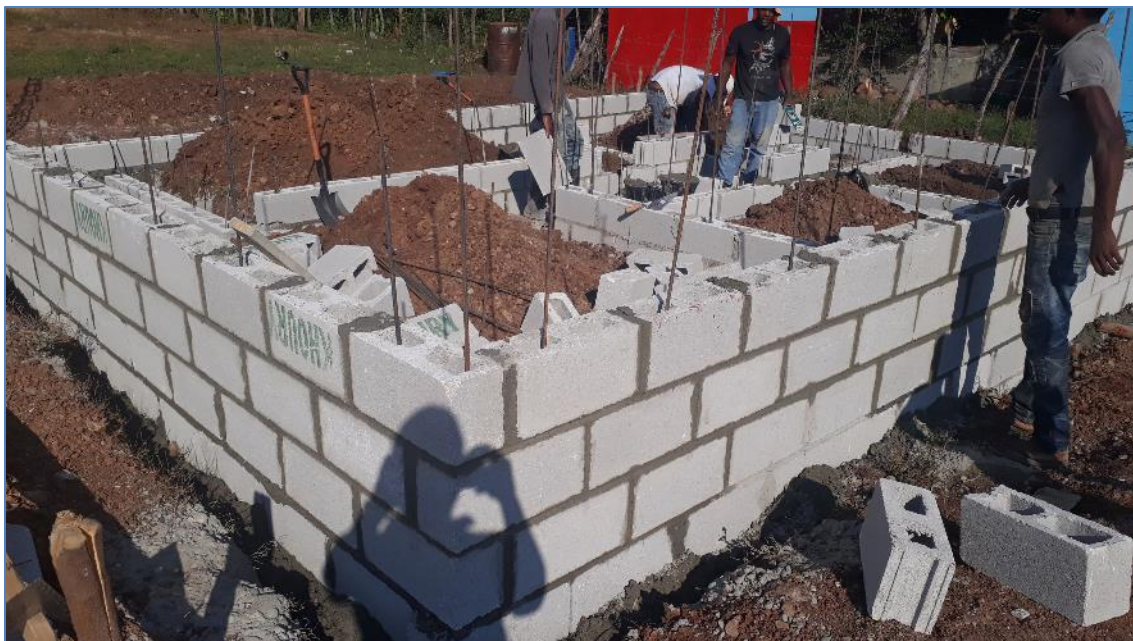
Colocación de bloques bajo nivel de piso, casa del Sr. Prajido Mesa, Viviendas Económicas.
