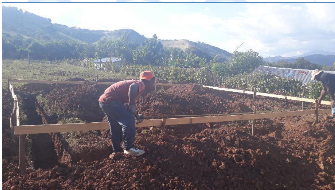
Excavación de zapatas, casa de la Sra. Rosa Matos, Viviendas Económicas.
