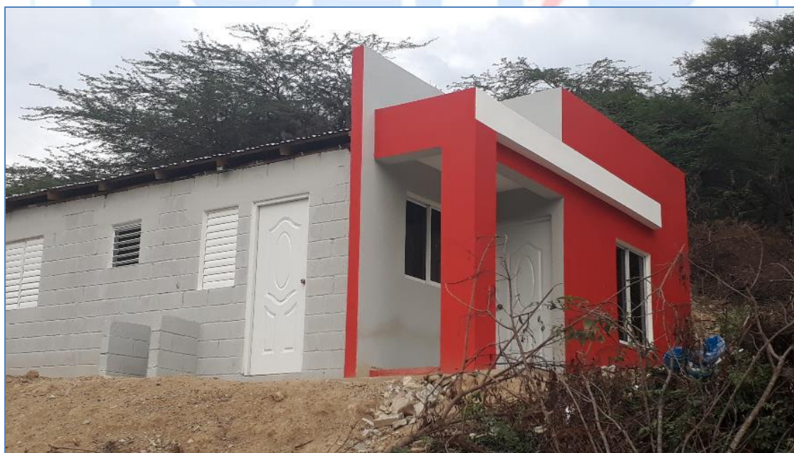
Pintura Exterior, casa del Sr. Juan Alcántara, Viviendas Económicas.
