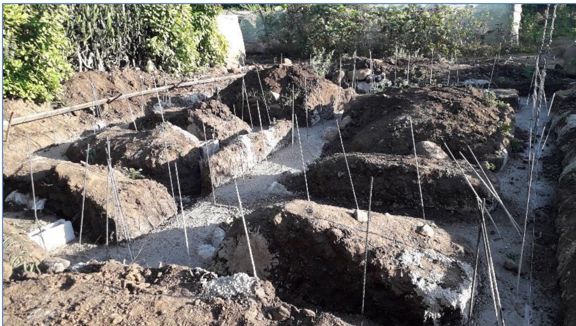
Vaciado de zapatas, casa del Sr. Carlos de la Cruz, Viviendas Económicas.
