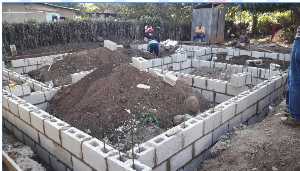
Colocación de bloques bajo nivel de piso, casa de la Sra. Angela del Carmen de la Cruz, Viviendas Económicas.
