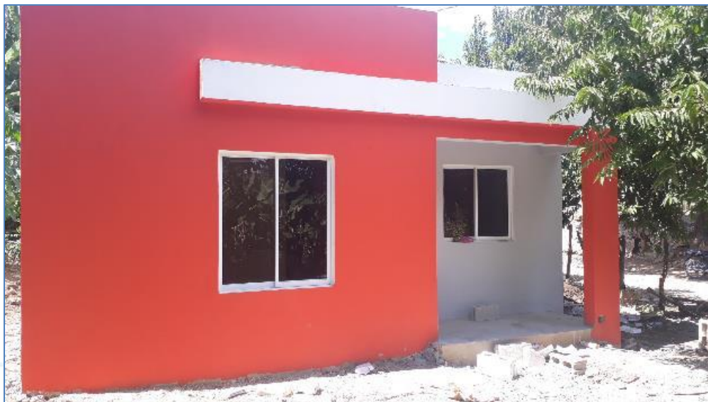
Instalación de puertas y ventanas, casa del Sr. Paulino Cabral, Viviendas Económicas.
