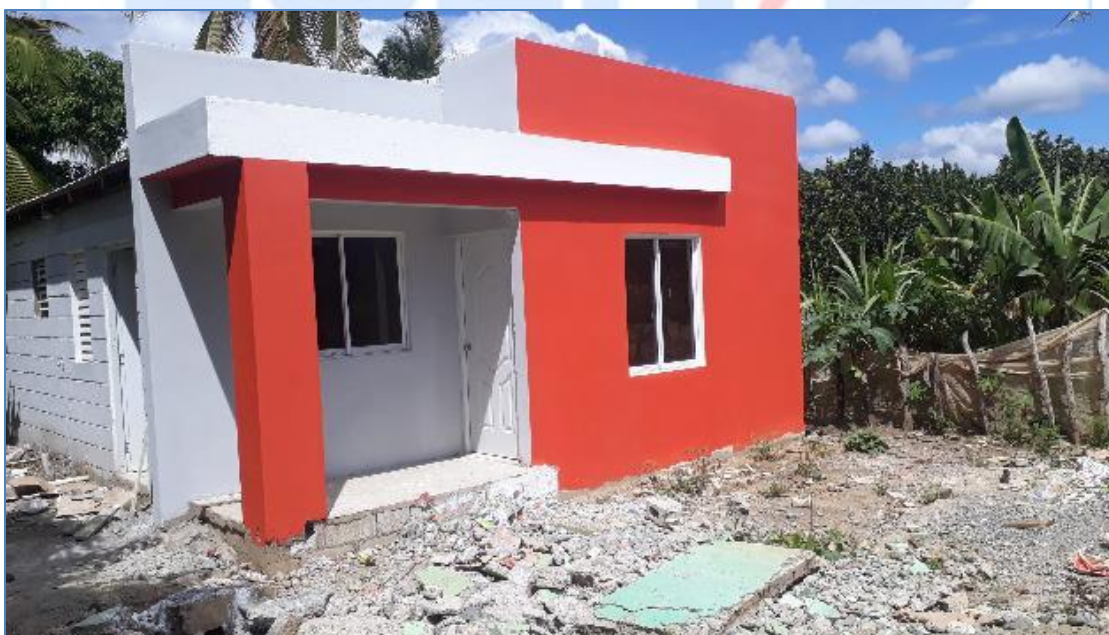
Instalación de puertas y ventanas, casa de la Sra. Aurora Suero, Viviendas Económicas.
