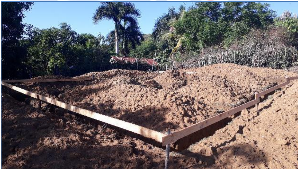
Construcción de charranca para el replanteo, casa del Sr. Paulino Cabral, Viviendas Económicas.
