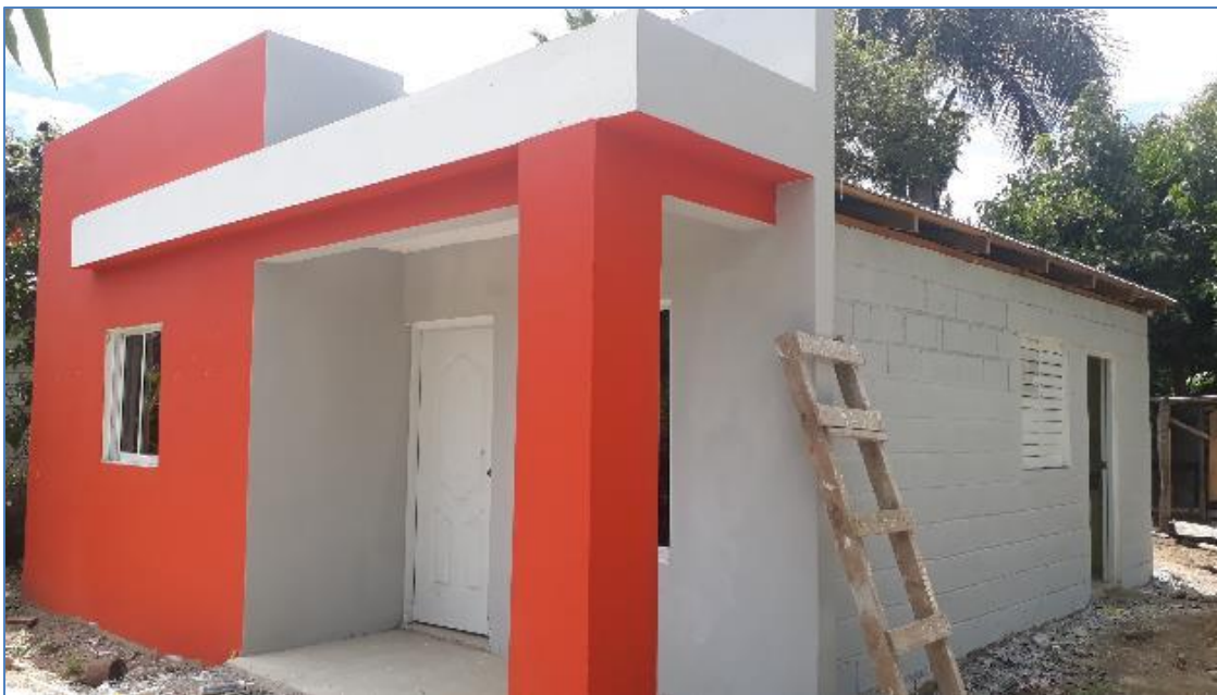
Pintura Exterior, casa del Sr. Juan Ramírez, Viviendas Económicas.
