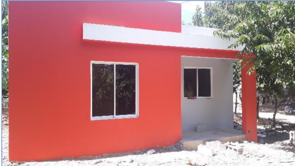
Instalación de puertas y ventanas, casa del Sr. Paulino Cabral, Viviendas Económicas.
