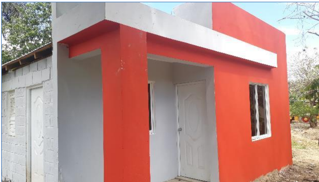
Instalación de puertas y ventanas, casa de la Sra. Catalina Arnaut, Viviendas Económicas.
