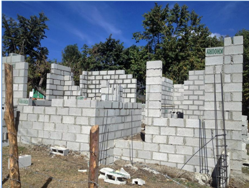
Colocación de bloques a nivel de dintel, casa de la Sra. Digna del Carmen, Viviendas Económicas.
