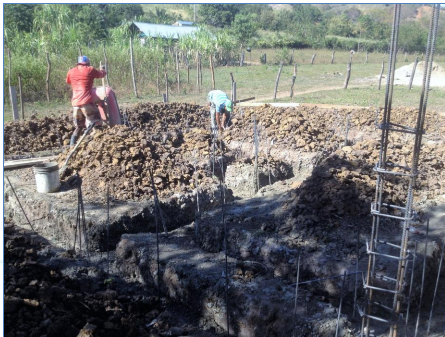
Vaciado de zapatas, casa de la Sr. Pascual del Carmen, Viviendas Económicas.
