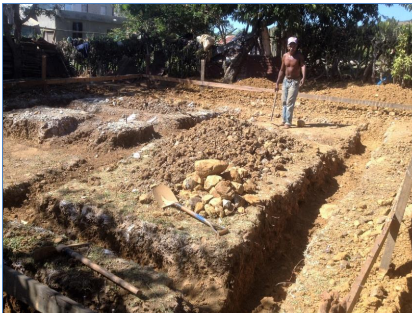
Excavación de zapatas, casa de la Sr. Ramiro Rosario, Viviendas Económicas.
