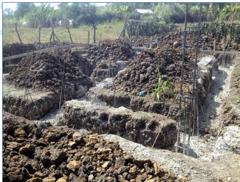
Vaciado de hormigón en zapatas, casa de la Sr. Roberto Suero, Viviendas Económicas.
