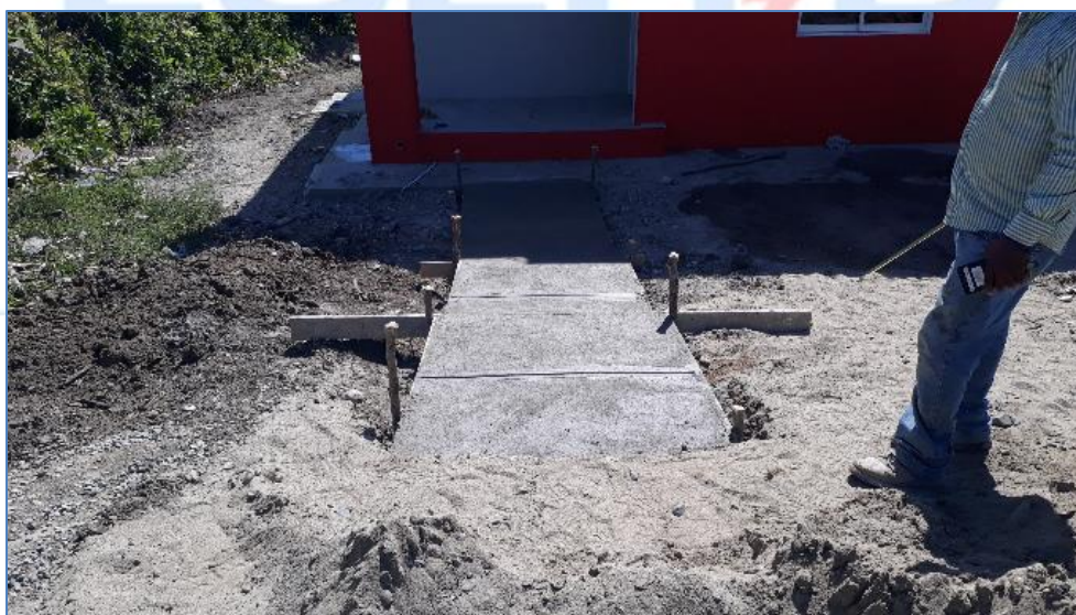
Construcción de acera, casa del Sra. Nereyda Suero, Viviendas Económicas.
