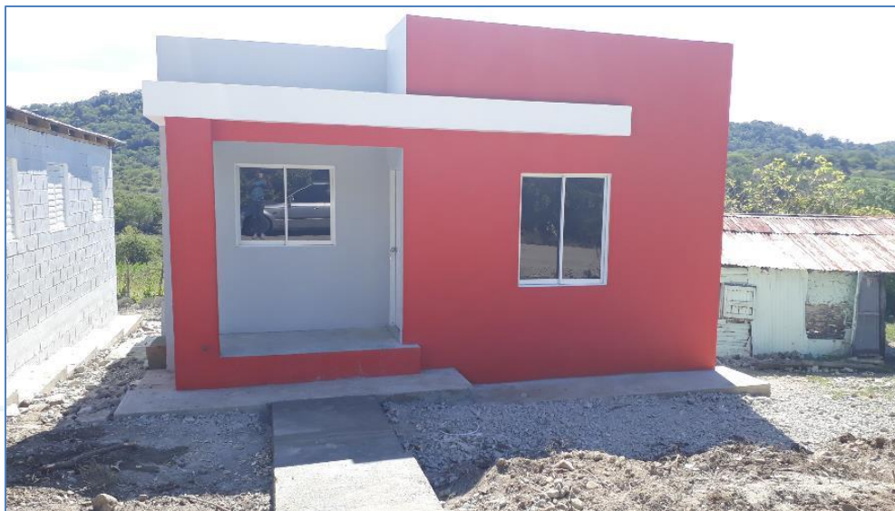
Construcción de acera, casa del Sr. Limardo Suero, Viviendas Económicas.
