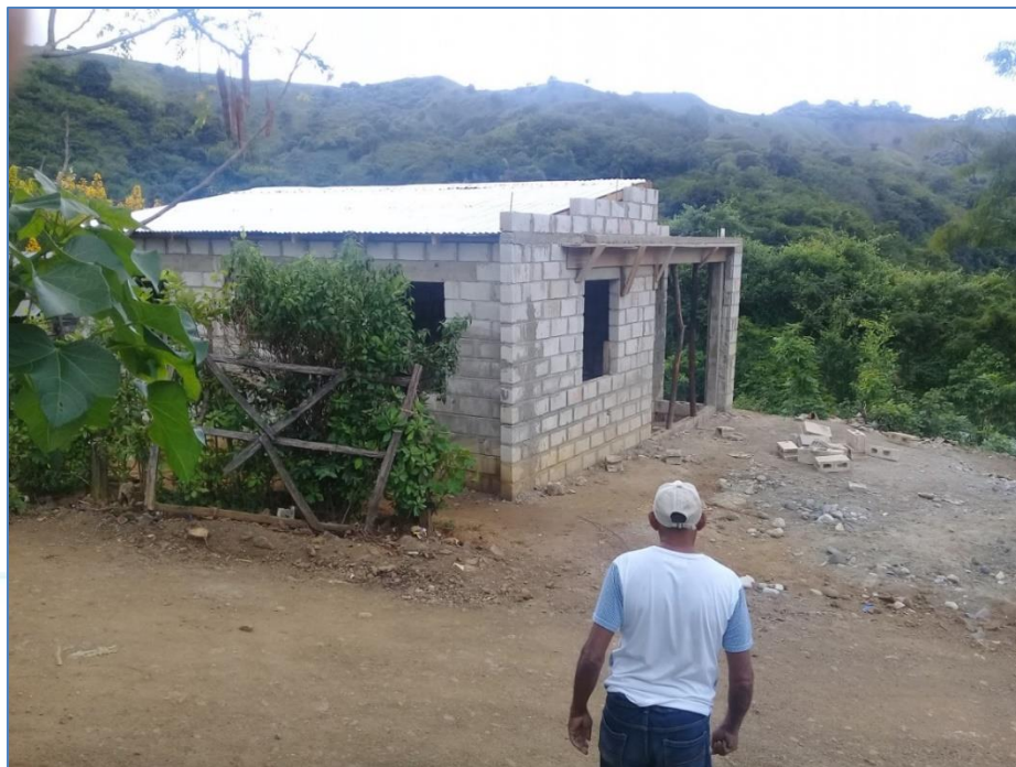
Colocación de techo de zinc, casa del Sr. Manuel Ramírez, Viviendas Económicas.
