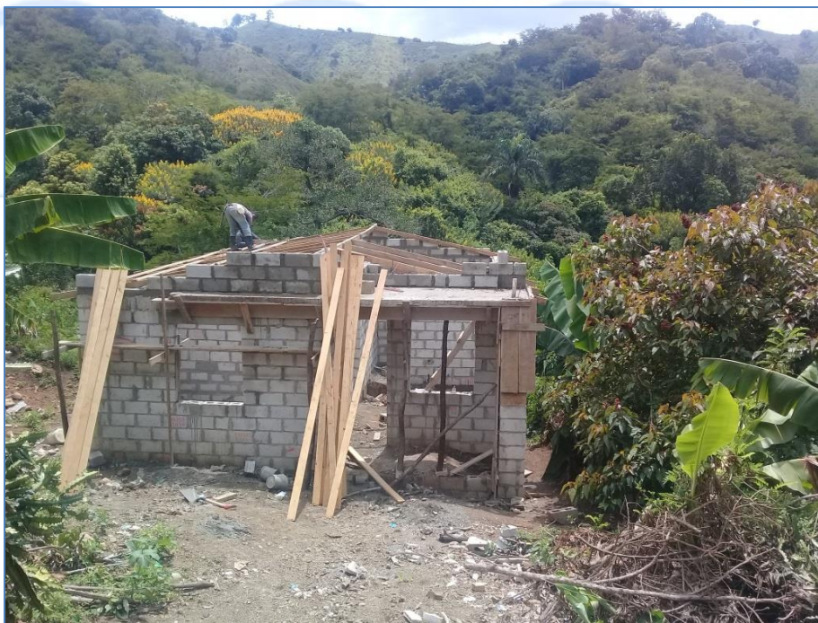
Colocación de estructura de madera para el techo, casa de la Sra. Edilenia Ramírez, Viviendas Económicas.
