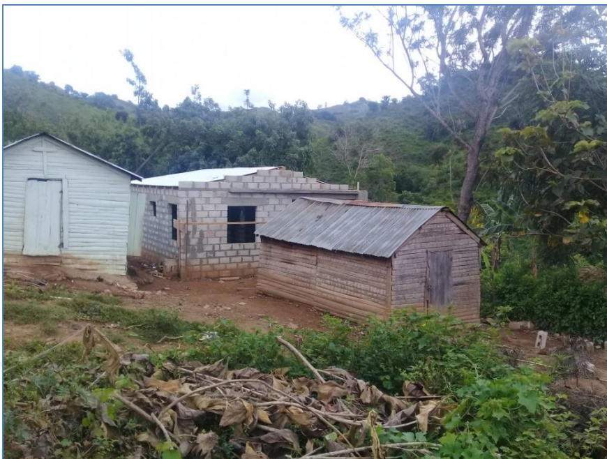
Colocación de techo de zinc, casa del Sr. Freddy Ramírez, Viviendas Económicas.
