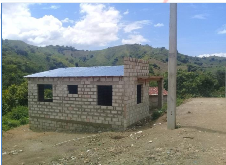
Colocación de techo de zinc, casa del Sr. Percido Ramírez, Viviendas Económicas.
