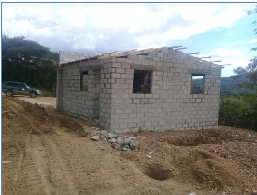
Colocación de estructura en techo, casa del Sr. Ramón Ramírez, Viviendas Económicas.
