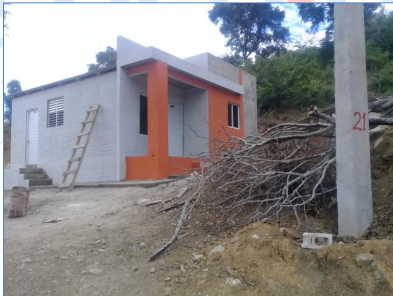
Aplicación de pintura exterior, casa de la Sra. Antonia del Carmen, Viviendas Económicas.
