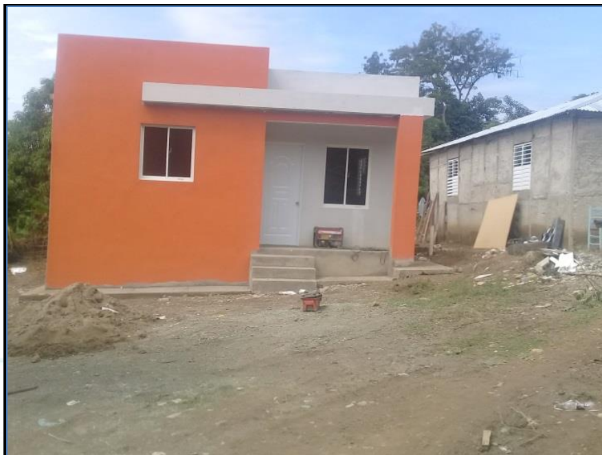
Aplicación de pintura exterior, casa de la Sra. Mary Leidy Ramírez, Viviendas Económicas.
