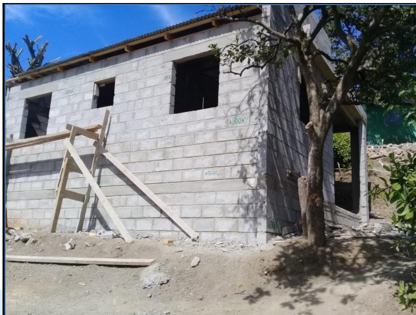
Colocación de zinc acanalado en techo, casa de la Sra. Yirania del Carmen, Viviendas Económicas.
