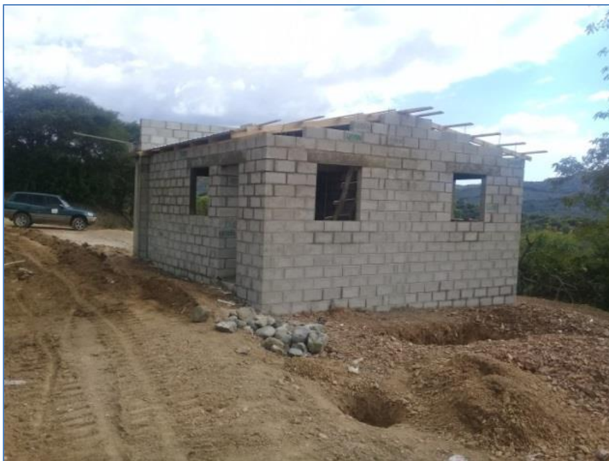
Colocación de estructura en techo, casa del Sr. Ramón Ramírez, Viviendas Económicas.
