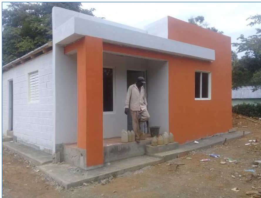
Aplicación de pintura exterior, casa del Sr. Luis Miguel Rodríguez, Viviendas Económicas.
