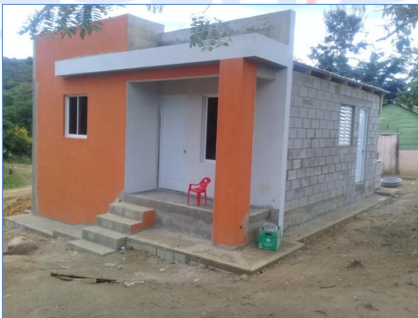
Aplicación de pintura exterior, casa del Sr. Ramiro Reyes, Viviendas Económicas.
