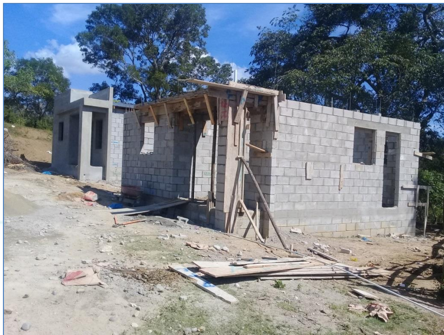
Vaciado de losa, casa del Sr. Chijo Jiménez, Viviendas Económicas.
