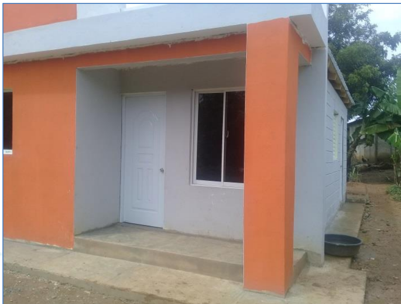
Instalación de puertas y ventanas, casa del Sr. Gerineldo Arno, Viviendas Económicas.
