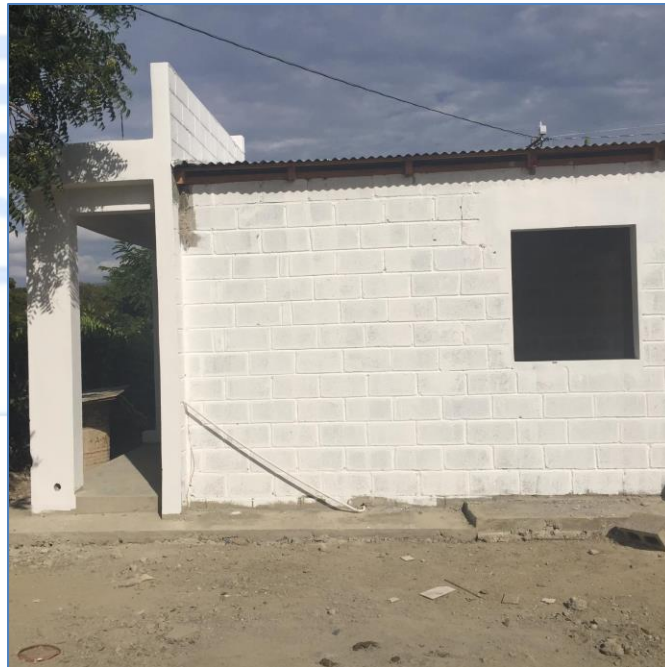
Aplicación de pintura base, casa del Sr. Adriano Jiménez, Viviendas Económicas.
