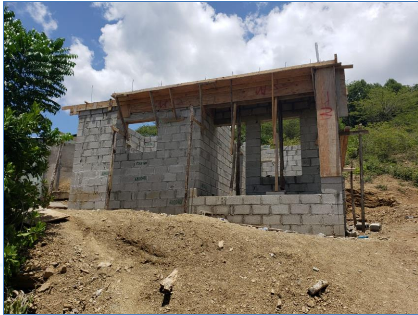
Vaciado de losa, casa de la Sra. Estefania Lebrón, Viviendas Económicas.
