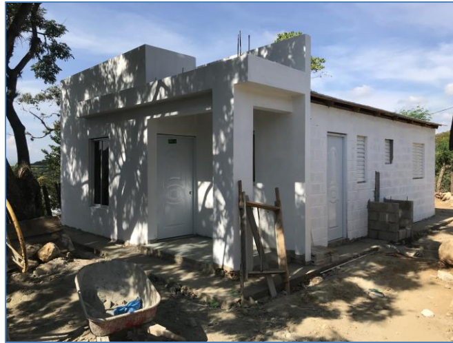
Aplicación de pintura base, casa del Sr. Adriano Vírgenes Suero, Viviendas Económicas.
