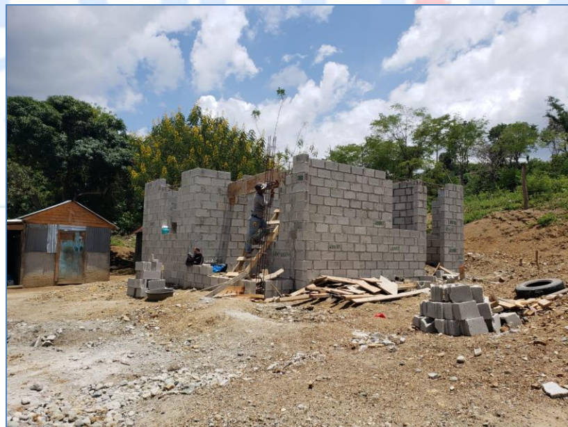
Vaciado de dinteles, casa del Sr. Elvis del Carmen, Viviendas Económicas.
