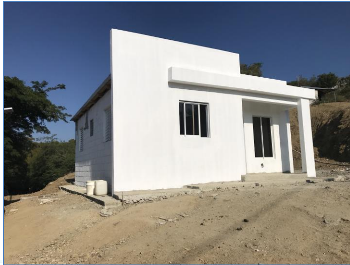
Puertas y ventanas colocadas, casa del Sr. Wilkin Jiménez, Viviendas Económicas.
