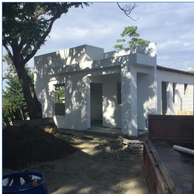
Aplicación de pintura base, casa del Sra. Vírgenes Suero, Viviendas Económicas.
