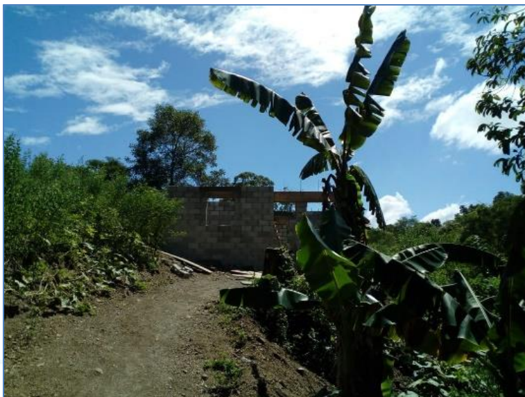
Colocación de bloques hasta nivel de dintel, casa de la Sra. Isabel Jiménez, Viviendas Económicas.
