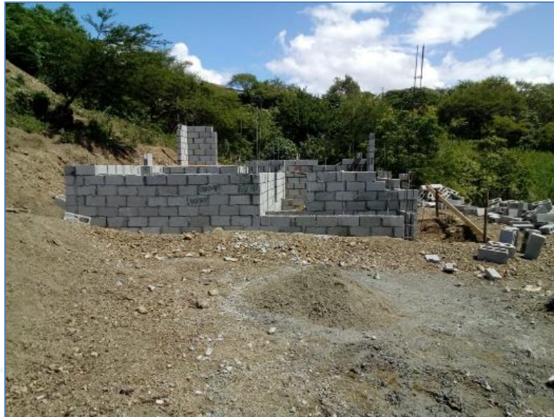
Colocación de bloques sobre nivel de piso, casa de la Sra. Alejandrina Jiménez Hernández, Viviendas Económicas.
