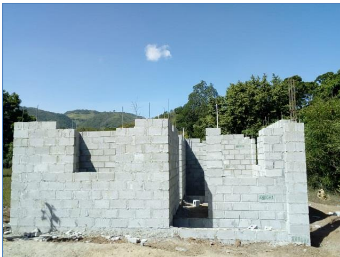
Colocación de bloques hasta nivel de dintel, casa del sr. Andric Lebrón, Viviendas Económicas.
