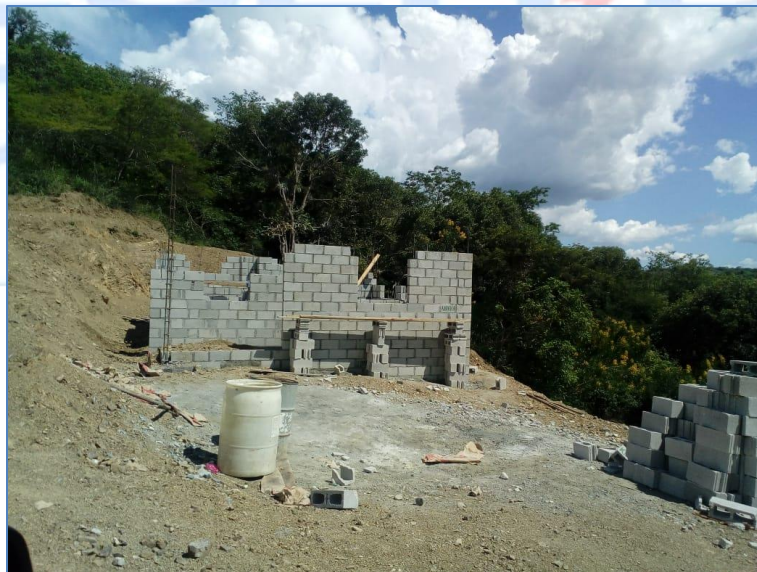
Colocación de bloques sobre nivel de piso, casa de la Sra. Minaya Suero Hernández, Viviendas Económicas.
