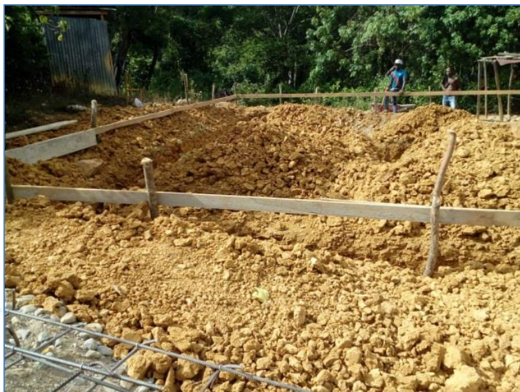
Construcción de charrancha, casa del Sr. Mártires Lebrón, Viviendas Económicas.
