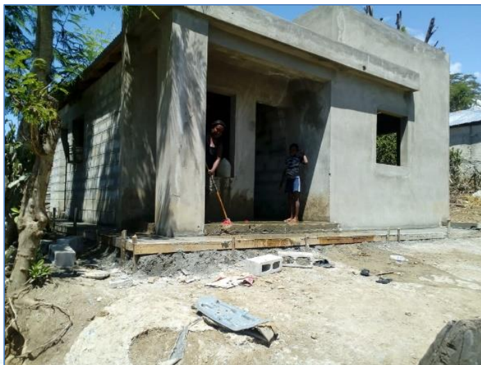
Construcción de acera perimetral, casa del sr. Andrés del Carmen, Viviendas Económicas.
