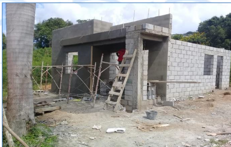
Pañete frontal, casa del Sr. Arcadio Jiménez, Viviendas Económicas.
