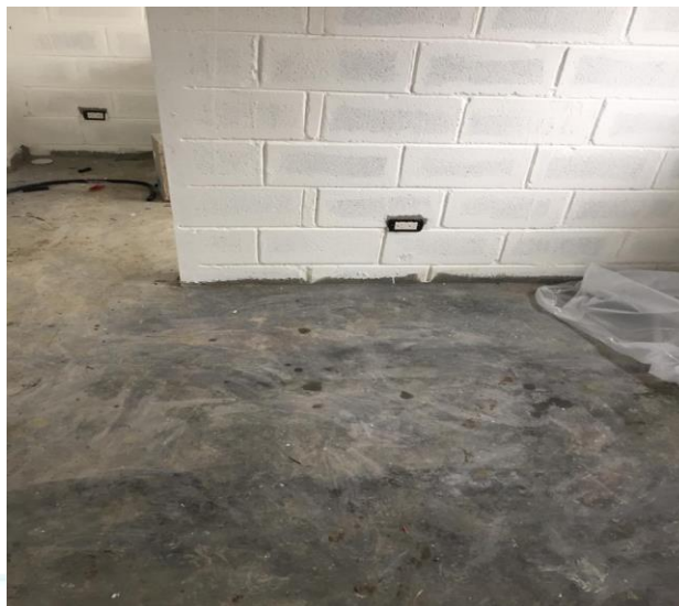
Vaciado de piso de hormigón, casa del sr. Víctor Beltré, Viviendas Económicas.
