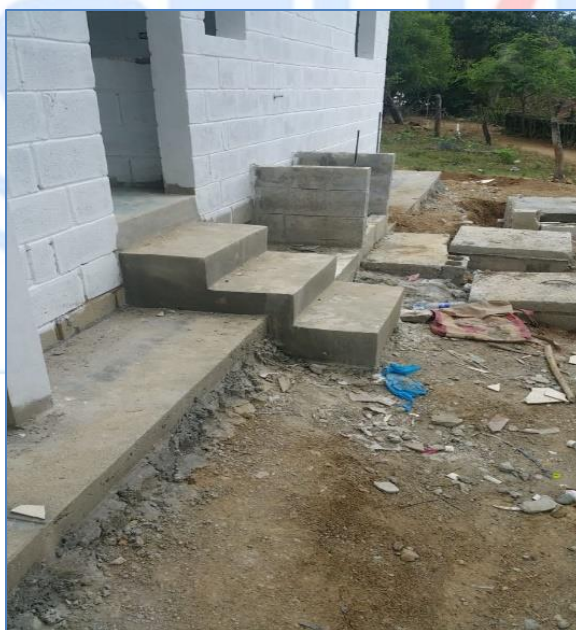
Construcción de acera perimetral, casa de la sra. Julissa Suero, Viviendas Económicas.
