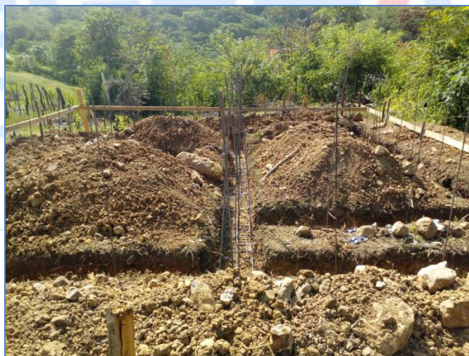
Excavación de zapatas, casa del sr. Emerio del Carmen, Viviendas Económicas.
