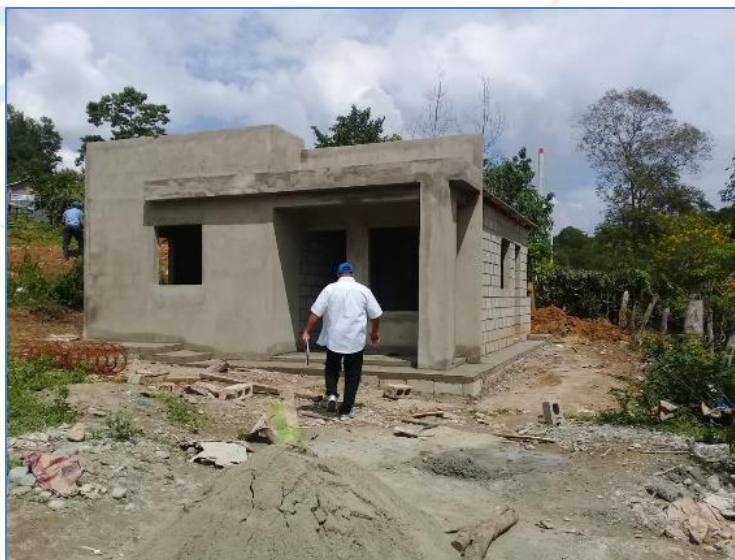
Construcción de acera perimetral, casa de la Sra. Petronila Ramírez, Viviendas Económicas.
