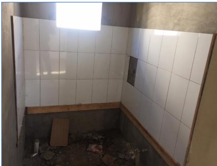
Revestimientos de paredes en baño, casa de la Sra. Carmela Ramírez, Viviendas Económicas.
