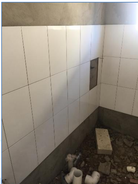
Revestimientos en paredes de baño, casa de la Sra. Susana Ramírez, Viviendas Económicas.
