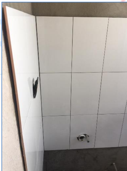
Revestimientos en paredes de baño, casa del Sr. Milciades Ramírez, Viviendas Económicas.
