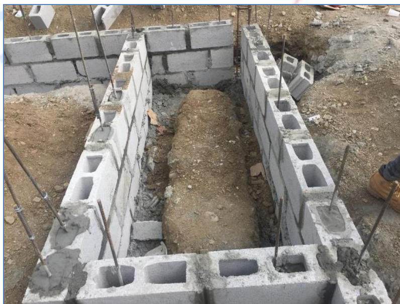
Colocación de bloques bajo nivel de piso, casa del Sr. Manuel Arnó del Carmen, Viviendas Económicas.
