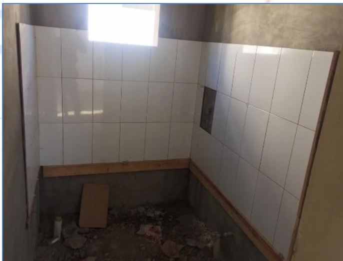
Revestimientos de paredes en baño, casa del Sr. Ramón Ramírez, Viviendas Económicas.
