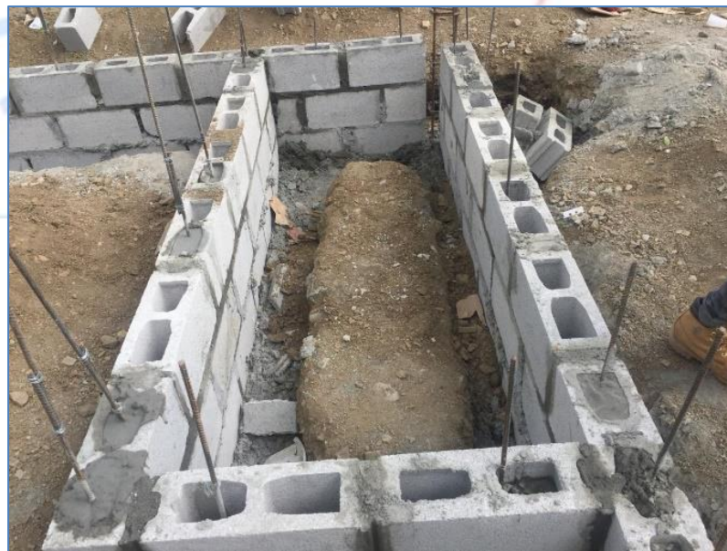
Colocación de bloques bajo nivel de piso, casa del Sr. Manuel Arnó del Carmen, Viviendas Económicas.
