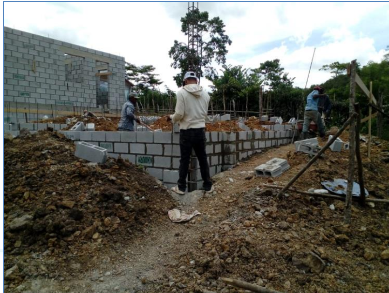
Colocación de bloques hasta nivel de piso, casa del Sr. Sergio Ramírez, Viviendas Económicas.
