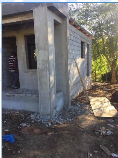
Colocación de zinc acanalado, casa del Sr. Rosendo María de la Rosa, Viviendas Económicas.
