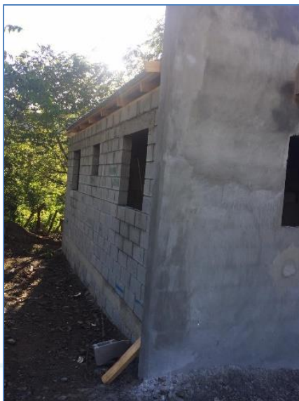
Colocación de zinc acanalado, casa del Sr. Pasito Jiménez de la Rosa, Viviendas Económicas.
