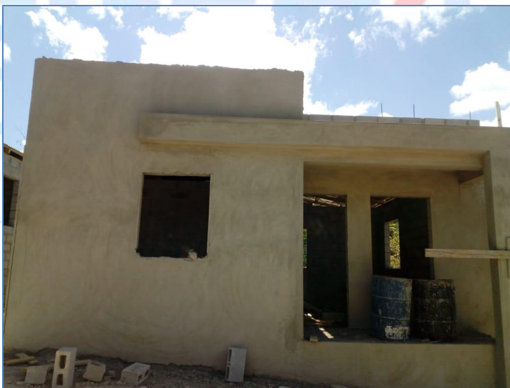
Pañete de fachada, casa del Sr. Milciades Ramírez, Viviendas Económicas.
