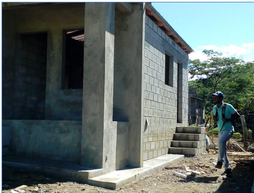
Vaciado de acera perimetral, casa de la Sra. Carmela Ramírez, Viviendas Económicas.
