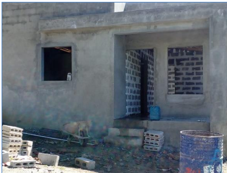
Vaciado y terminación de acera perimetral, casa de la Sra. Susana Ramírez, Viviendas Económicas.
