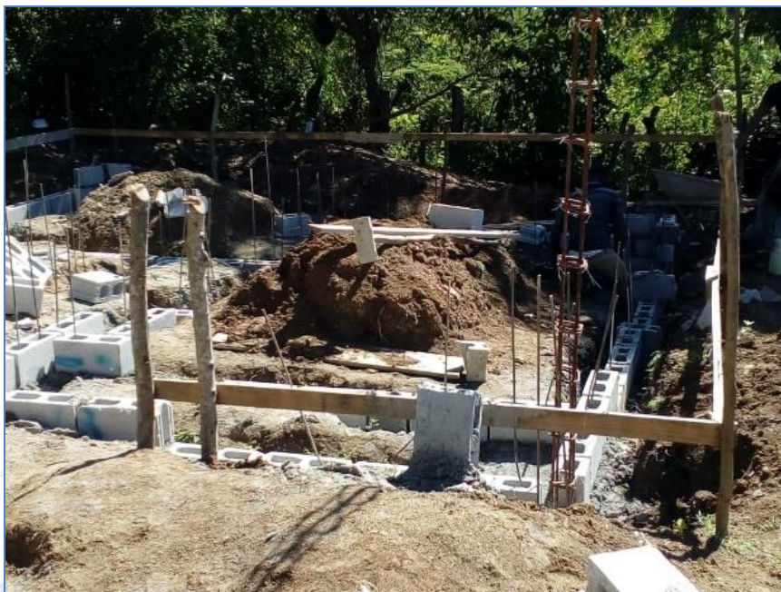
Colocación de bloques bajo nivel de piso, casa del Sr. Pasito Jiménez de la Rosa, Viviendas Económicas
