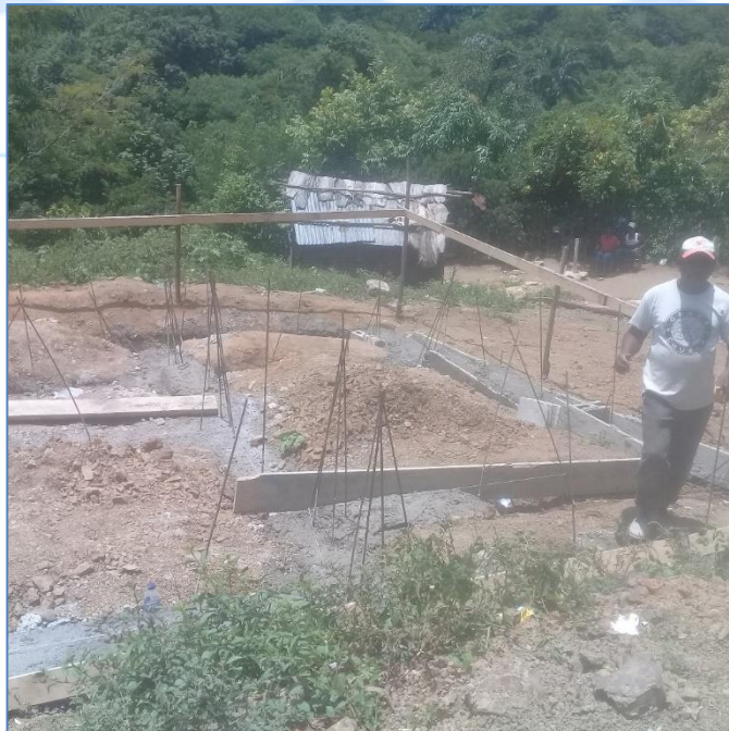
Vaciado de zapatas, casa de la Sra. Edilenia Ramírez, Viviendas Económicas.
