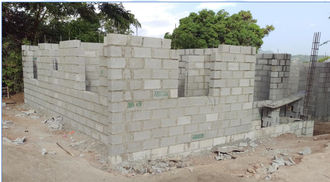
Colocación de bloques, casa del Sr. Algenis Perdomo, Viviendas Económicas.
