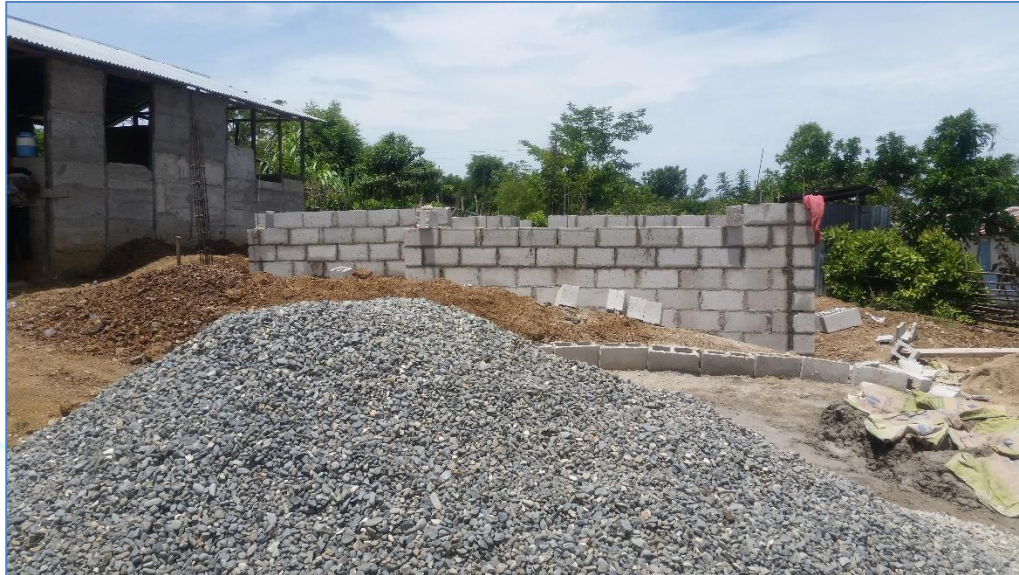
Colocación de muros bloques, casa del Sra. Amantina Rosario, Viviendas Económicas.
