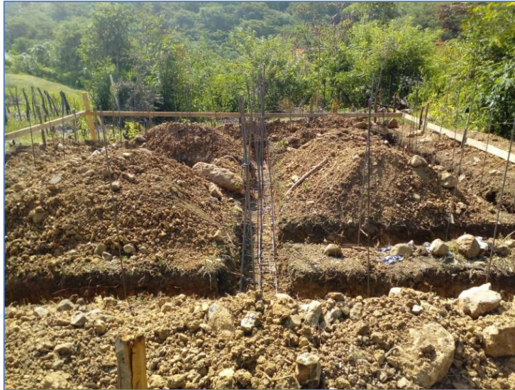
Colocación de acero en zapatas, casa del sr. Andric Lebrón, Viviendas Económicas.
