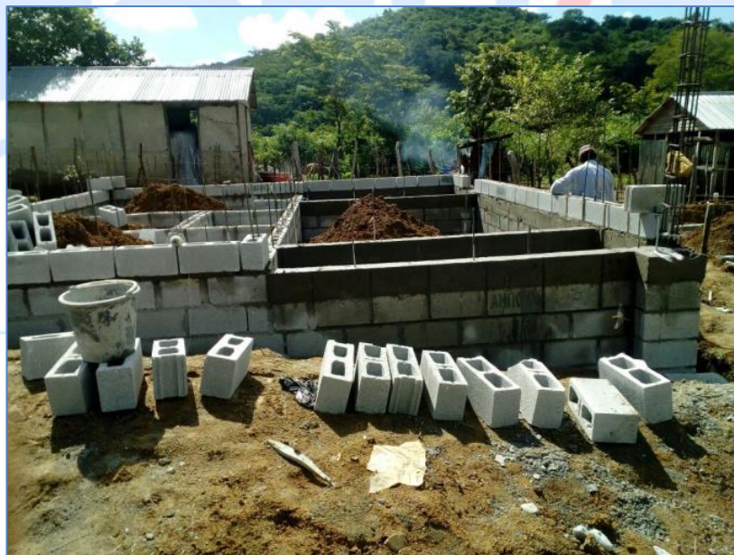
Colocación de bloques, casa del Sr. Milciades Ramírez, Viviendas Económicas.
