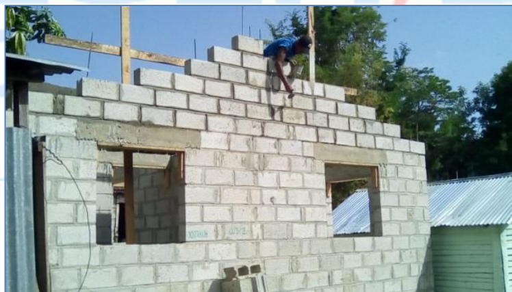
Colocación de bloques sobre dintel, casa del sr. Fausto Encarnación, Viviendas Económicas.
