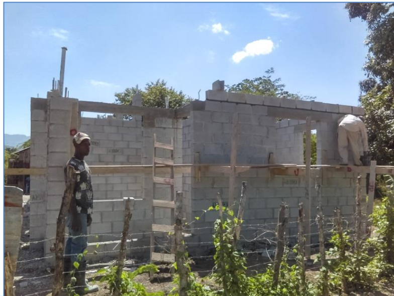
Vaciado de dinteles, casa del Sra. Heroína Ramírez, Viviendas Económicas.
