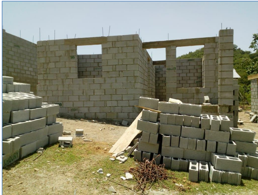
Colocación de bloques, casa de la Sra. Carmela Ramírez, Viviendas Económicas.
