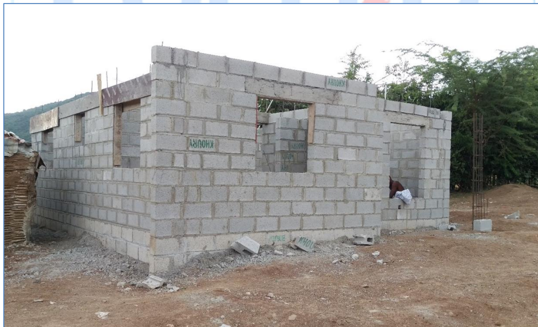
Colocación de bloques hasta nivel de techo, casa del Sra. Denia Valdez, Viviendas Económicas.
