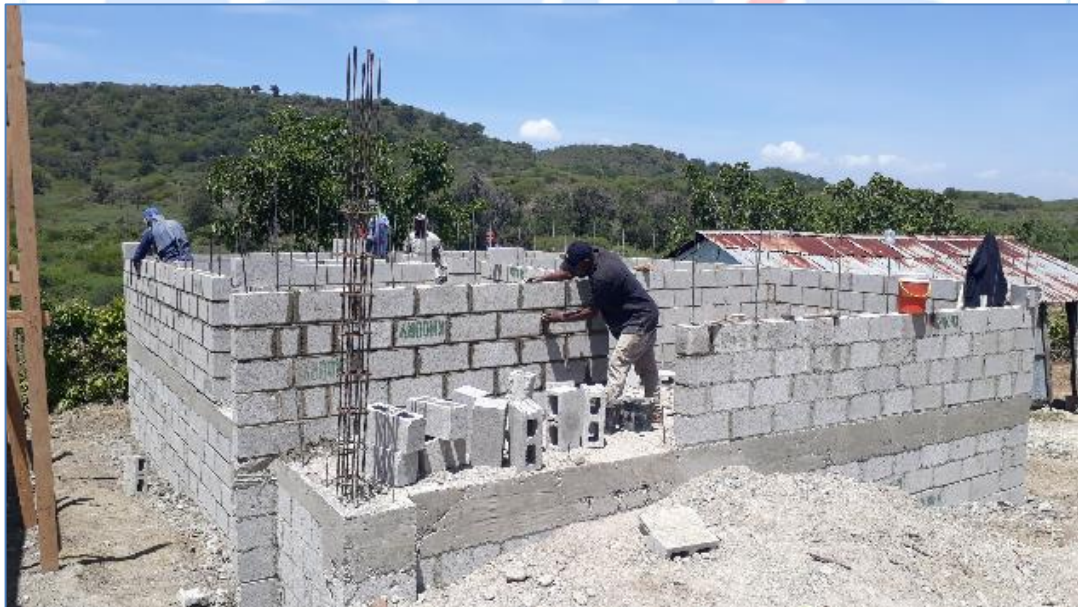
Colocación de bloques hasta nivel de ventanas, casa del Sra. Nereyda Suero, Viviendas Económicas.
