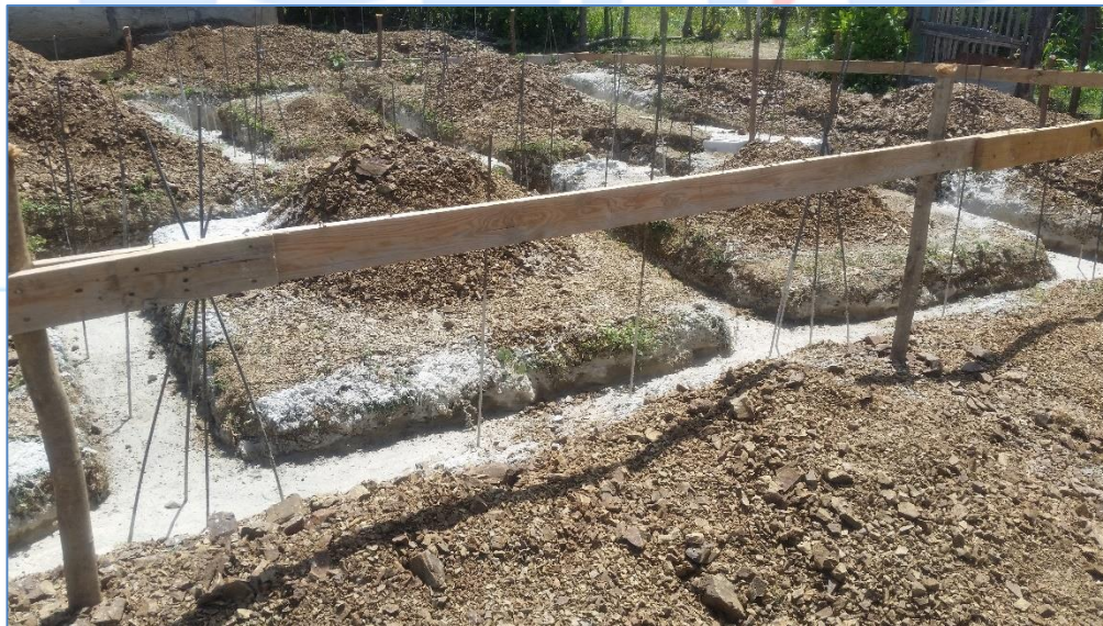
Vaciado de zapatas de muros y columnas, casa del Sra. Oliva Valdez, Viviendas.
