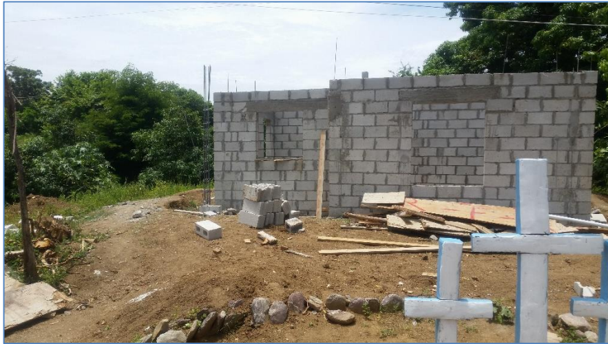
Colocación de bloques a nivel de techo, casa del Sr. Pablo Mateo, Viviendas Económicas.
