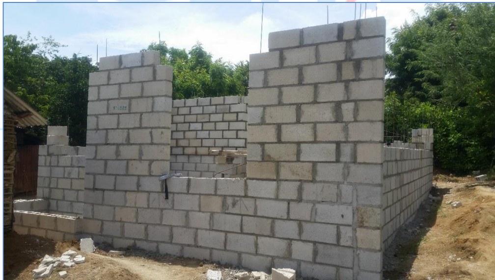
Colocación de muros de bloques, casa del Sra. Ricura Jiménez, Viviendas Económicas.
