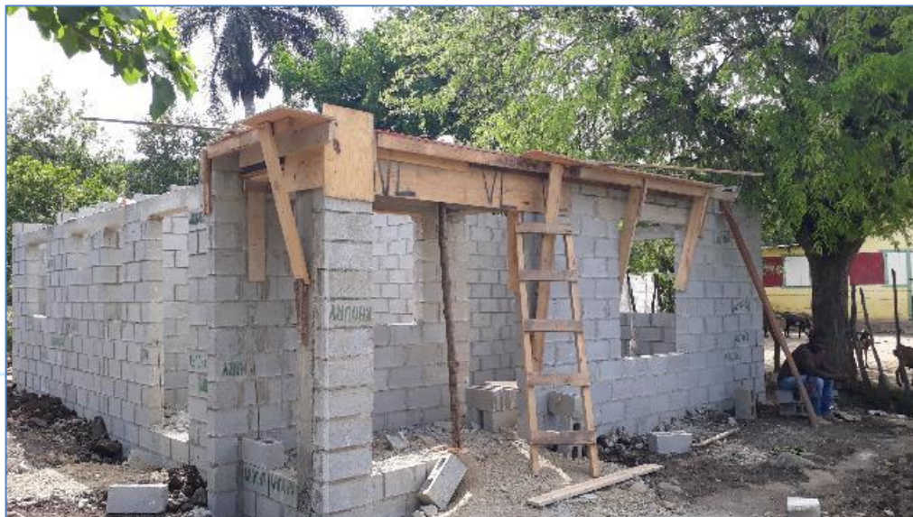
Encofrado de losa, casa del Sr. Pascual del Carmen, Viviendas Económicas.
