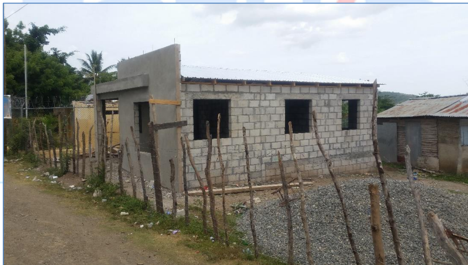
Techo de zinc acanalado colocado, casa del Sra. Dulce Valdez, Viviendas Económicas.
