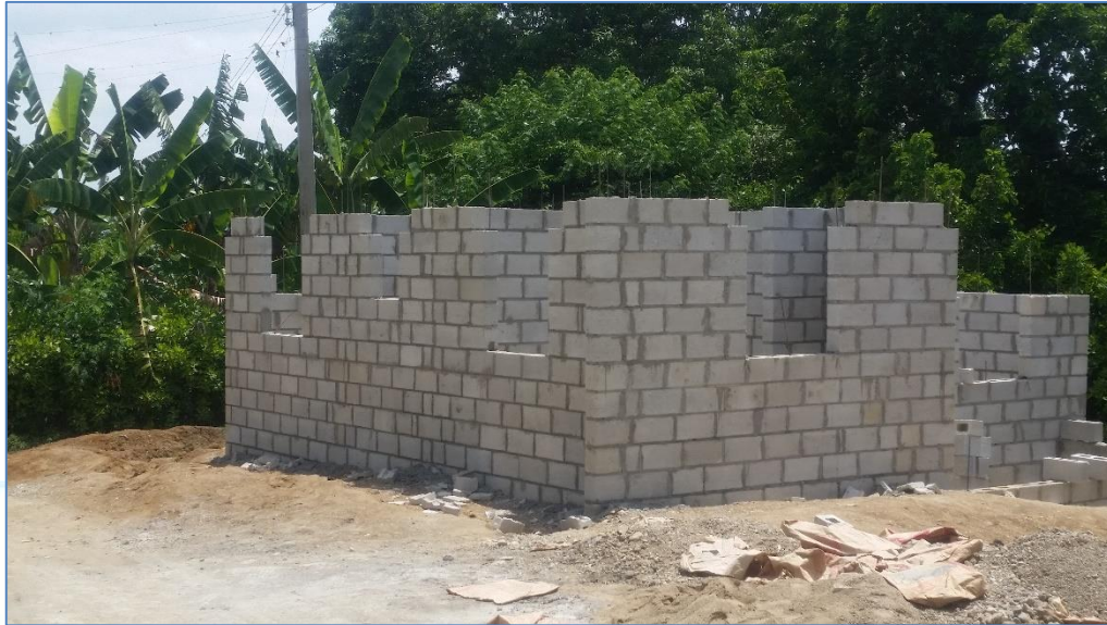
Colocación de muros de bloques, casa del Sr. Aristeo Jiménez, Viviendas Económicas.
