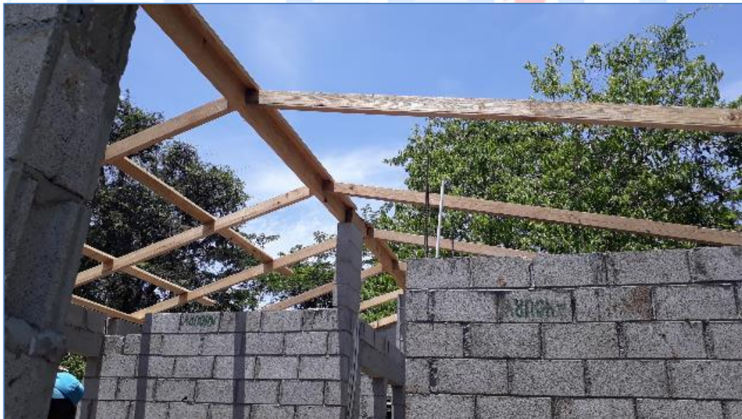
Estructura de madera para la colocación de techo, casa del Sr. José Cabral, Viviendas Económicas.
