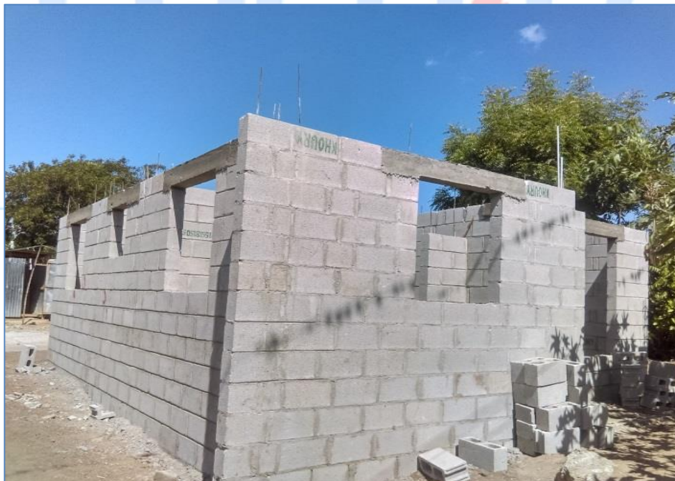
Vaciado de dinteles, casa de la Sra. Reyita Solís, Viviendas Económicas.
