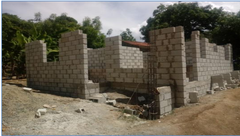
Colocación de bloques hasta nivel de dintel, casa del Sra. Mercedes Suero, Viviendas Económicas.
