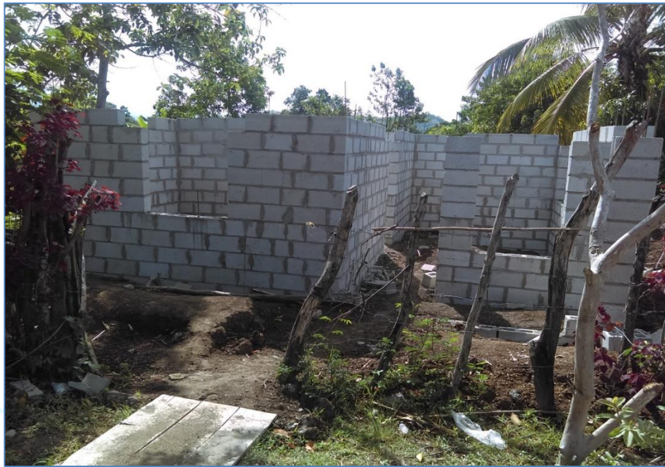
Colocación de bloques hasta nivel de dintel, casa del Sra. Martina Arno, Viviendas Económicas.
