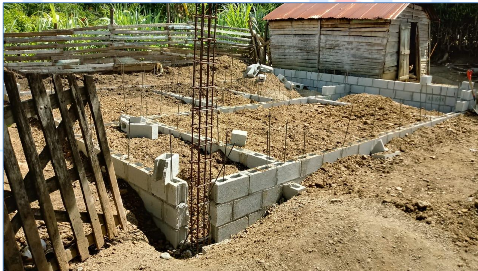
Colocación de bloques, casa del Sr. Adriano Jiménez, Viviendas Económicas.
