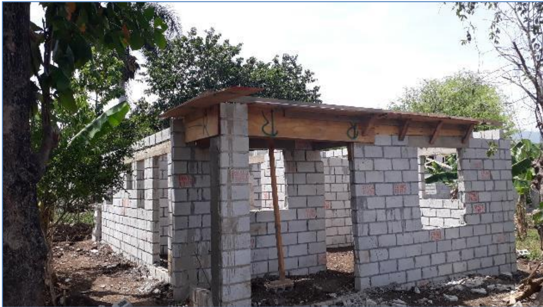
Hormigonado de losa, casa de la Sra. Catalina Arnaut, Viviendas Económicas.
