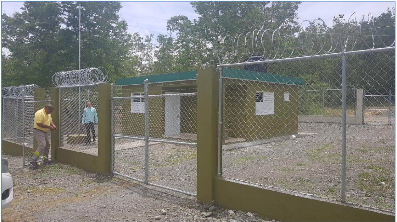
Verja perimetral y alambre de trinchera, Cuartel Militar Bao.
