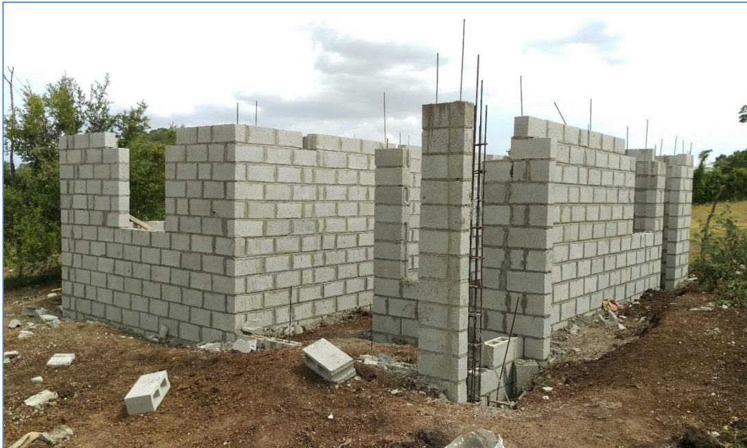
Colocación de bloques, casa de la Sra. Elvira Solís, Viviendas Económicas.
