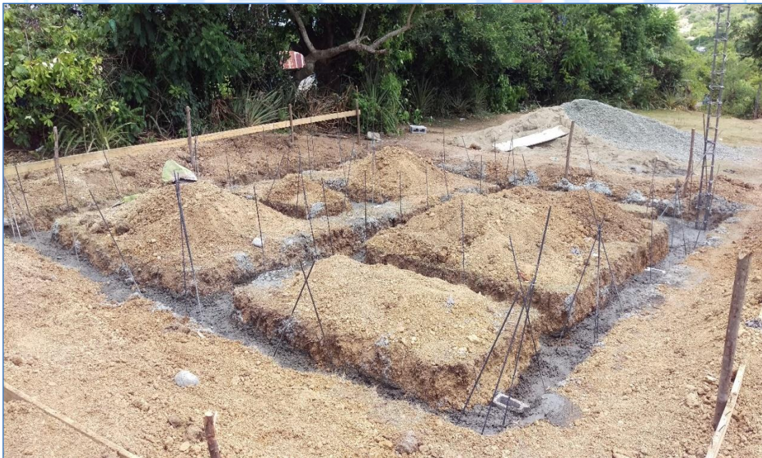
Vaciado de zapatas, casa del Sr. Arcenio Ramírez, Viviendas Económicas.
