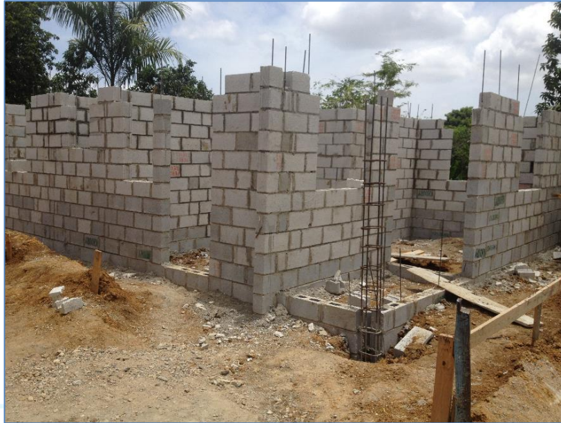
Colocación de bloques a nivel de dintel, casa de la Sra. Ana Rita Ramón, Viviendas Económicas.
