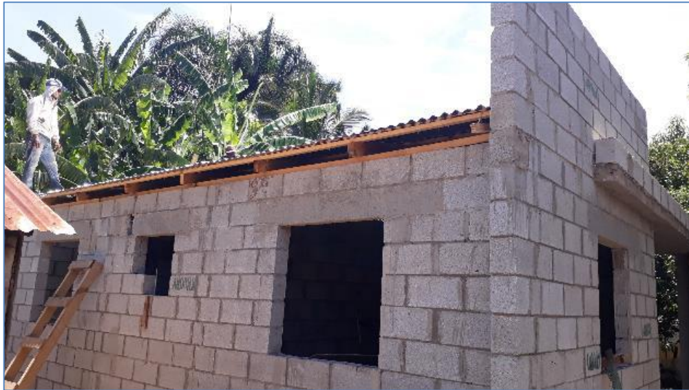
Colocación de zinc acanalado, casa del Sr. Reinaldo del Carmen, Viviendas Económicas.
