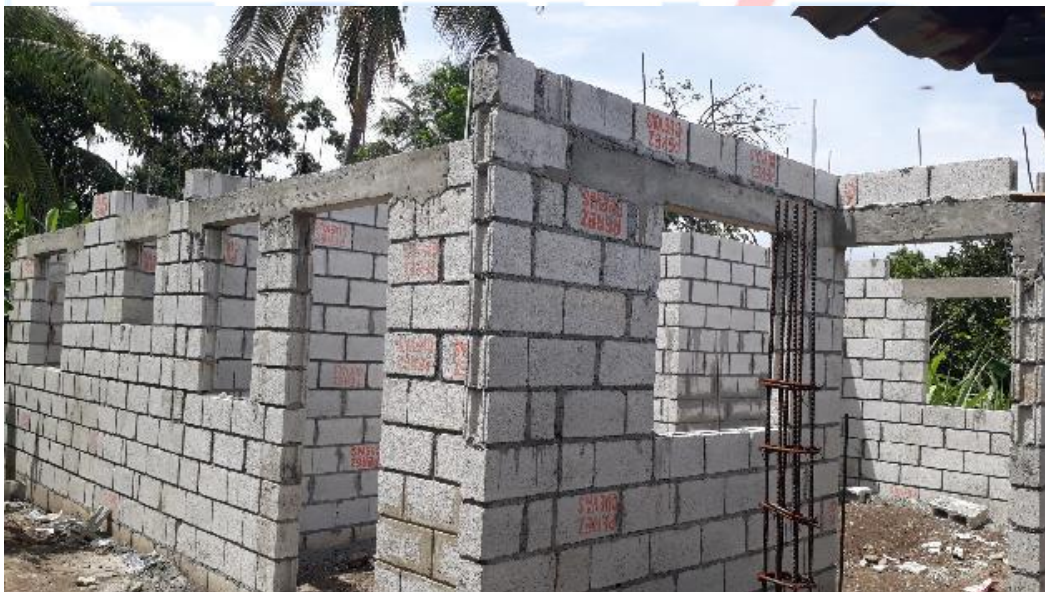
Hormigonado de dinteles, casa de la Sra. Aurora Suero, Viviendas Económicas.
