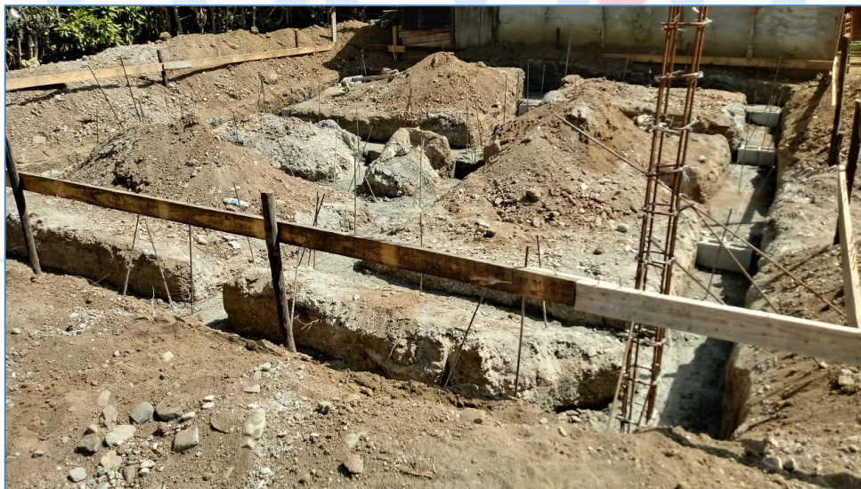
Vaciado de zapatas, casa de la Sra. Modestina Ramírez, Viviendas Económicas.
