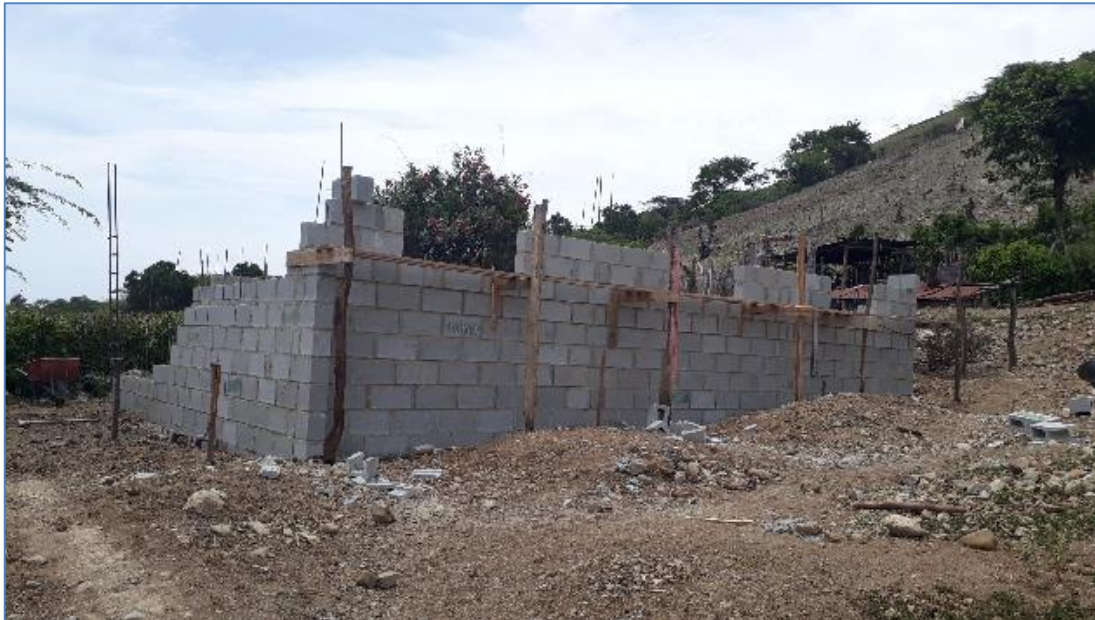
Colocación de bloques hasta nivel de ventanas, casa del Sra. Morena Suero, Viviendas Económicas.
