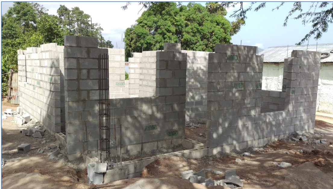
Colocación de bloques, casa del Sra. Martina Hernández, Viviendas Económicas.
