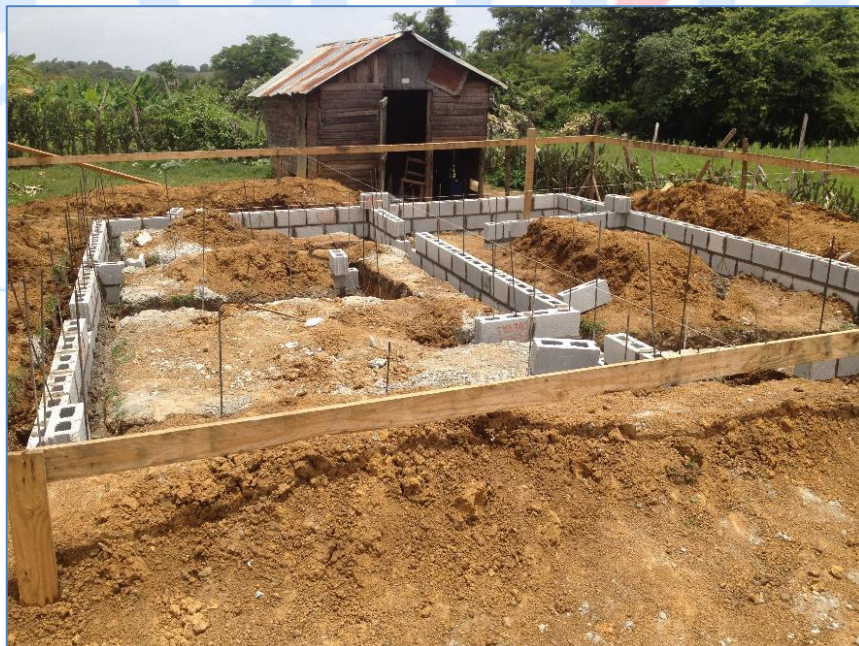
Colocación de bloques debajo de nivel de piso, casa del Sr. Daniel Ramírez, Viviendas Económicas.
