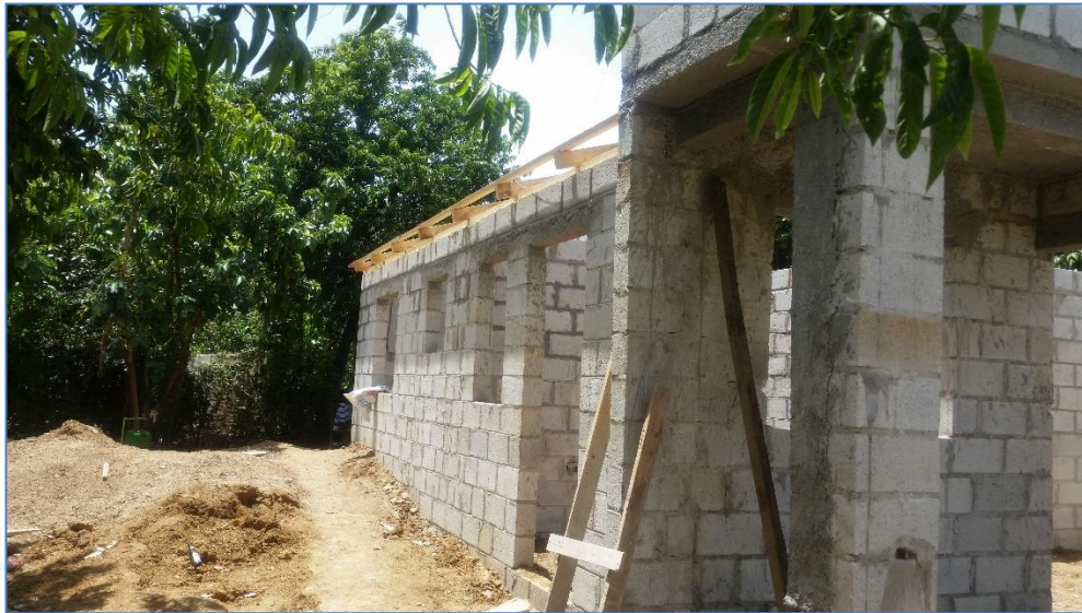
Colocación de estructura de madera para colocar el zinc, casa del Sra. Dulce de los Santos, Viviendas Económicas.
