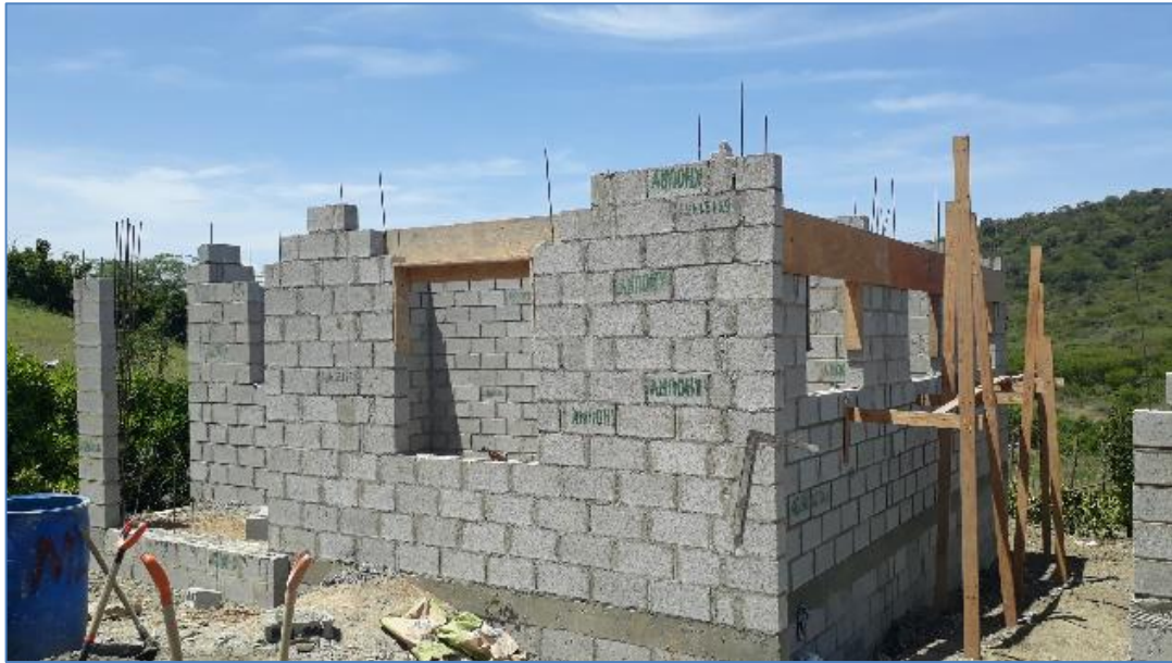
Encofrado de dinteles, casa del Sr. Limardo Suero, Viviendas Económicas.
