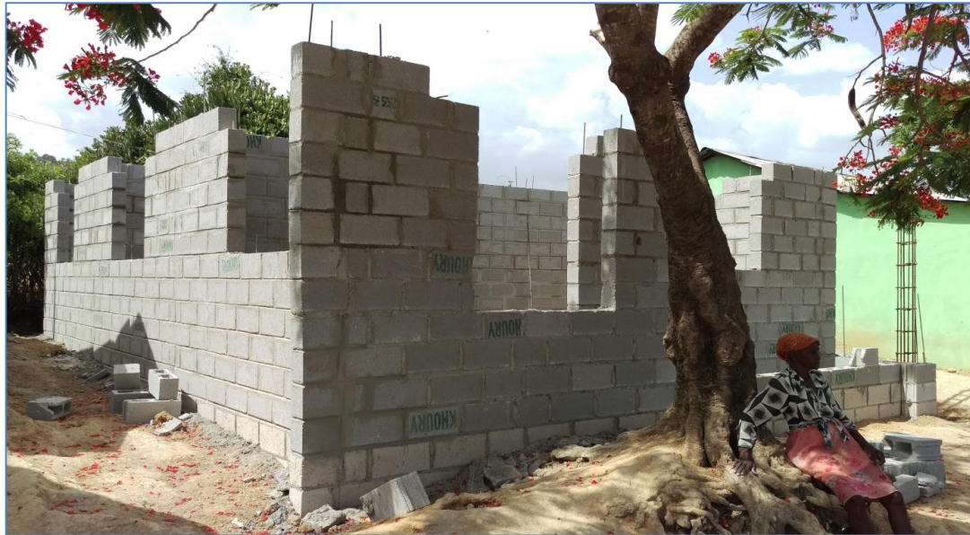
Colocación de bloques hasta nivel de dintel, casa del Sr. Heriberto Jiménez, Viviendas Económicas.
