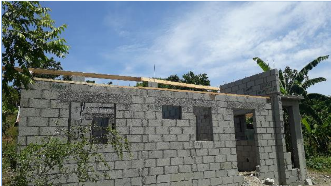
Estructura de madera para colocación de techo, casa del Sra. Dilia Ramírez, Viviendas Económicas.
