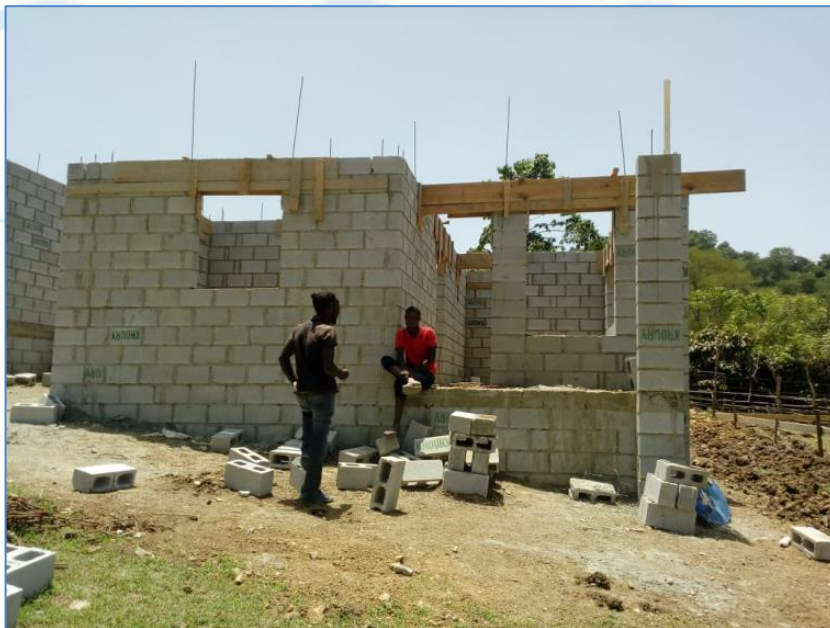
Colocación de bloques, casa del Sr. Ramón Ramírez, Viviendas Económicas.
