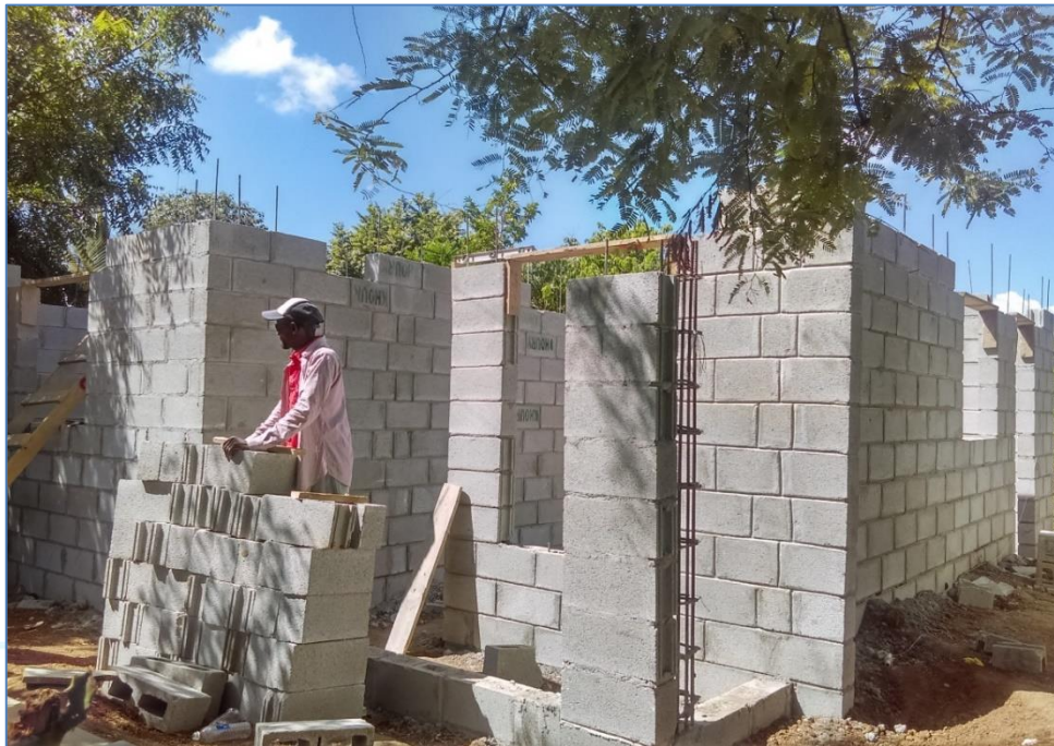
Encofrado de dinteles, casa del Sr. Maximiliano Jiménez, Viviendas Económicas.
