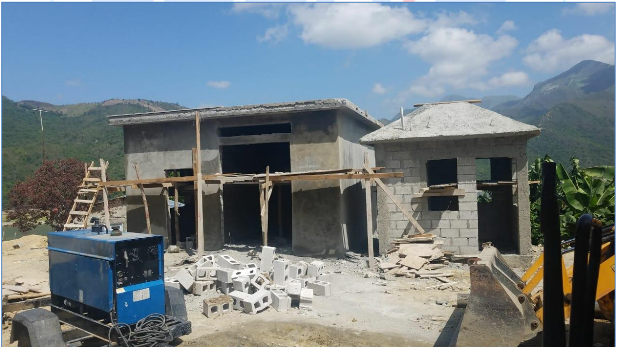
Construcción de la garita, Acueducto Sabaneta.
