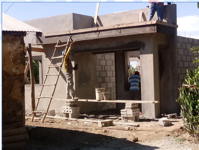
Pañete de fachada, casa del sr. Miguel Arno, Viviendas Económicas.
