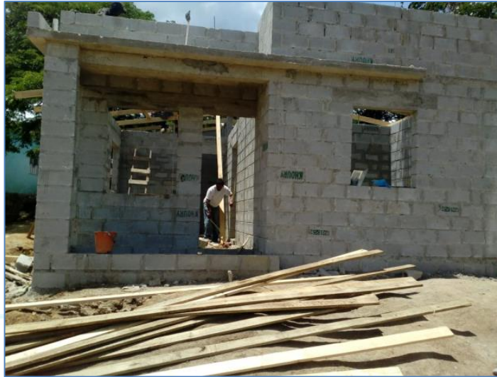
Colocación de bloques en antepecho, casa del sr. Andrés del Carmen, Viviendas Económicas.
