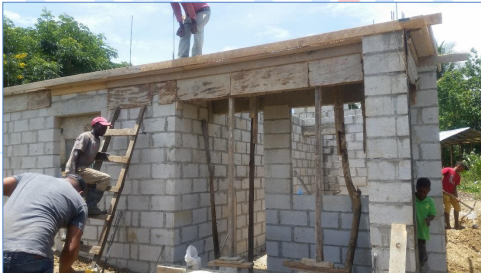
Encofrado de losa de techo, casa del Sr. Marcio Ramírez, Viviendas Económicas.
