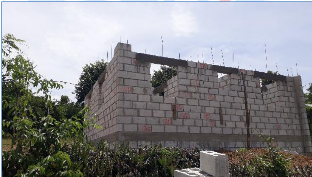
Hormigonado de dinteles, casa del Sr. Juan Alcántara, Viviendas Económicas.
