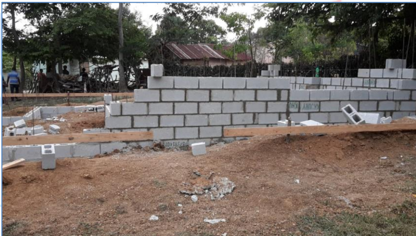
Colocación de bloques, casa del Sra. Guillermina de los Santos, Viviendas Económicas.
