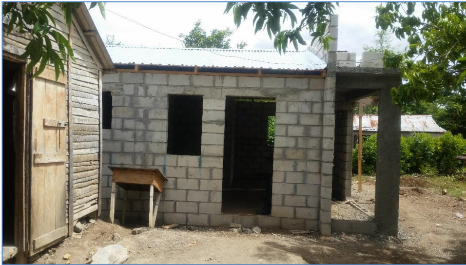
Techo de zinc acanalado colocado, casa del Sra. Clara Ramírez, Viviendas Económicas.
