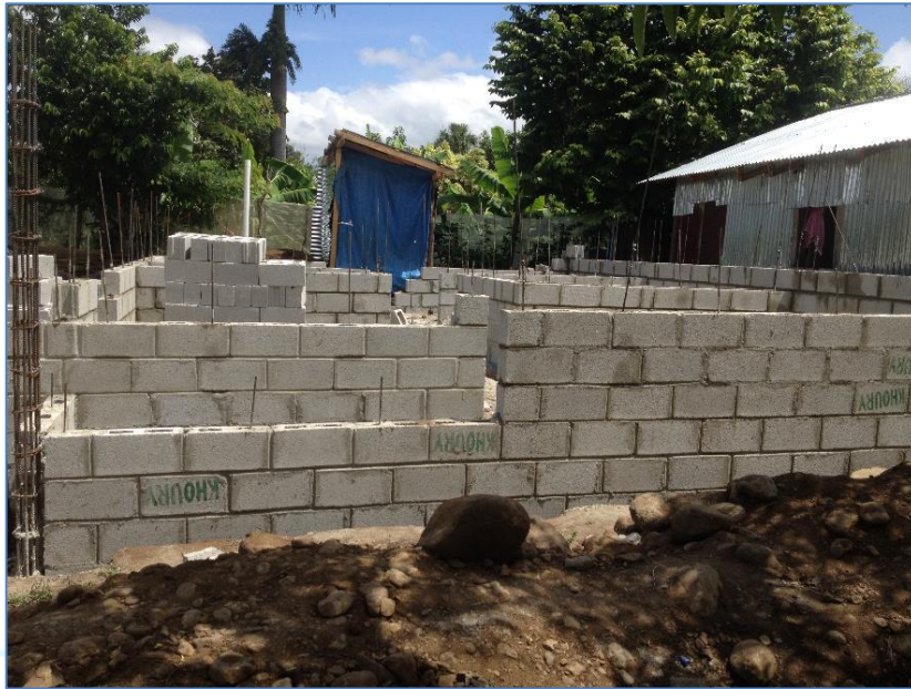
Colocación de bloques a nivel de ventanas, casa de la Sra. Lorentza Langomás, Viviendas Económicas.
