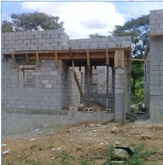
Encofrado de losa de techo, casa de la Sra. Modestina Ramírez, Viviendas Económicas.
