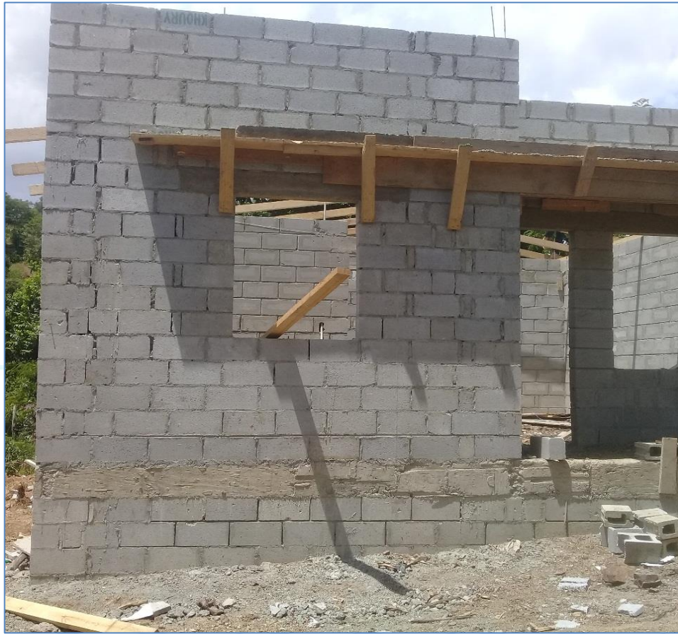
Encofrado de losa de techo, casa del Sr. Rafael Ramírez, Viviendas Económicas.
