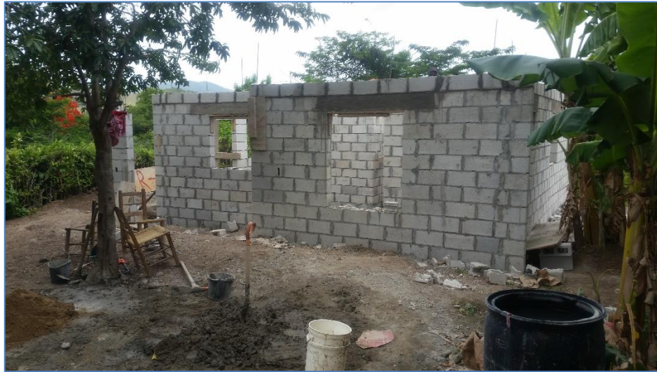
Colocación de bloques hasta nivel de techo, casa del Sr. Fernando Arno, Viviendas Económicas.
