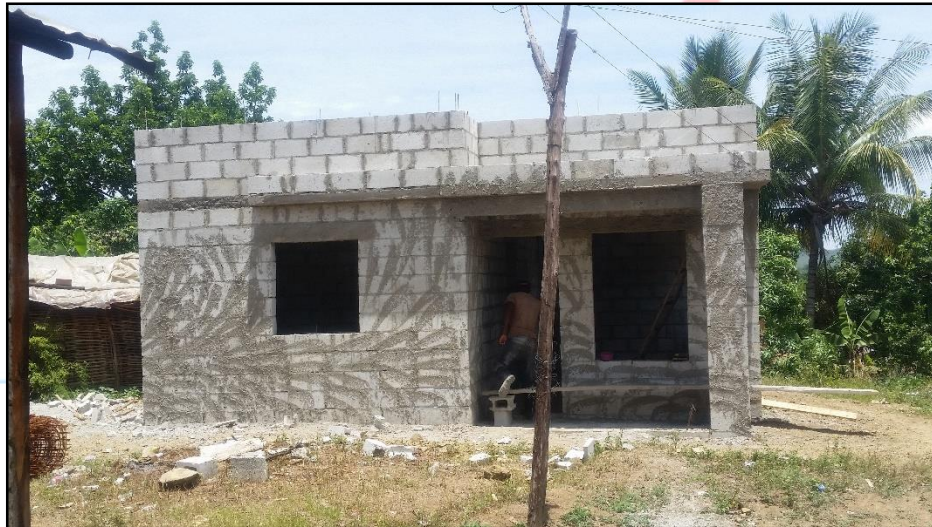
Bloques de antepecho colocados, casa del Sr. Ramón Arno, Viviendas Económicas.
