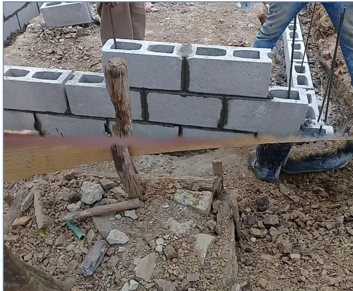
Colocación de bloques, casa del Sr. Anulfo Valdez, Viviendas Económicas.
