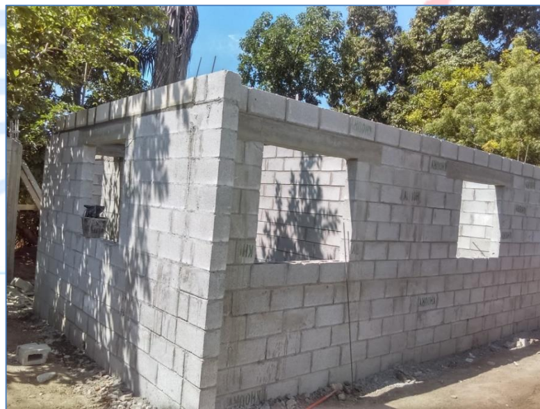
Vaciado de dinteles, casa del Sra. Yolanda Ramírez, Viviendas Económicas.
