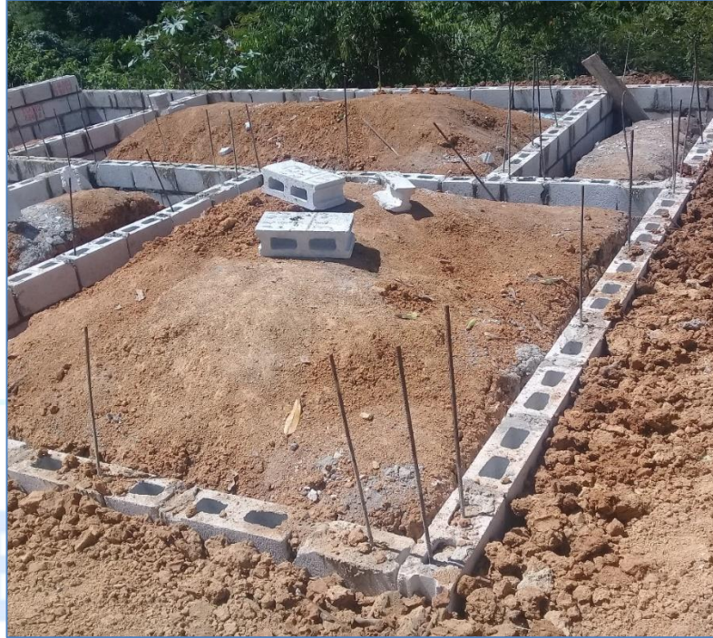
Colocación de bloques bajo nivel de piso, casa del Sr. Freddy Ramírez, Viviendas Económicas.
