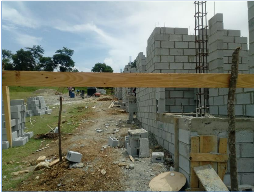
Colocación de bloques, casa de la Sra. Susana Ramírez, Viviendas Económicas.
