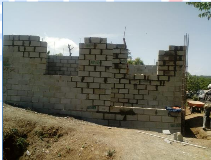
Colocación de bloques a nivel de dintel, casa de la sra. Julissa Suero, Viviendas Económicas.
