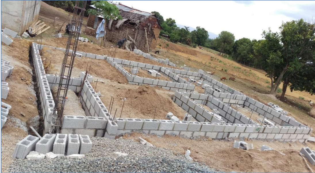
Colocación de bloques bajo nivel de piso, casa del Sr. Gustavo Perdomo, Viviendas Económicas.
