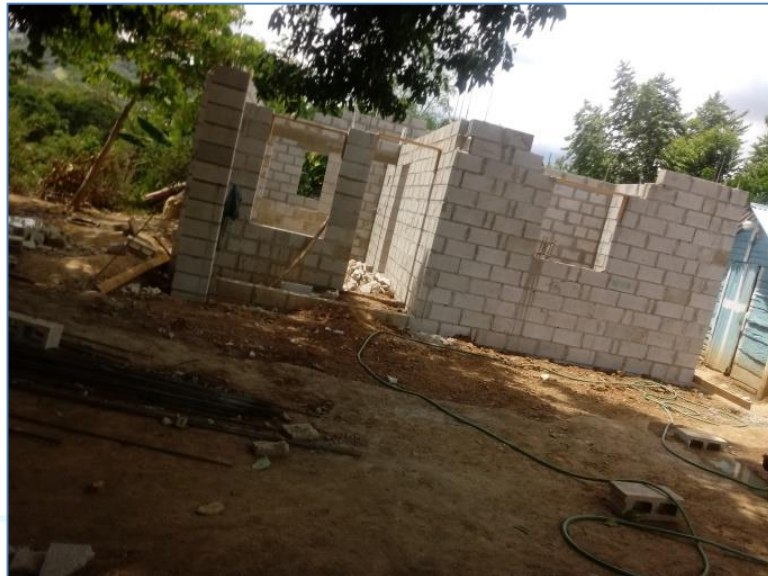
Colocación de bloques hasta nivel de dintel, casa del sr. Aquilino Arno, Viviendas Económicas.
