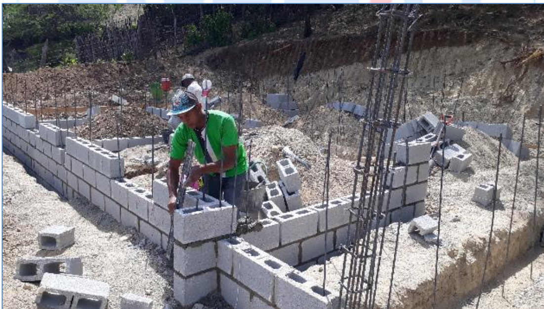
Colocación de bloques, casa del Sr. Elis Arno, Viviendas Económicas.
