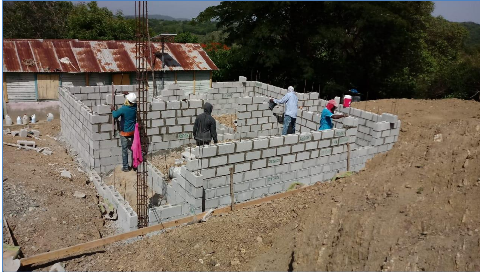
Colocación de bloques, casa del Sr. Wilkin Jiménez, Viviendas Económicas.
