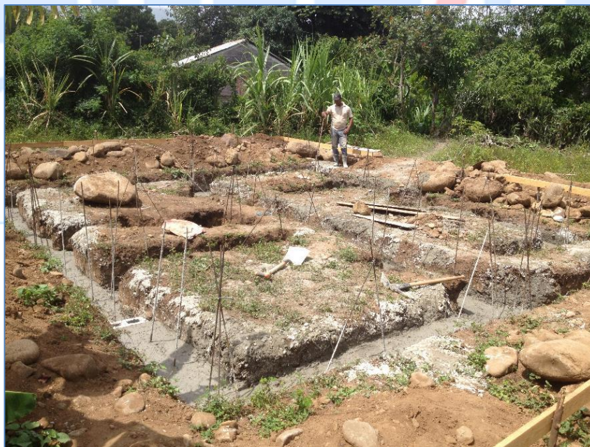
Vaciado de zapatas, casa de la Sra. Cruz Suero, Viviendas Económicas.
