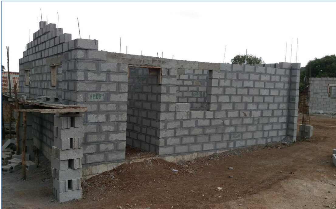
Colocación de bloques en antepecho, casa del Sr. José Jiménez, Viviendas Económicas.
