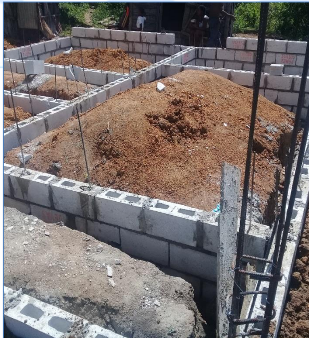
Colocación de bloques bajo nivel de pisos, casa del Sr. Percido Ramírez, Viviendas Económicas.
