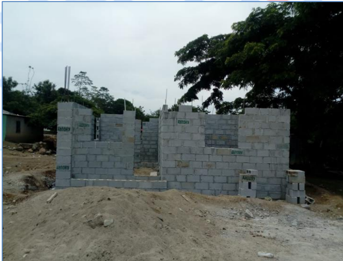
Colocación de bloques a nivel de dintel, casa del sr. Eduardo de la cruz Beltré, Viviendas Económicas.
