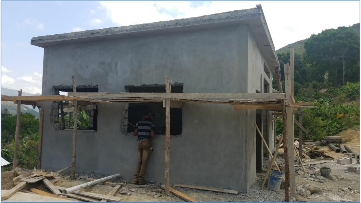
Construcción de casa de máquinas del generador, Acueducto Sabaneta.
