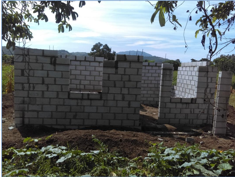
Colocación de muros de bloques hasta nivel de dintel, casa del Sr. Merido Mateo, Viviendas Económicas.
