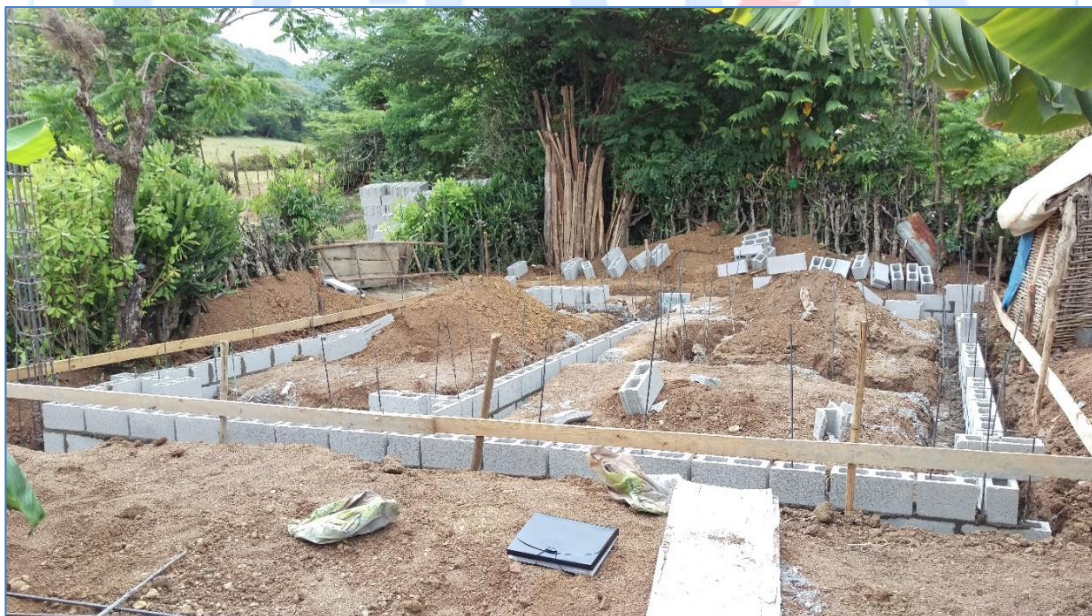
Colocación de bloques, casa del Sr. Eridanio Ramírez, Viviendas Económicas.
