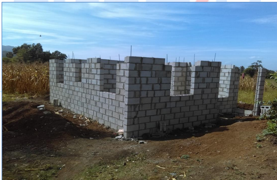
Colocación de muros de bloques hasta nivel de dintel, casa del Sra. Marcia Mateo, Viviendas Económicas.
