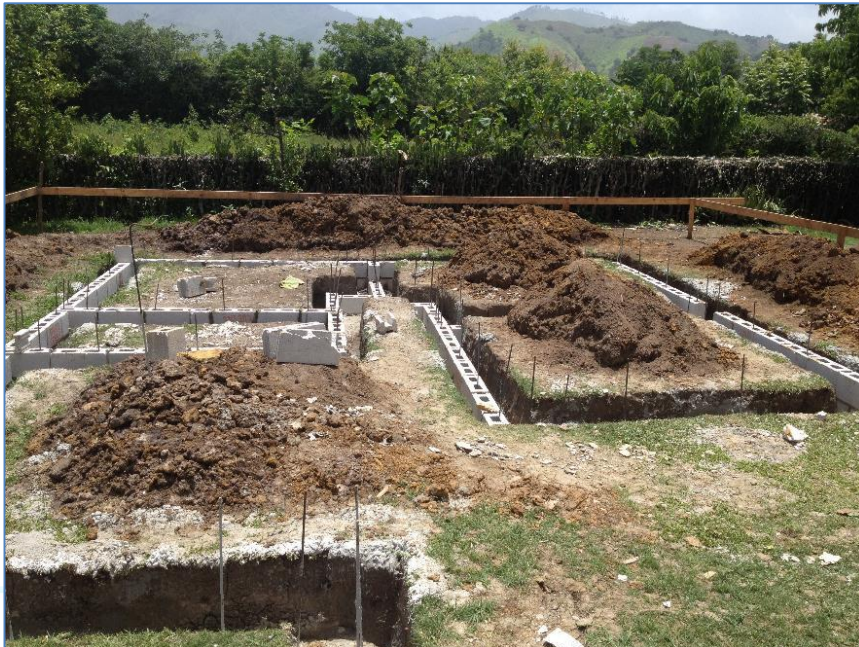
Colocación de bloques debajo de nivel de piso, casa de la Sra. Daysi Suero, Viviendas Económicas.
