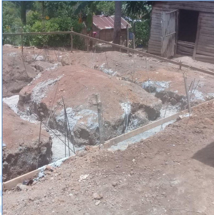
Vaciado de zapatas, casa del Sr. Manuel Ramírez, Viviendas Económicas.
