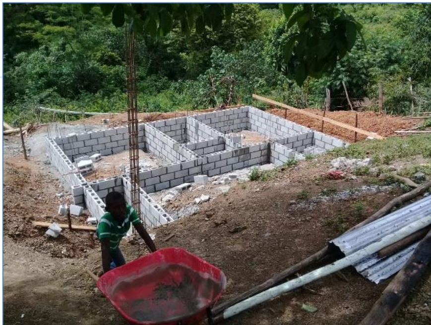
Colocación de bloques, casa de la Sra. Luz María de la Cruz, Viviendas Económicas.
