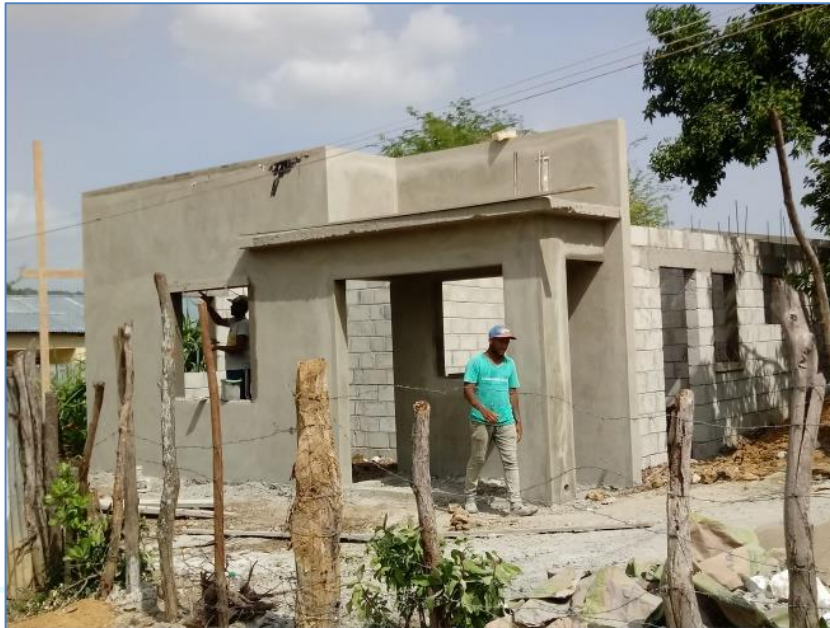
Pañete de muros y columnas, casa del sr. Adilanio Jiménez, Viviendas Económicas.
