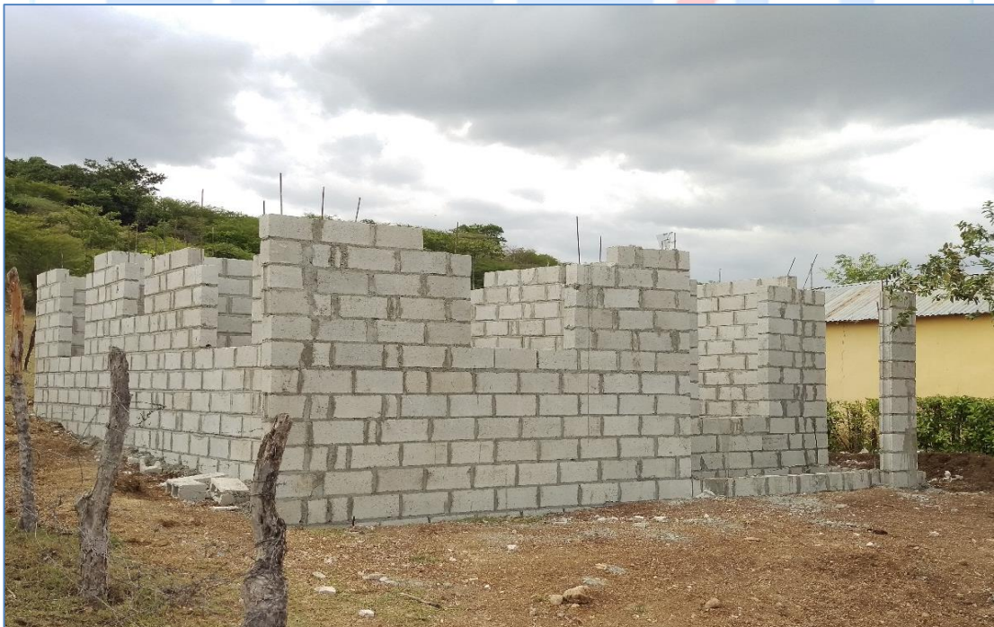
Colocación de bloques, casa del Sr. Cesar Durán, Viviendas Económicas.
