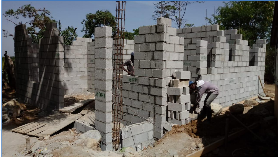
Colocación de bloques, casa del Sra. Vírgenes Suero, Viviendas Económicas.
