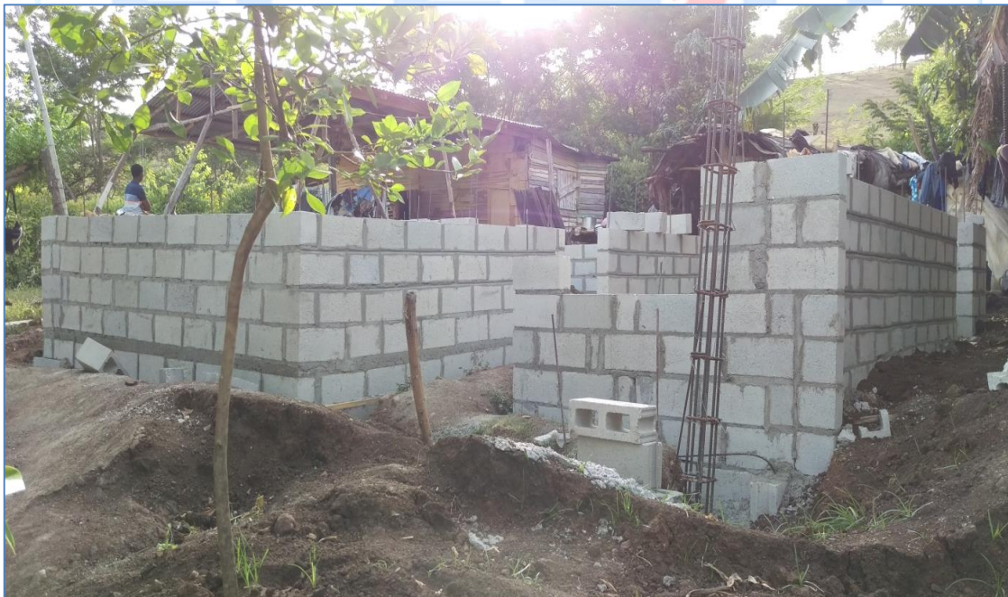
Colocación de bloques, casa del Sr. Manuel Durán, Viviendas Económicas.
