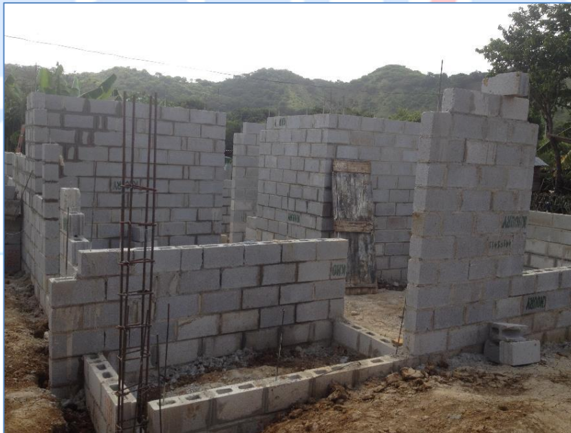
Colocación de bloques a nivel de ventana y dintel, casa del Sr. Tulio Jiménez, Viviendas Económicas.
