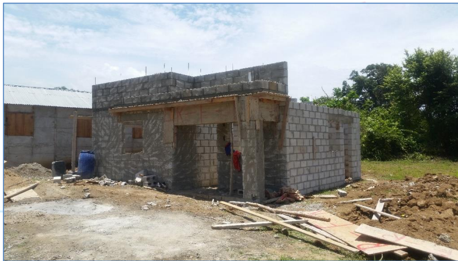
Bloques de antepecho colocados, casa del Sr. Pichardo Mateo, Viviendas Económicas.
