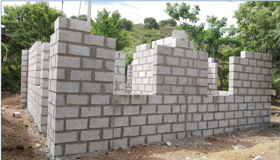
Bloques hasta nivel de dintel, casa del Sr. Manuel Genao, Viviendas Económicas.
