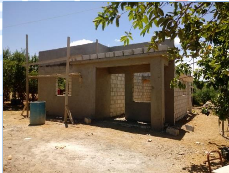
Pañete de fachada, casa del Sr. Narciso Suero de los santos, Viviendas Económicas.
