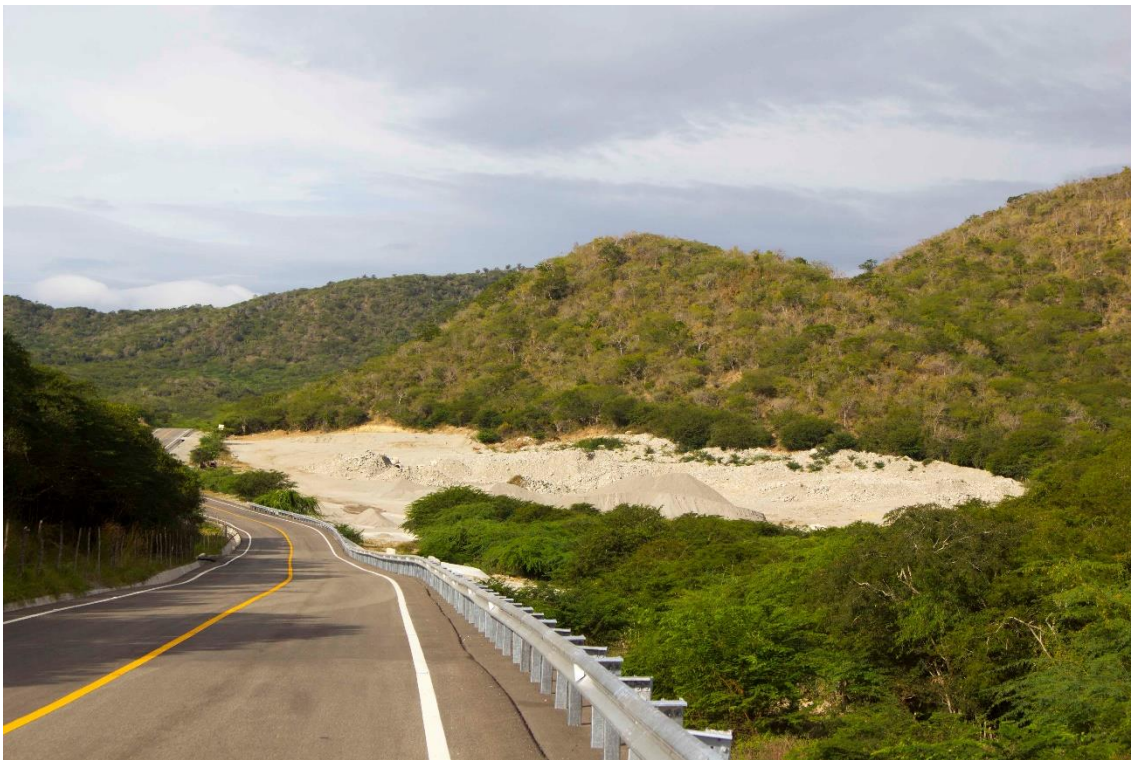
AREA DE ACOPIO CAMINO A BOHECHIO DESDE PADRE LAS CASAS.
