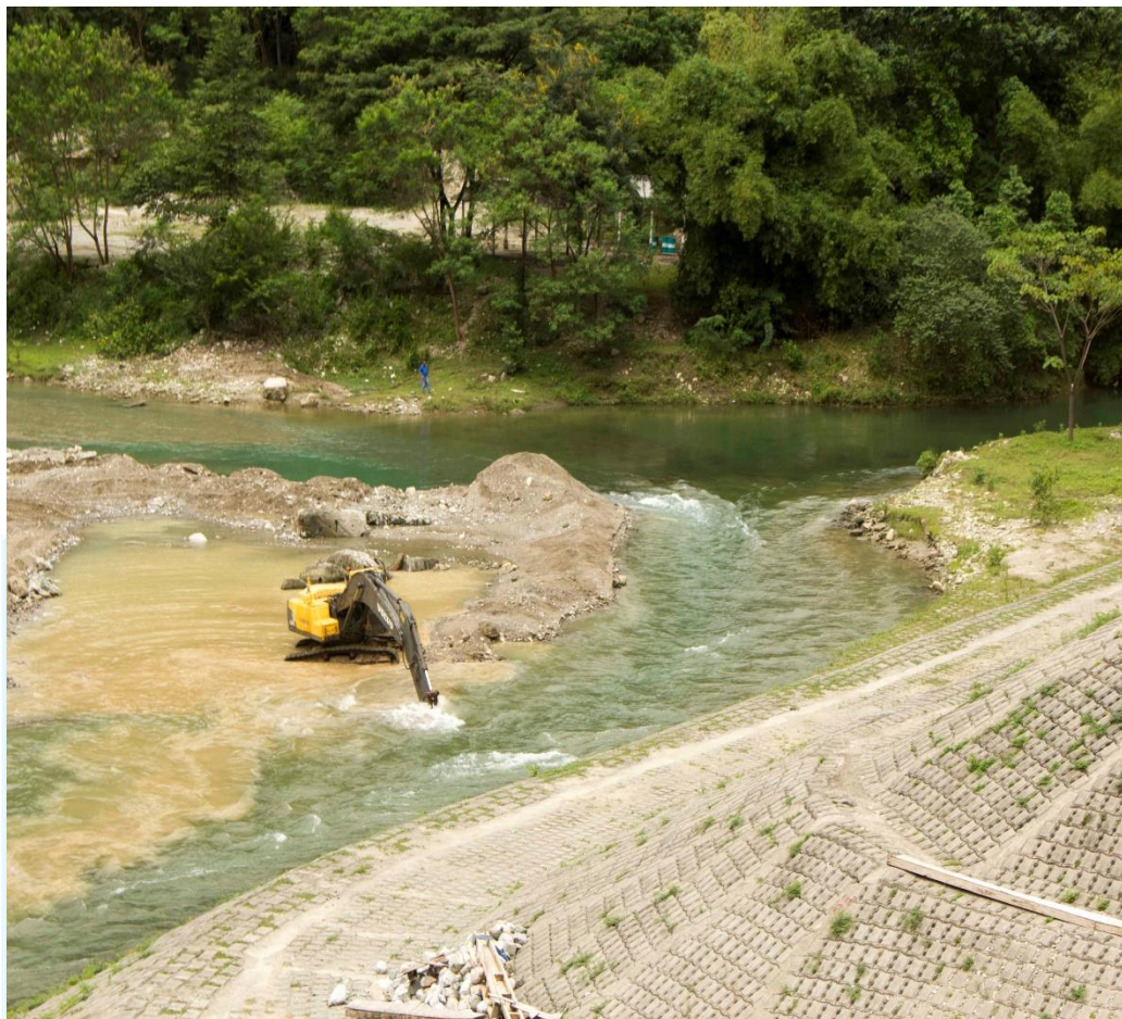
AGUACATE: Inicio de los trabajos de encauzamiento del río Nizao.
