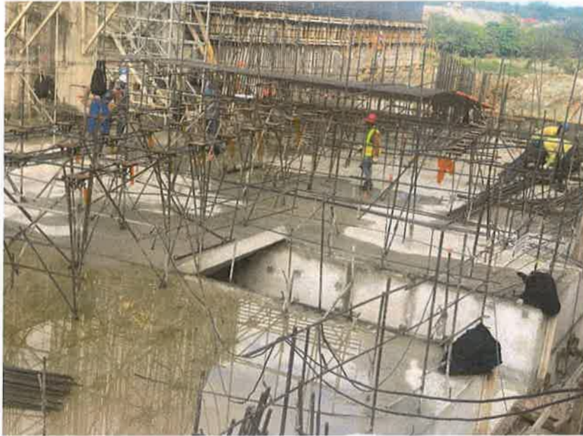
DESAGÜE DE FONDO. COLOCACIÓN PLACA ANCLAJES 200 MM X 3/3"
