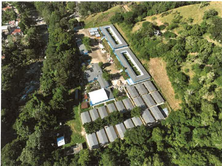
Rehabilitación Campamento el Higuero
