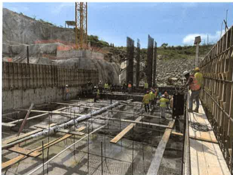
Bloque 6. Colocación acero de refuerzo en pila central galería de desvío, tramo desde la GD hacia aguas arriba
