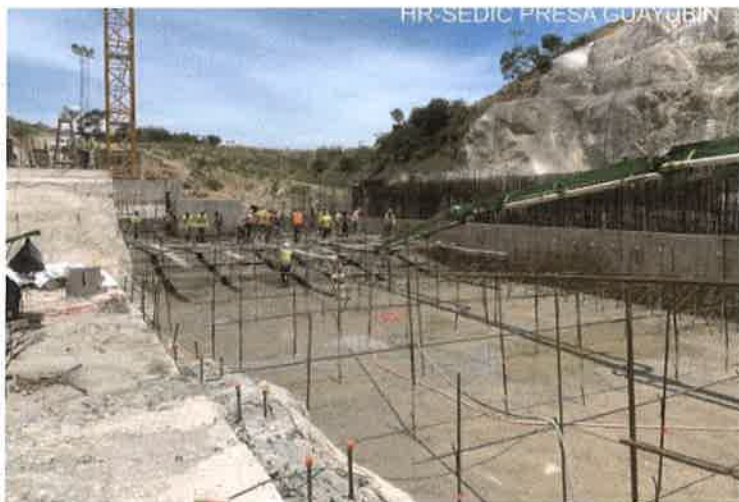
Bloque 7. Operaciones de hormigonado entre las elevaciones 62.00 y 63.00 m.s.n.m.
