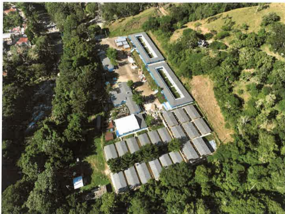
Rehabilitación Campamento el Higuero
