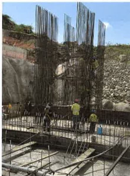
Bloque 6. Colocación acero de refuerzo en pila central galería de desvío, tramo desde la GD hacia aguas arriba
