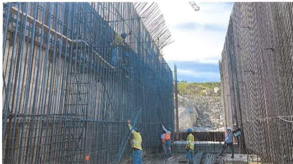
Bloque 6 (Desvío). Disposición armadura en pilas laterales
