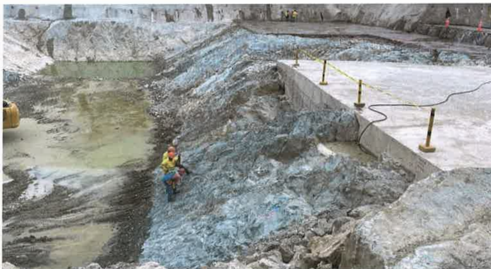
Vista de la roca de cimentación del Cuenco y la Losa de Protección situada entre cuerpo Presa y el Cuenco
