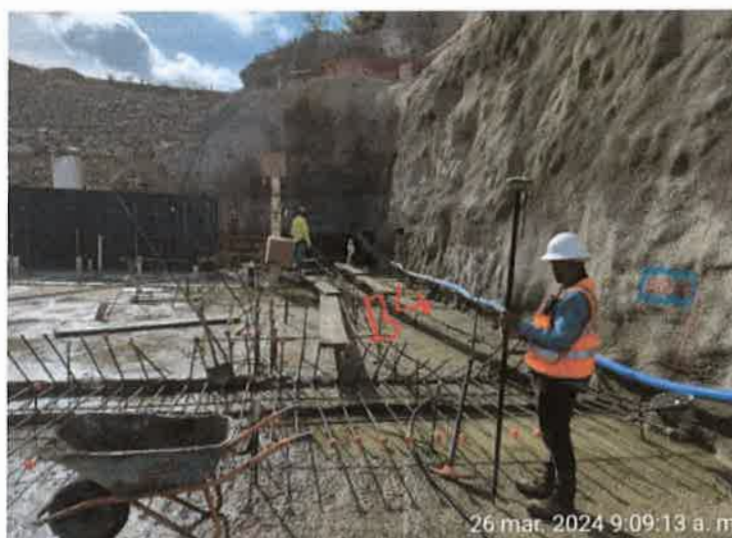
Vista hormigonado bloque 4 a elevación 55.44 m.s.n.m.
