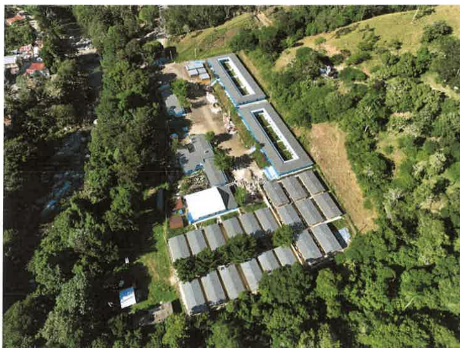
Rehabilitación Campamento el Higuero
