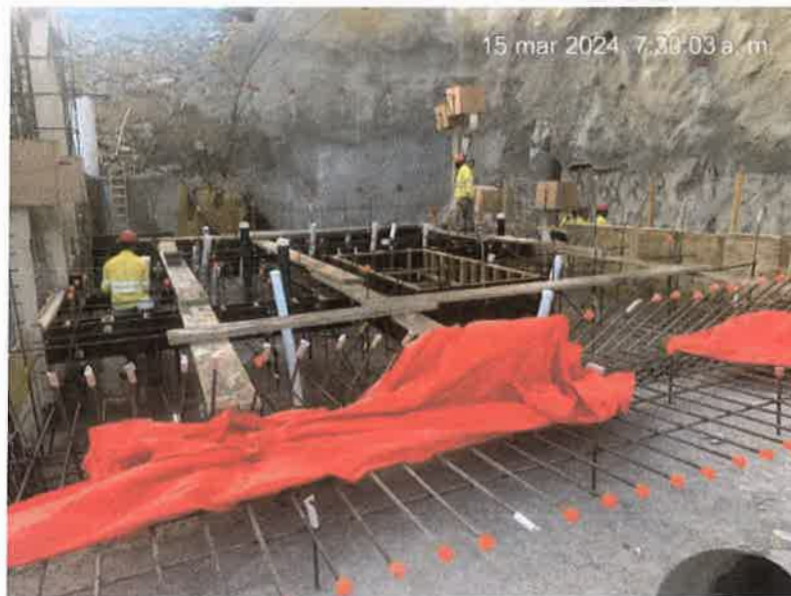
Bloque5. Camada 4 en condiciones de hormigonar entre las elevaciones 54.50 y 55.44 m.s.n.m.
