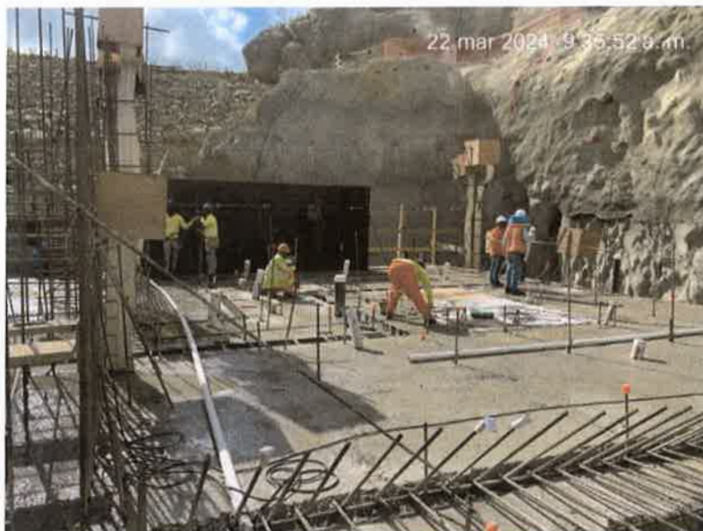
Actividad de encofrado sobre elevación 55.44 m.s.n.m., en paramento aguas arriba del bloque 5
