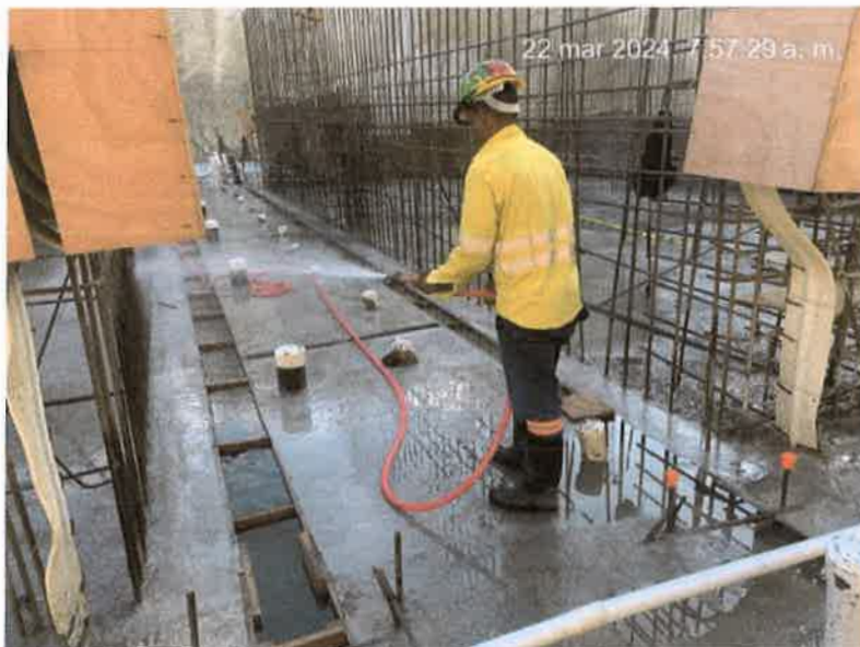
Vista piso Galería de Drenaje en elevación 55.44 m.s.n.m.
