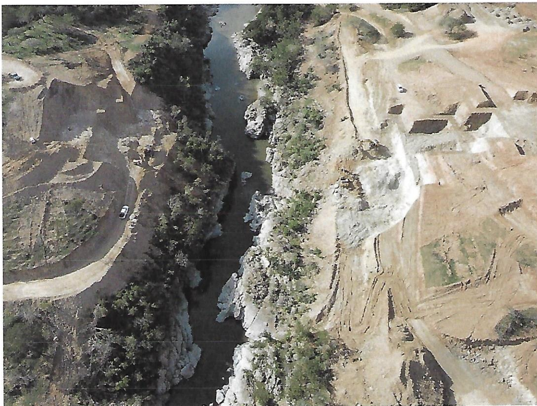
PRESA BOCAS DE LOS RÍOS (PRESA RÍO GUAYUBÍN).
