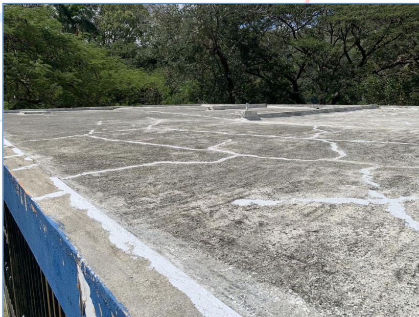
Reparación de fino de casas del campamento, Solución drenaje Sanitario campamento Valdesia.
