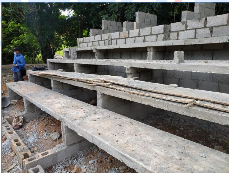
Construcción de graderías, Reparación Cancha Club la Salvia-Los Quemados.
