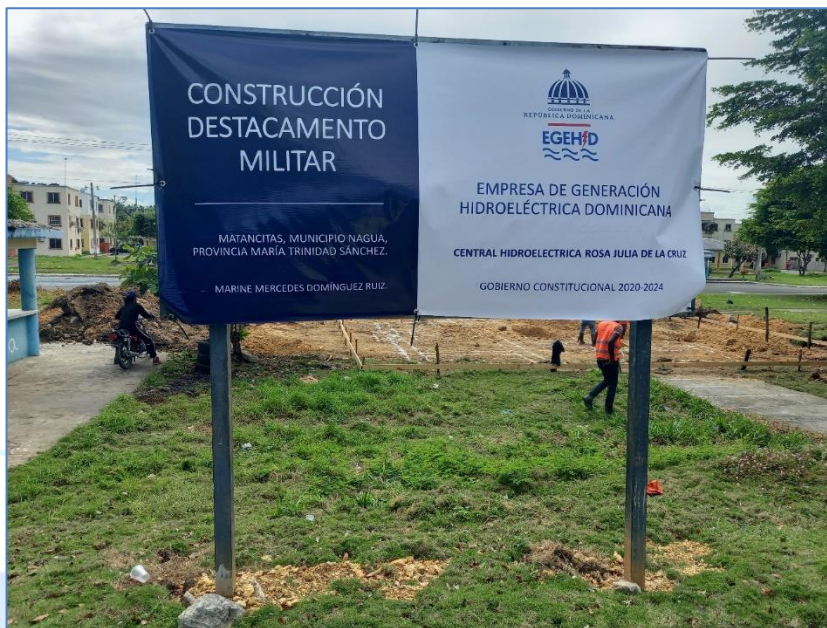
Letrero de obra, Destacamento Militar Matancitas.
