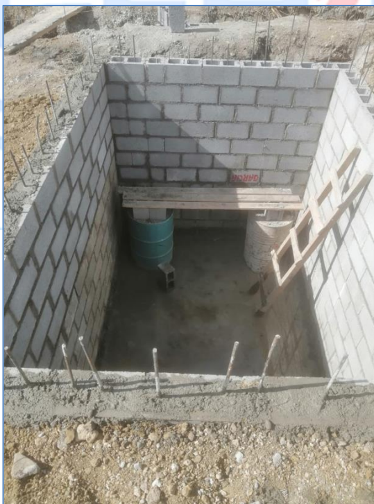
Colocación de bloques en cisterna, Funeraria Najayo Arriba.
