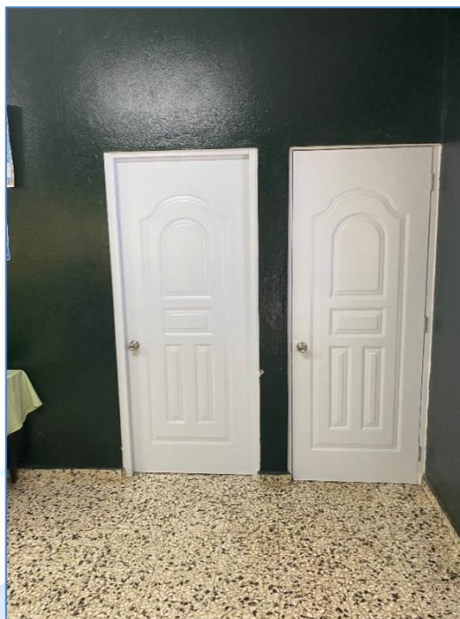
Puertas del destacamento instaladas, Central Hidroeléctrica Jimenoa.
