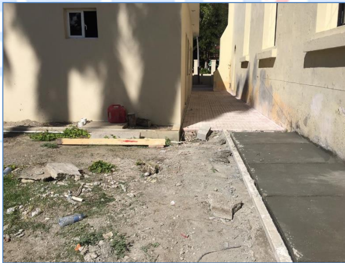
Construcción de acera, Iglesia Santa Lucía.
