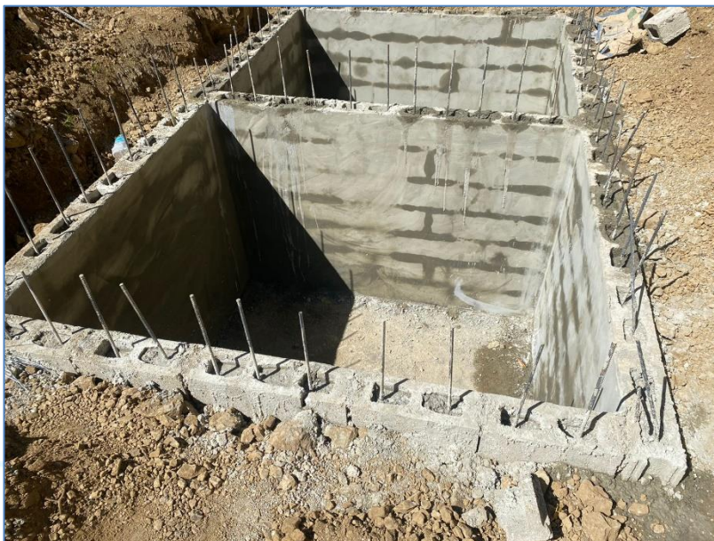
Colocación de bloques en cámara séptica, Terminación capilla de Fátima.
