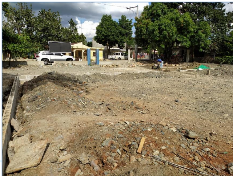
Movimiento de tierra en área de juego, Reparación Cancha Club la Salvia-Los Quemados.
