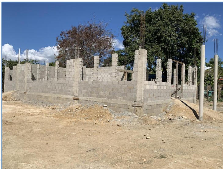
Colocación de bloques a nivel de dintel, Funeraria Laguna Salada.
