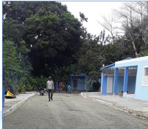
Imprimación calles internas campamento, Central Hidroeléctrica Jimenoa.
