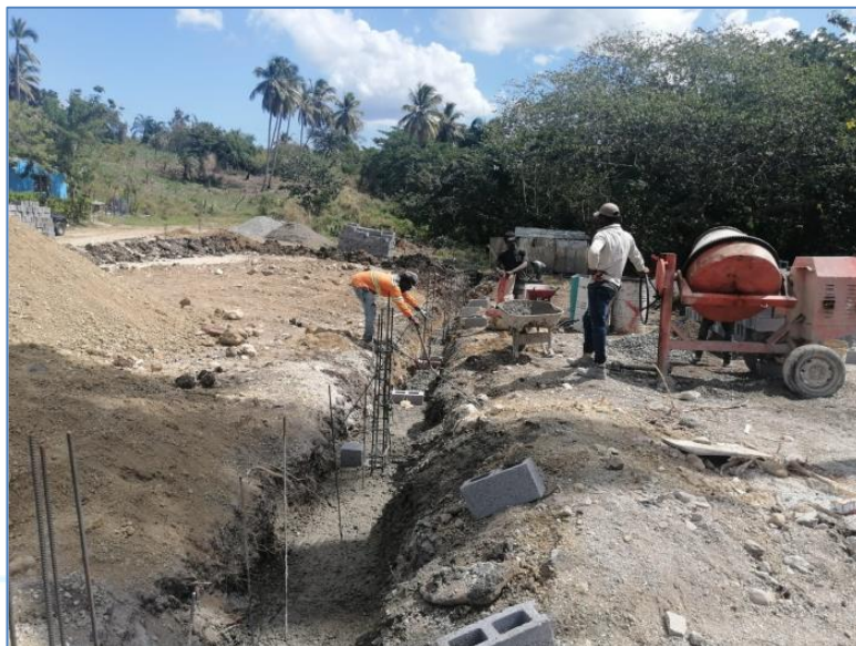
Vaciado de zapata de cisterna, Funeraria Najayo Arriba.
