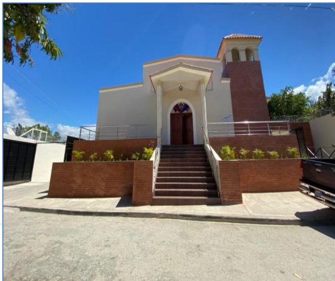
Fachada, Iglesia Perpetuo Socorro.
