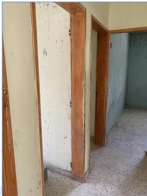
Desmonte de puertas casas del campamento, Solución drenaje Sanitario campamento Valdesia.
