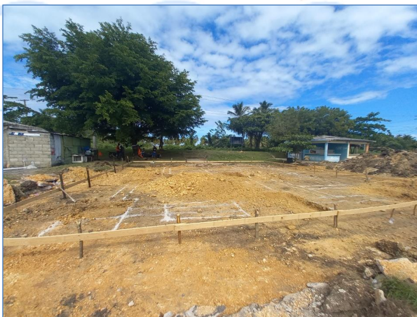
Charranca y replanteo de cimientos, Destacamento Militar Matancitas.
