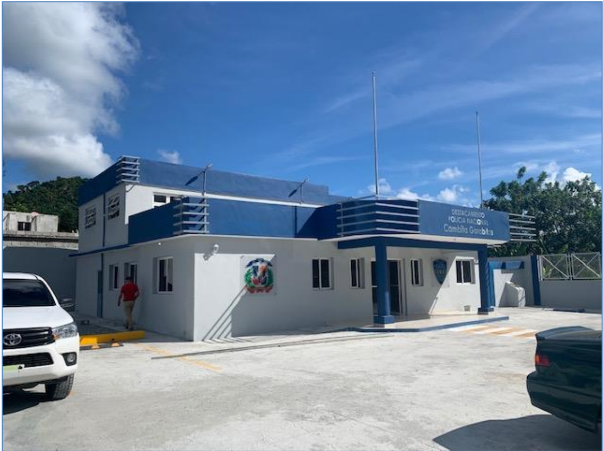
Vista General, Destacamento Cambita.
