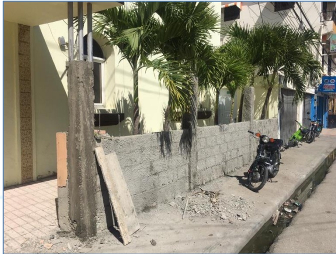
Construcción verja posterior, Iglesia Santa Lucía.
