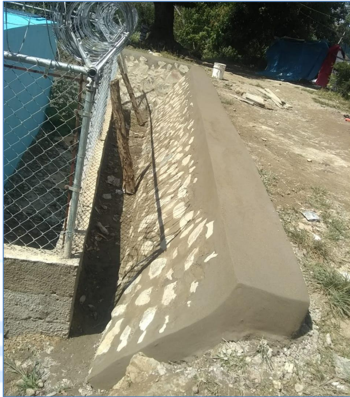
Terminación del encache en muro, Solución Agua Potable Vista Hermosa.
