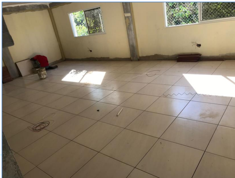
Colocación de cerámica primer nivel, Salón comunal Los Capacitos.
