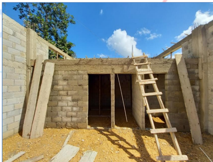
Desencofrado de losa de oficinas en almacén, Construcciones varias C.H. Rosa Julia de la Cruz.
