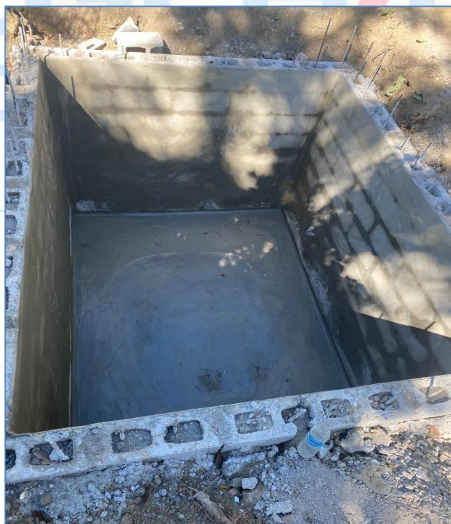
Colocación de bloques en cisterna, Terminación de capilla de Fátima.
