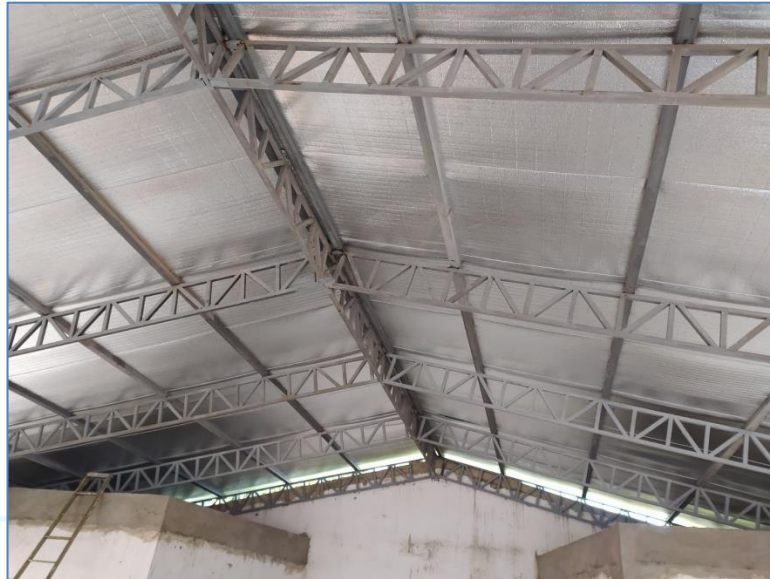
Estructura metálica en techo, Reparación Cancha Club la Salvia-Los Quemados.
