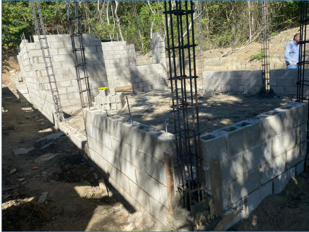
Colocación de bloques en cocina y baño, Terminación de capilla de Fátima.
